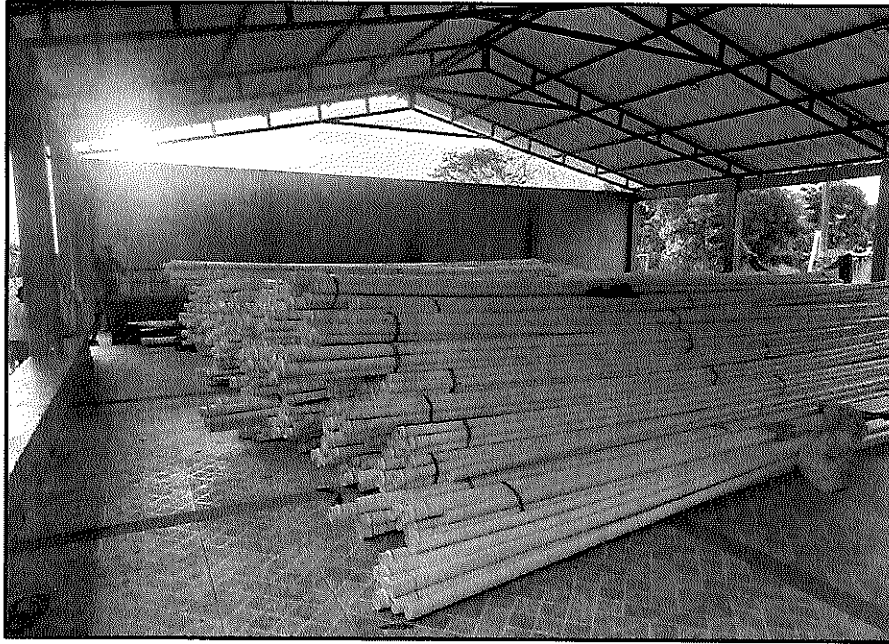
Imagen 1 Acopio de materiales en cubierta
