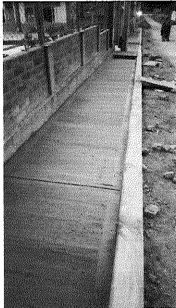
- Fotografía No. 7: CONSTRUCCION DE ANDENES E=0.10 M., EN CONCRETO DE 17.5 MPa - (2500 PSI)
