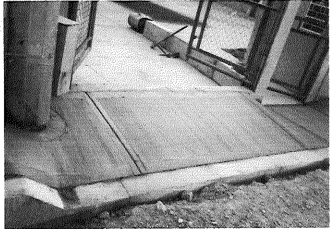
- Fotografía No. 8: CONSTRUCCION DE ANDENES E=0.10 M., EN CONCRETO DE 17.5 MPa - (2500 PSI)
