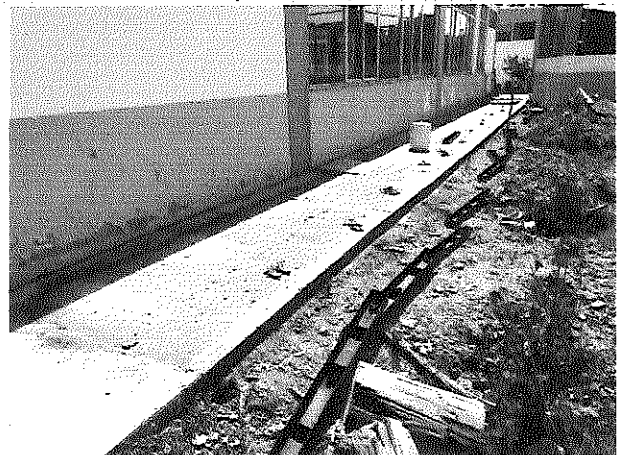
- Fotografía No. 8: CONSTRUCCION DE ANDENES E=0.10 M., EN CONCRETO DE 17.5 MPa - (2500 PSI)
