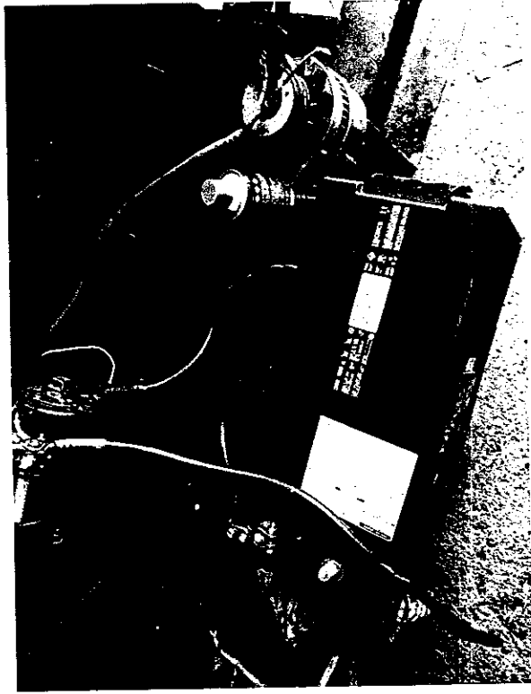
BATERIA A CAMBIAR POR CUMPLIMIENTO DEL CICLOBATERIA A CAMBIAR POR CUMPLIMIENTO DEL CICLO
