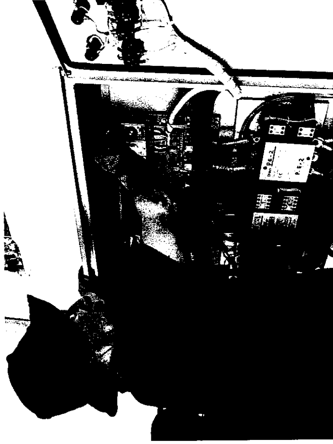
F - 3 AJUSTE TERMINALES DE LA TRANSFERENCIA
