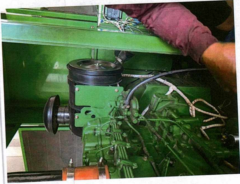
RETIRO FILTROS EXISTENTES PLANTA
