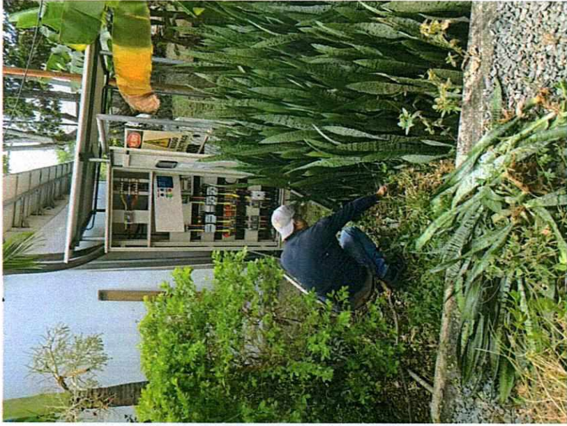
F - 4 LIMPIEZA AL SITIO DEL TABLERO
