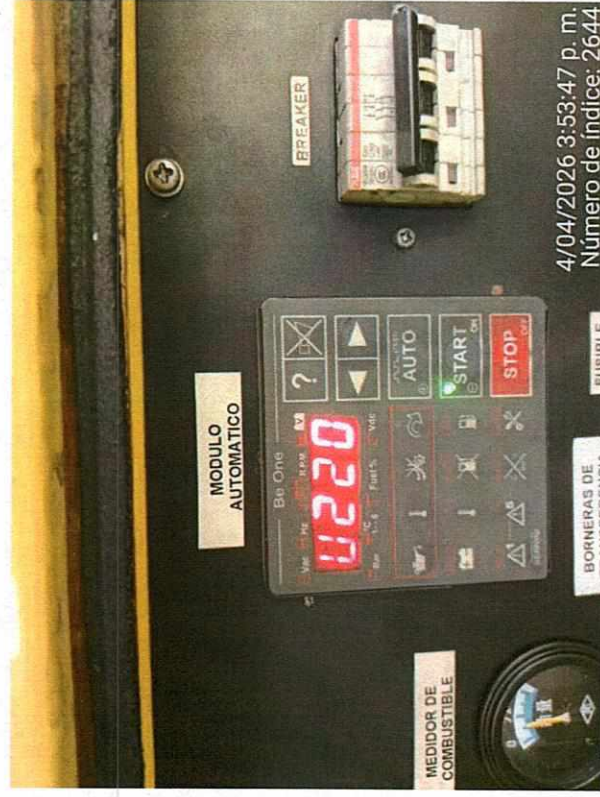
F - 12 MEDICION PARAMETROS ELECTRICOS
