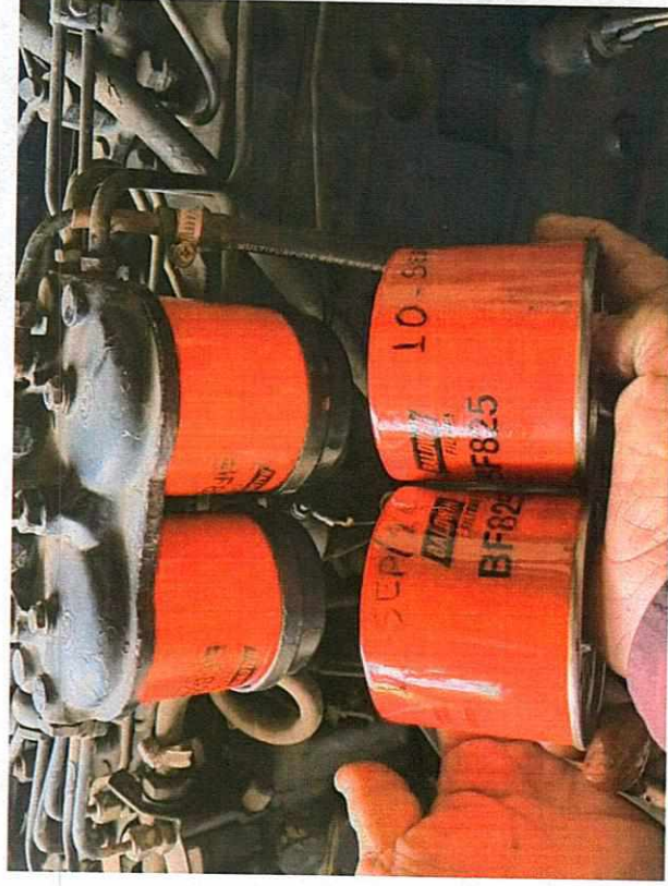
CAMBIO DE FILTROS COMBUSTIBLE
