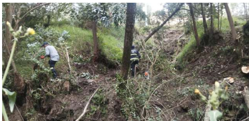
Fotografía 10. Limpieza quebrada Barbanica. Fuente: Brigada CAR.
