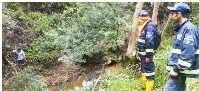
Fotografía 9. Limpieza quebrada Barbanica. Fuente: Brigada CAR.
