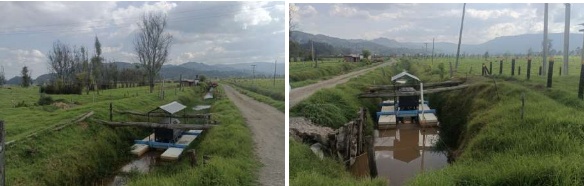
Fotografías 1 y 2. Estado actual de los canales sencillos. Fuente propia.
