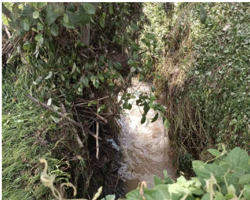
Fotografía 7. Estado actual de la quebrada Barbanica. Fuente propia.
