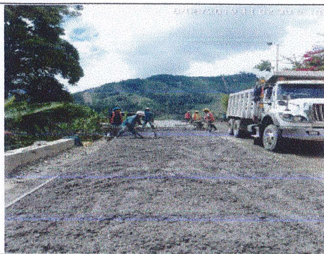
Concreto hidráulico losa k2+909
