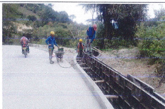
Fundida pared izquierda canal Pr 1+570
