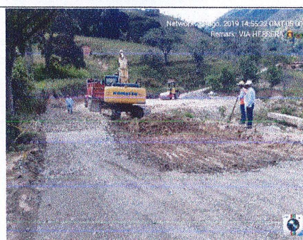
Se inician actividades de cajeo segundo tramo
