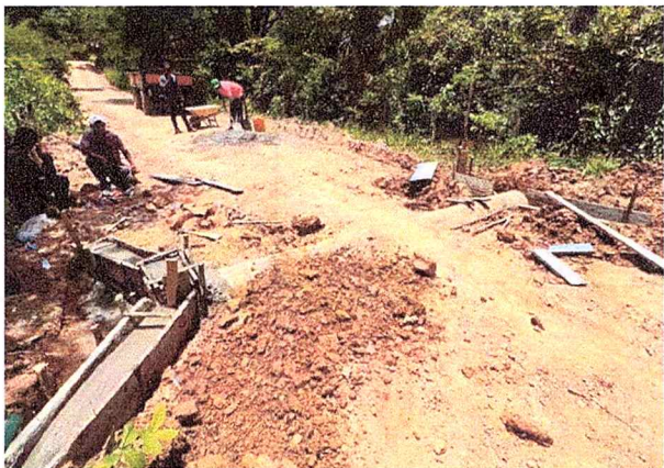
Fotografía 7. Construcción de obras de drenaje.
