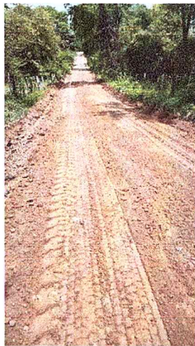
Fotografía 6. Relleno para capa de rodadura.
