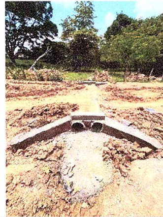
Fotografía 10. Construcción de obras de drenaje.
