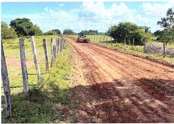
Fotografía 9. Compactación de subrasante.
