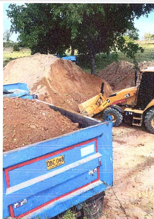
Fotografía 2. Cargue de material de relleno.
