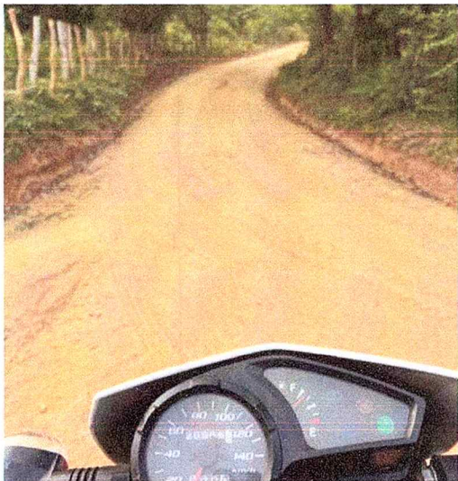
Fotografía 3. Tramos conformados y cuneteados.
