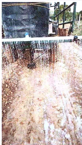
Fotografía 8. Aplicación de químico para estabilización de subrasante.
