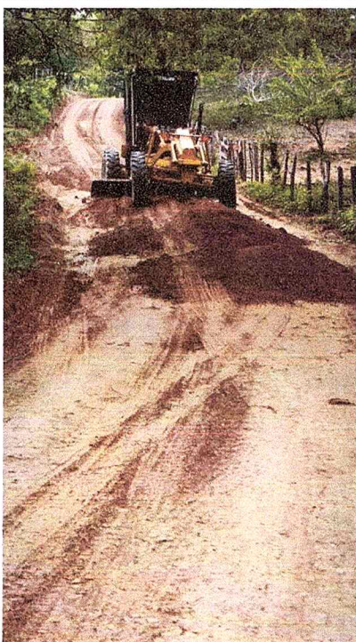
Fotografía 1. Extendida de material de relleno.
