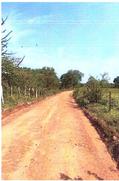
Fotografía 4. Tramo con relleno aplicado.
