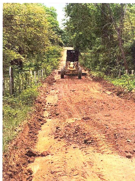
Ilustración 5. Trabajos de extendida de material de relleno.
