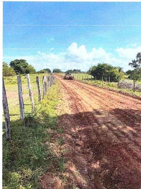
Ilustración 23. Compactación de terreno.
