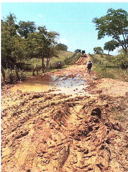
Ilustración 8. Afectaciones por lluvias.
