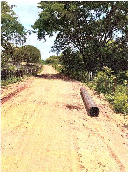
Ilustración 18. Suministro de tuberías para drenaje.
