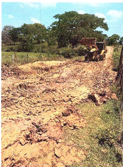
Ilustración 4. Início de las intervenciones en puntos críticos de la vía.
