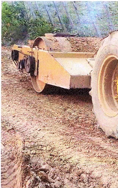
Ilustración 22. Compactación de terreno.
