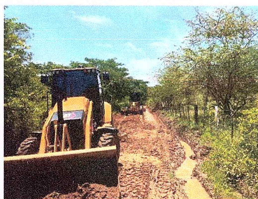
Ilustración 7. Trabajos de extendida de material de relleno
