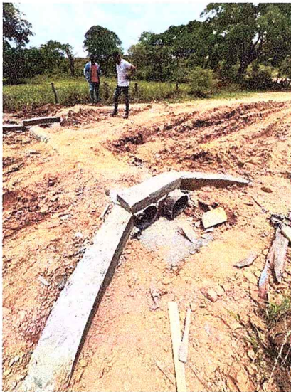
Ilustración 16. Construcción de obras de drenaje.
