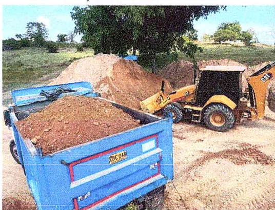
Ilustración 6. Cargue y transporte de material de relleno.
