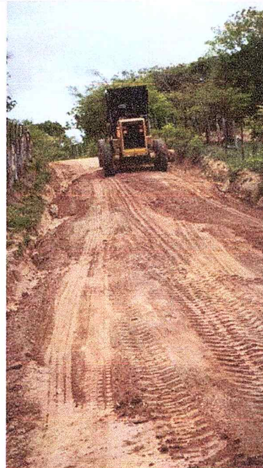
Ilustración 25. Terreno estabilizado y vía mejorada.
