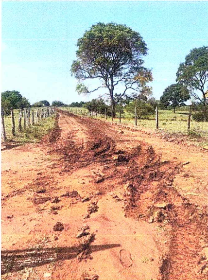
Ilustración 10. Afectaciones por lluvias.
