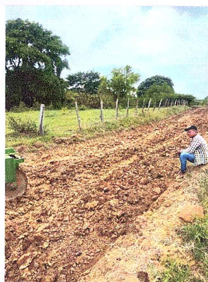
Ilustración 21. Escarificación de terreno para estabilización.
