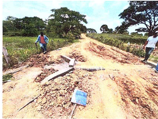
Ilustración 17. Construcción de obras de drenaje.
