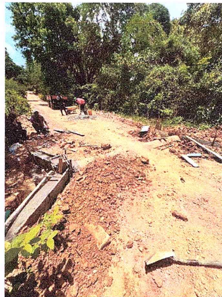
Ilustración 19. Construcción de obras de drenaje.
