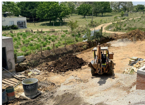
FOTO 6: Excavación para muro de contención para área de parqueadero parte inferior
