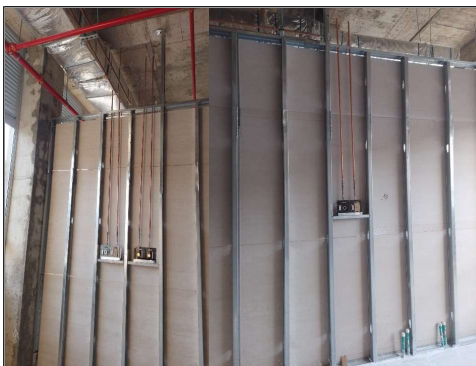
FOTO 2: Instalación de tomas de gases vacío y oxígeno
