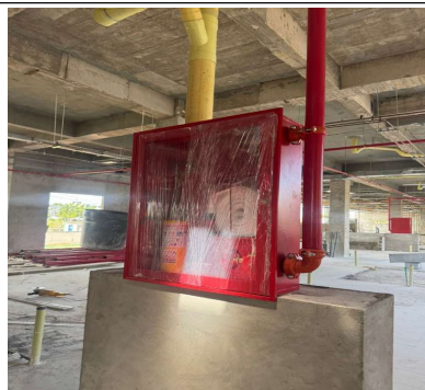
FOTO 16: Instalacion de gabinetes de red contra incendio
