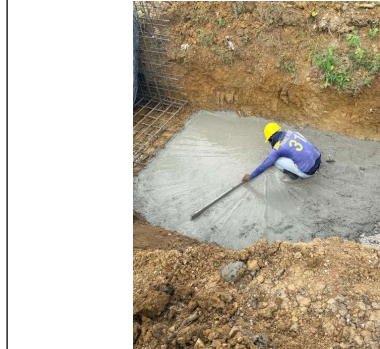
FOTO 9: Solado para zarpa de muro de contención
