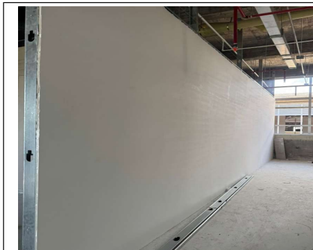
FOTO 15: Aplicado de estuco para muros internos de area de consultas externas
