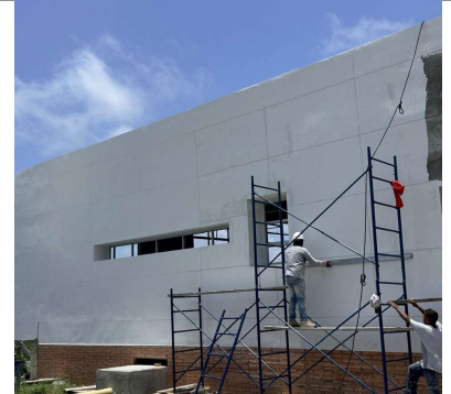
FOTO 21: Hechura de dilataciones para fachada
