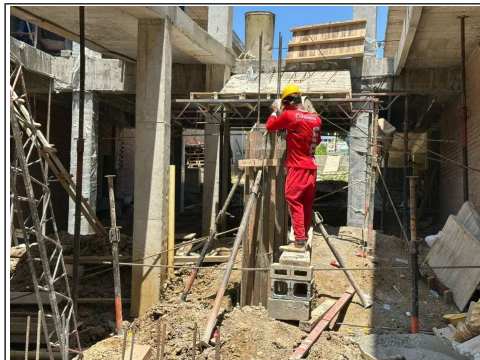
FOTO 12: Armado de acero para escalera auxiliar
