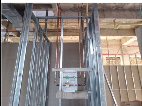
FOTO 1: Instalación de cajas de control de gases medicinales para el área de hospitalización
