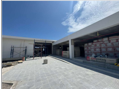
FOTO 20: Aplicación de estuco exterior para fachadas
