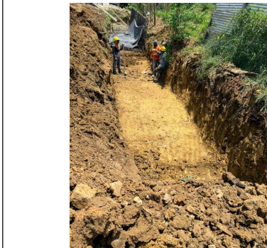
FOTO 8: Excavación de cimentación para muro de parqueadero
