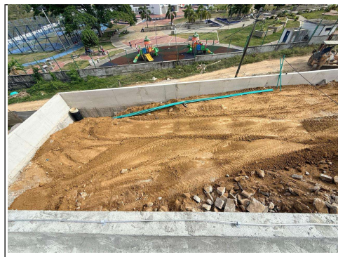
FOTO 3: Relleno para el área de acceso a urgencias
