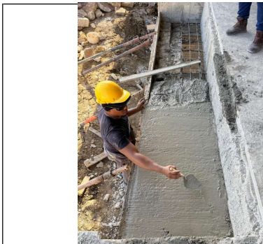
FOTO 5: Fundida de placa para área de urgencias
