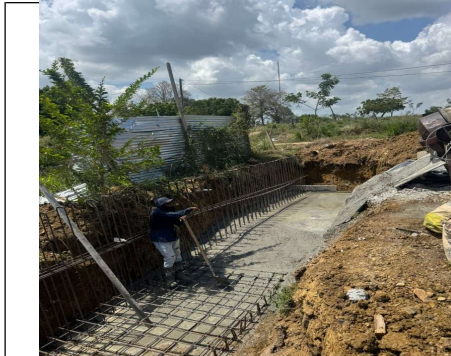
FOTO 18: Fundida de sarpa para muro de contencion
