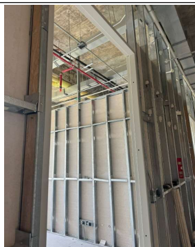
FOTO 13: Instalacion de puertas para bloque 3
