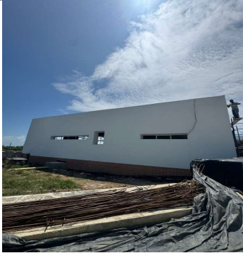
FOTO 19: Aplicación de estuco exterior para fachadas
