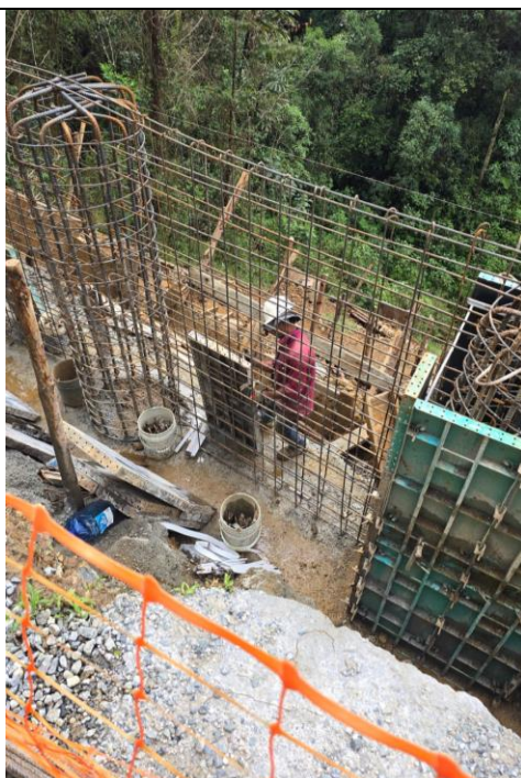
Imagen 3. Foto de tramos del muro sin vaciar
