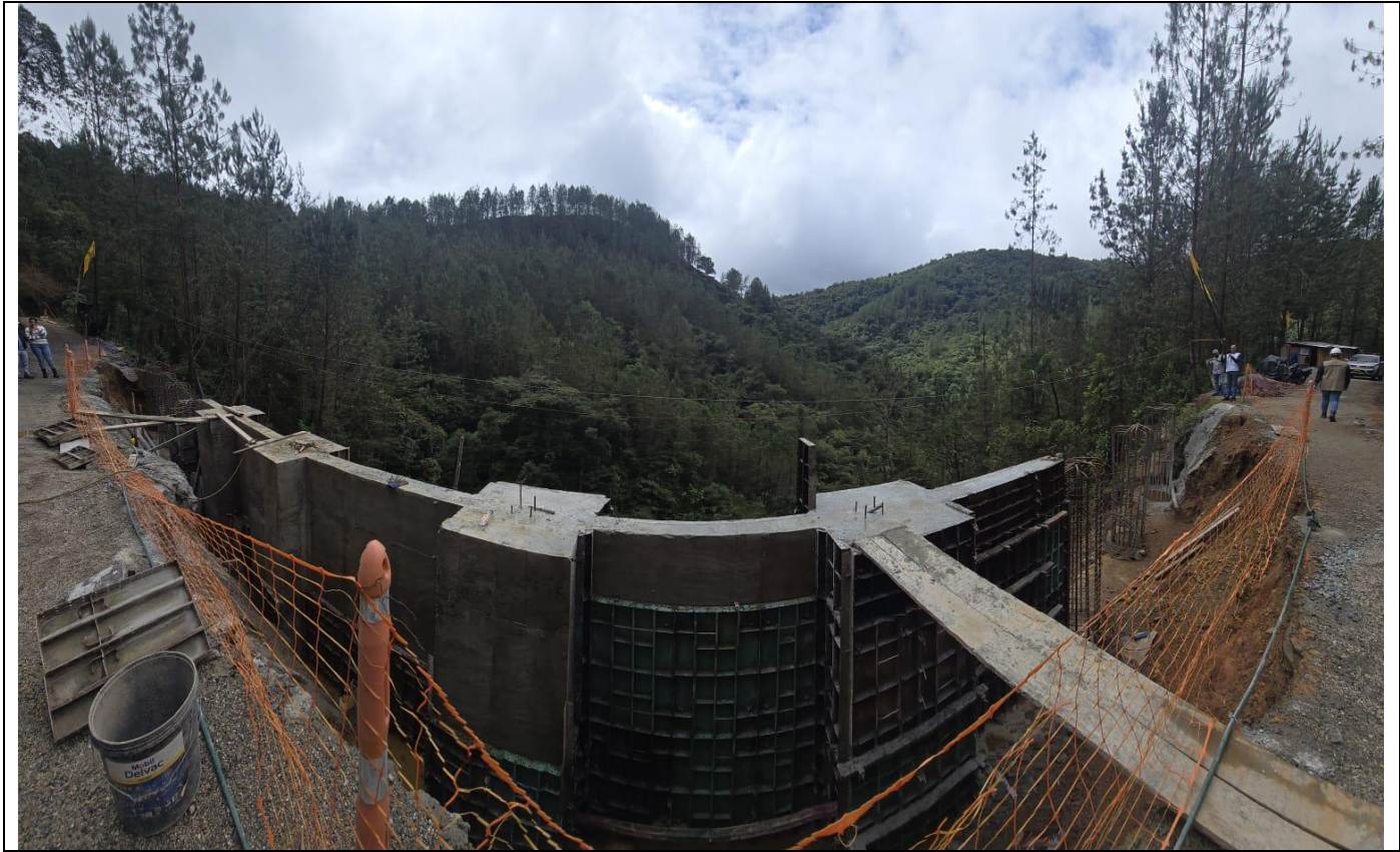
Imagen 1. Foto panorámica del muro
