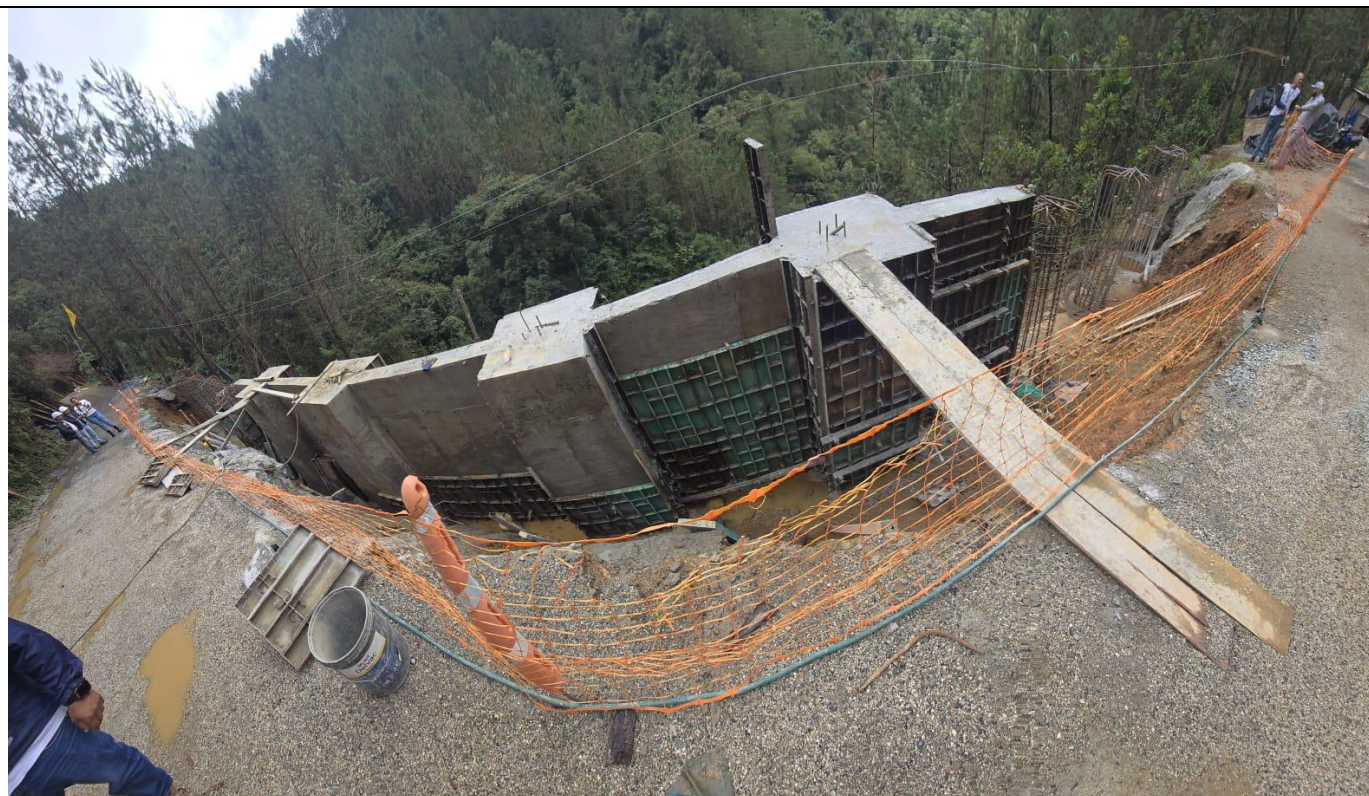
Imagen 2. Foto panorámica del muro
