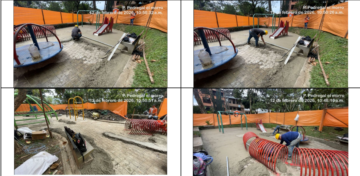
Avance de obra / Parque Pedregal (El Morro)
