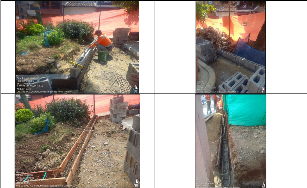
Avance de obra / Parque Recreativo Policarpa Salavarría
