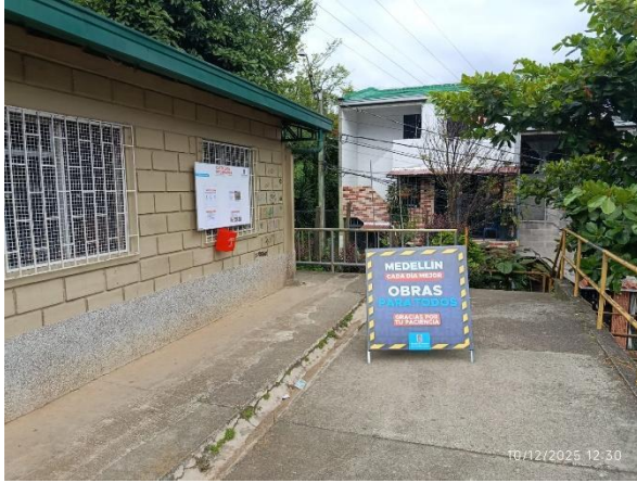
Foto 17. Cartelera, valla y buzón instalados
