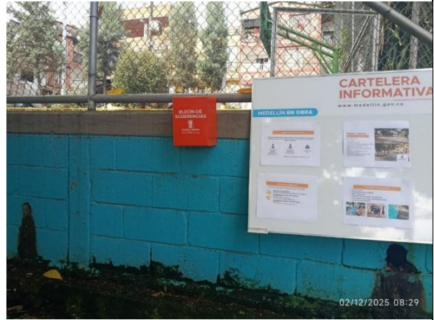
Foto 14. Cartelera y buzón instalados parque las Brisas.
