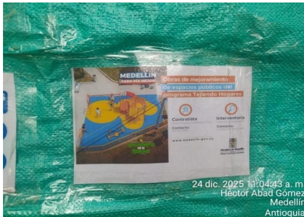
Foto 19. Aviso con información del proyecto instalado en la totalidad de frentes de obra
