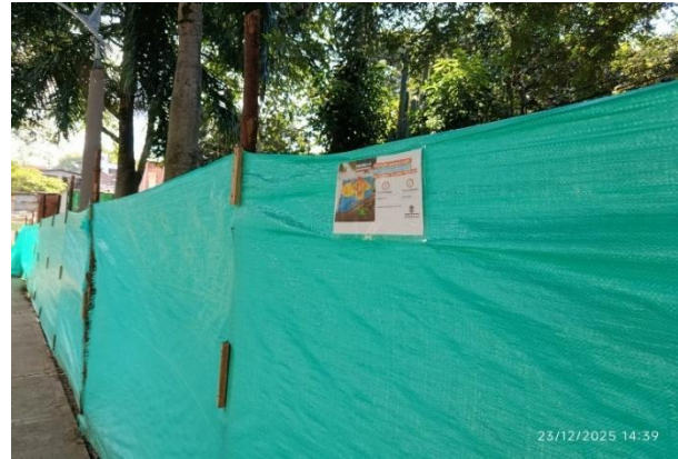
Foto 20. Aviso con información del proyecto instalado en la totalidad de frentes de obra
