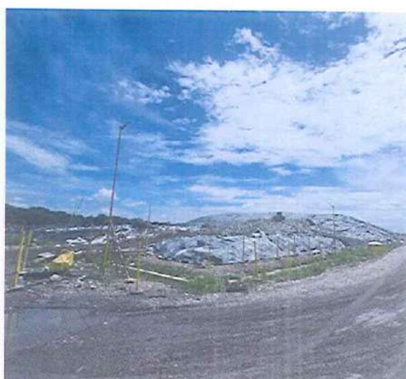
Registro fotográfico 26: Relleno Sanitario Parque Ecológico Reciclante.
