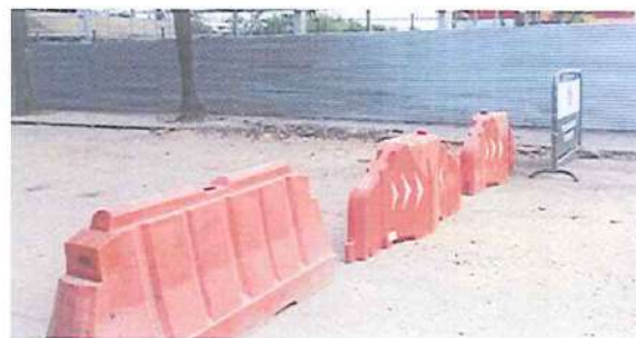
Barrera Rellenable y Cinta de demarcación
