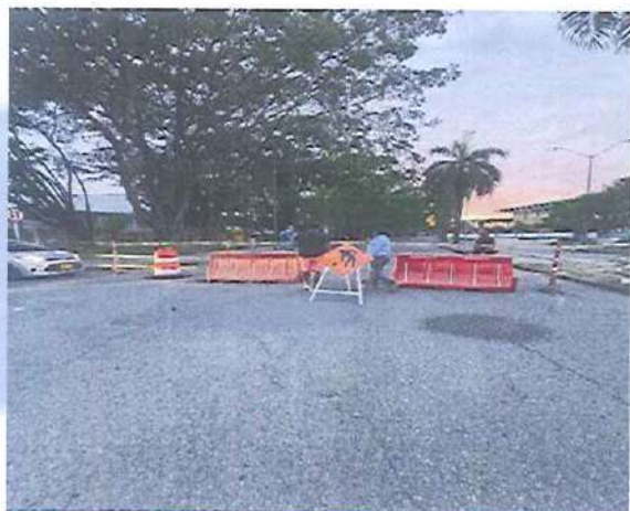
Registro fotográfico 1: Señalización.
