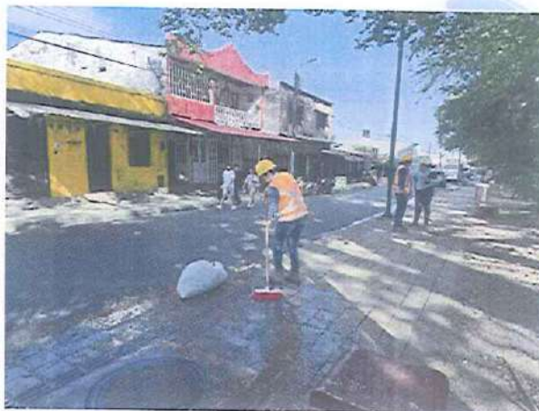
Registro fotográfico 20: Limpieza de vías y andenes.
