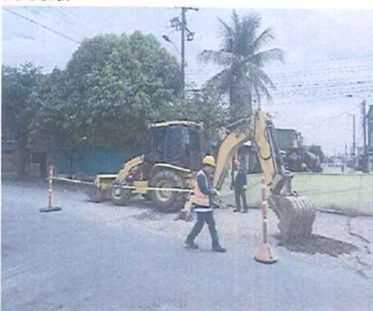
Registro fotográfico 14: Señalización frentes de obra.
