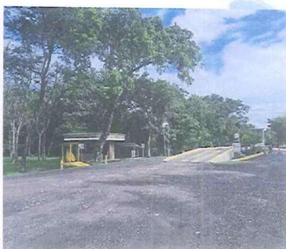
Registro fotográfico 24: Entrada al relleno Sanitario Parque Ecológico Reciclante.
