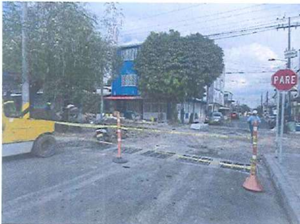
Registro fotográfico 13: Señalización frentes de obra.
