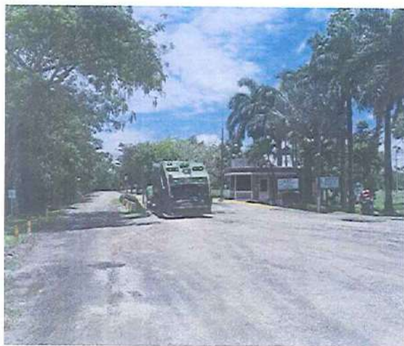
Registro fotográfico 23: Entrada al relleno Sanitario Parque Ecológico Reciclante.
