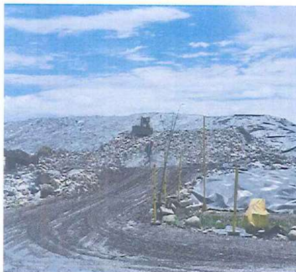
Registro fotográfico 25: Relleno Sanitario Parque Ecológico Reciclante.
