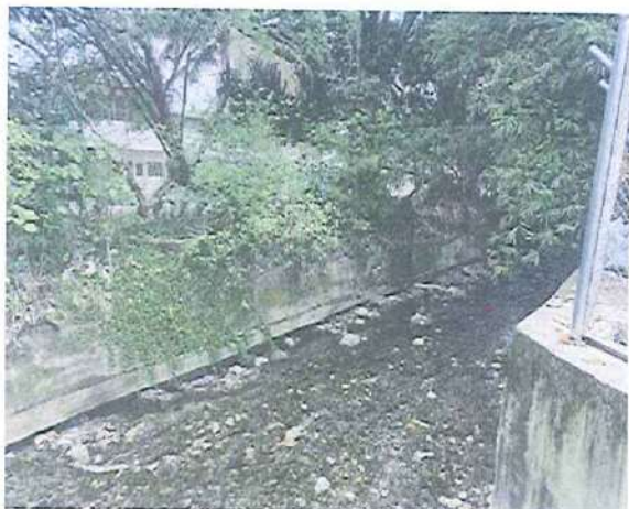
Registro fotográfico 31: Caño Maizaro a la altura del cabezal de descarga del alcantarillado pluvial.
