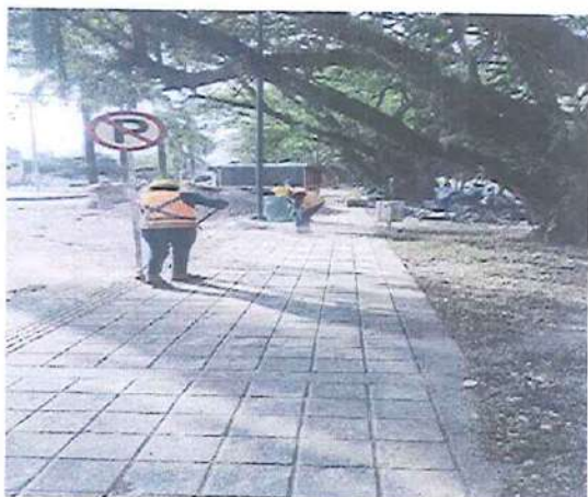
Registro fotográfico 19: Limpieza de vías y andenes.
