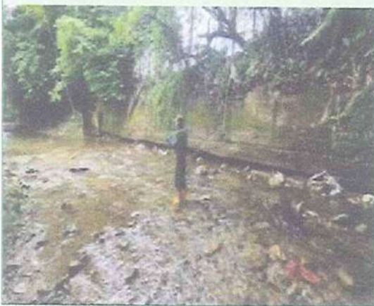
T.A. 53223- AGUAS ABAJO DEL VERTIMIENTO - CAÑO MAIZARO
