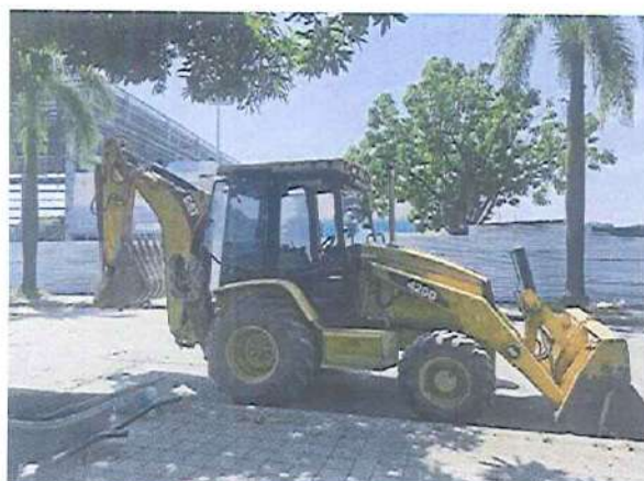
Registro fotográfico 49: Maquinaria, equipos y vehículos de la obra.
