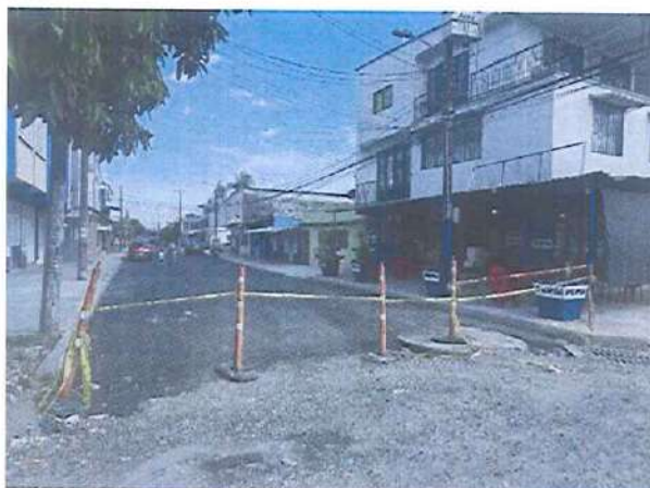
Registro fotográfico 11: Señalización frentes de obra.
