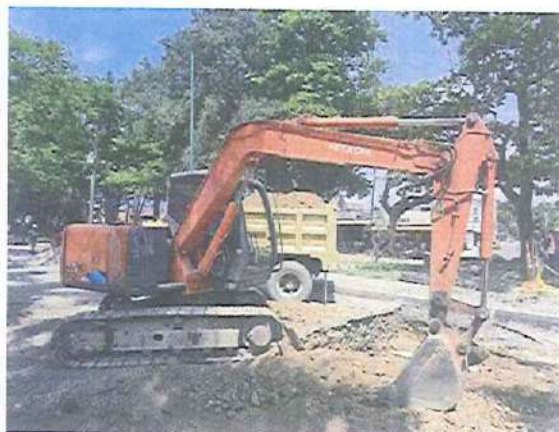
Registro fotográfico 50: Maquinaria, equipos y vehículos de la obra.
