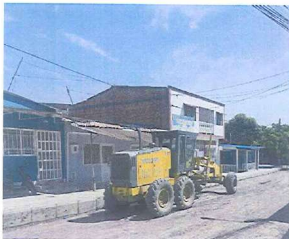
Registro fotográfico 53: Maquinaria, equipos y vehículos de la obra.
