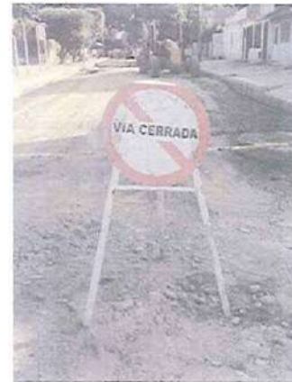
PMT (Señales Móviles) Vía Cerrada
