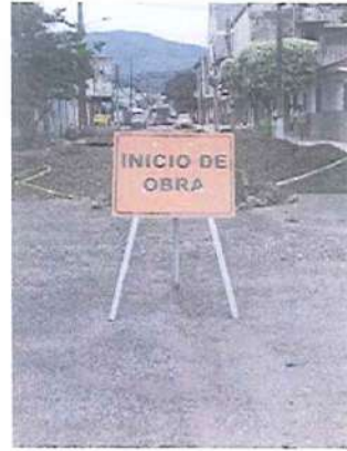
Inicio de Obra
