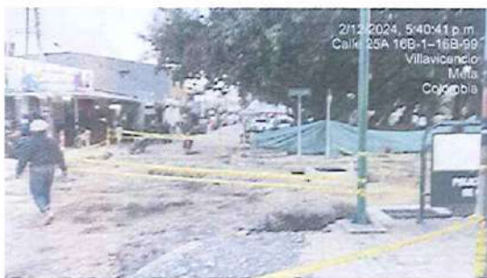
Cinta de demarcación, colombinas y auxiliares de tránsito.
