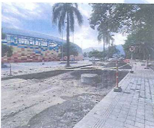
Registro fotográfico 12: Señalización frentes de obra.
