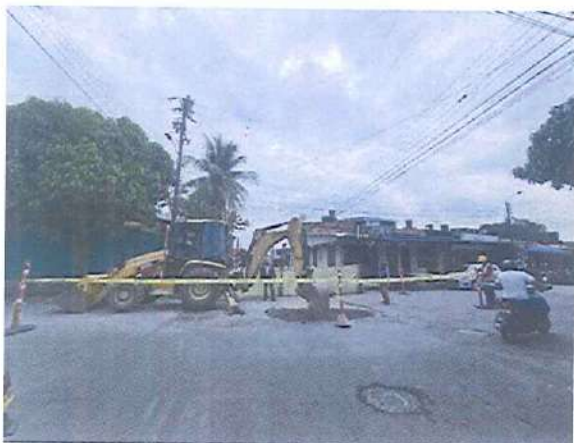
Registro fotográfico 3: Señalización.
