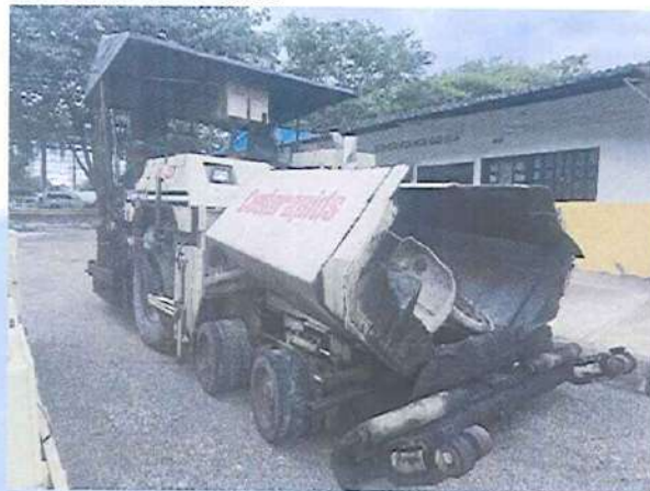
Registro fotográfico 51: Maquinaria, equipos y vehículos de la obra.
