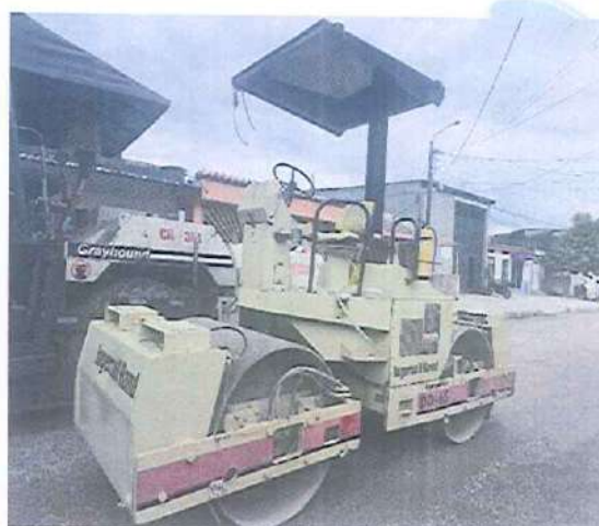
Registro fotográfico 54: Maquinaria, equipos y vehículos de la obra.
