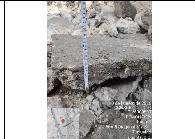
Foto 8. La demolición y remoción del material no superó los 10 cm de profundidad.
