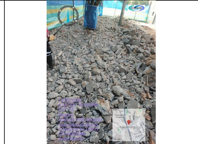
Foto 6. Actividad de demolición manual que nunca llegó a una profundidad que pudiese afectar la estabilidad del individuo arbóreo.
