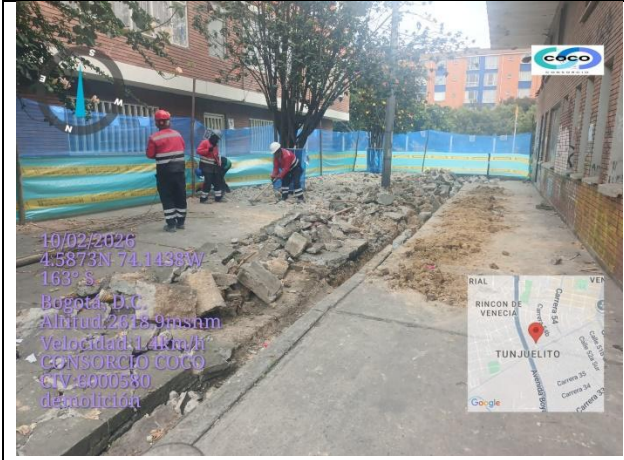
Foto 5. Actividades manuales previas, de demolición de andén de concreto, con la previa protección del individuo arbóreo.
