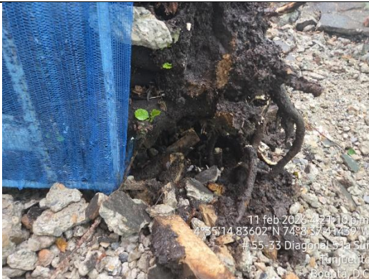
Foto 13. Detalle de la afectación radicular.
