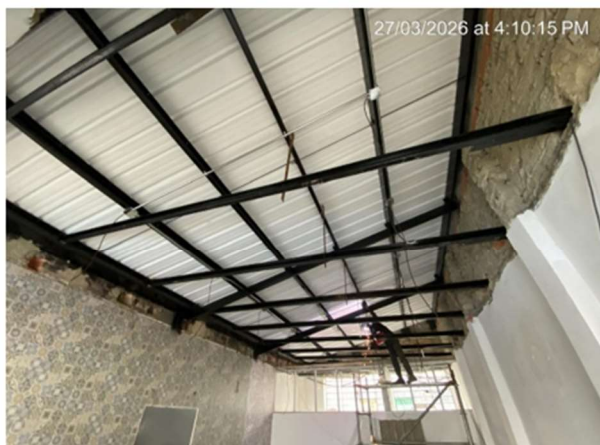
13. INSTALACIÓN ESTRUCTURA METÁLICA PARA CIELO RASO BLOQUES ADMINISTRATIVOS
