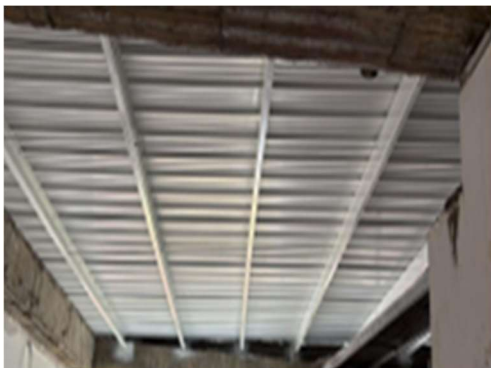
7. INSTALACION DE TENSORES
