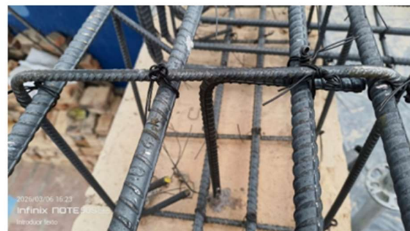
4. INSTALACIÓN DE ANCLAJES PARA VIGA CORONA
