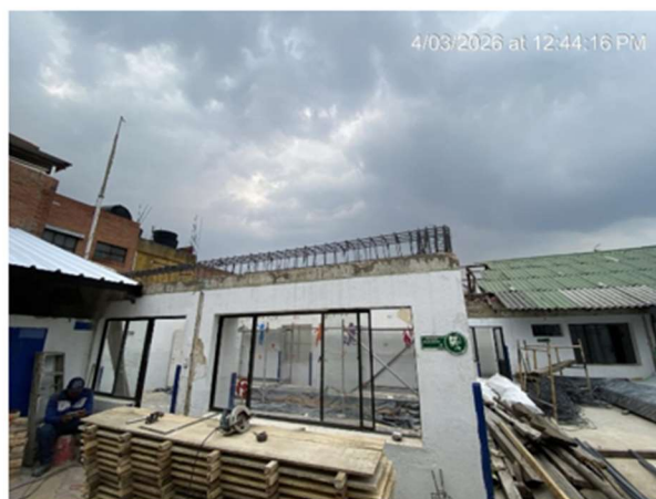
2. ARMADO ACERO LONGITUDINAL Y FLEJES VIGA CORONA
