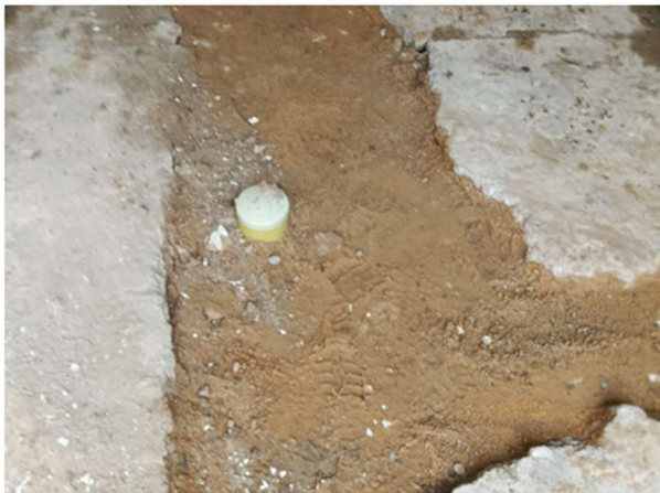
11. RELLENO TUBERÍA SANITARIA 4"
