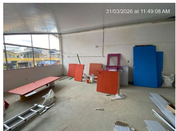
32. APLICACIÓN PINTURA PARA PUERTAS
