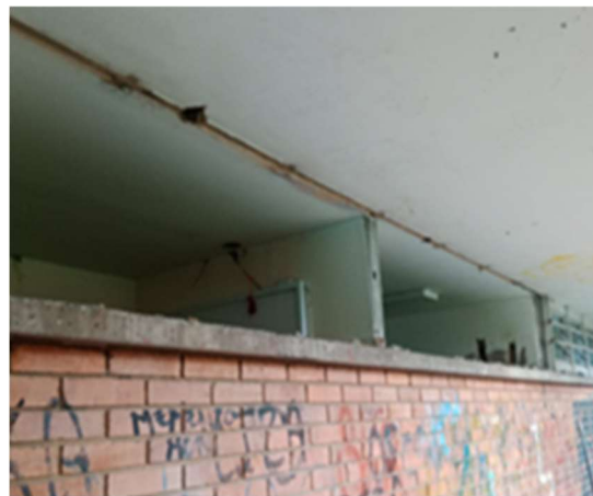
6. DEMOLICIÓN DE ENCHAPE DESMONTE DE VENTANAS METÁLICAS
