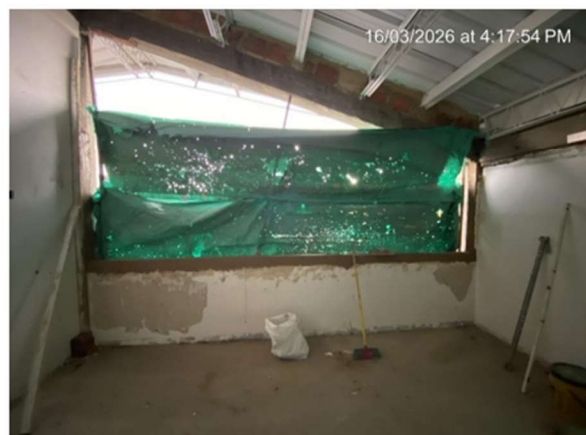
17. DESMONTE DE VENTANAS FACHADA SEGUNDO PISO
