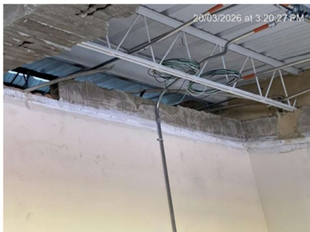
27. INSTALACIÓN CABLEADO PARA ILUMINACIÓN Y FUERZA
