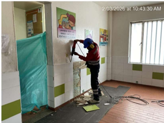
1. DEMOLICIÓN DE ENCHAFE DE MURO
