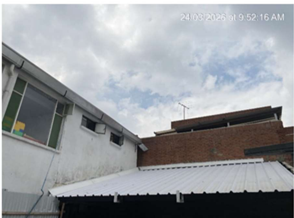
11. INSTALACIÓN DE FLANCHE CUBIERTA BAÑOS
