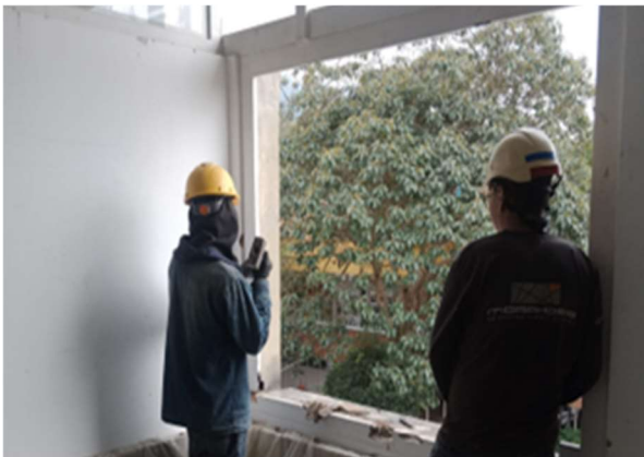
11. DESMONTE DE VENTANAS
