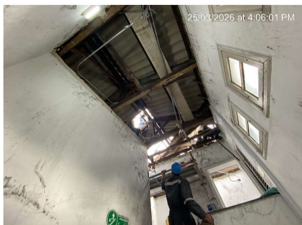
9. DESMONTE E INSTALACIÓN TEJAS ARCHIVO 2do PISO
