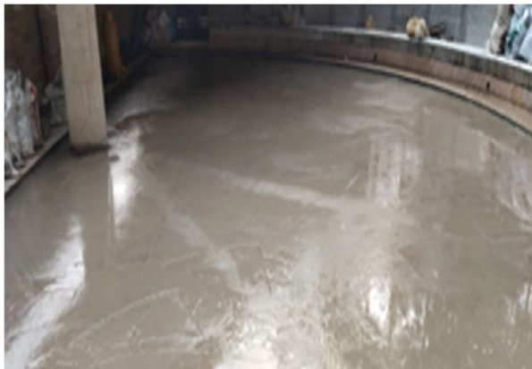
3. EJECUCIÓN DE SOBRE PISO
