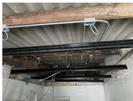
12. INSTALACIÓN ESTRUCTURA METÁLICA BAÑO DE HOMBRES SEGUNDO PISO
