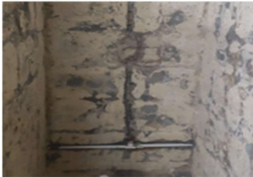
3. RETIRO DE TUBERÍAS HIDROSANITARIAS EXISTENTES
