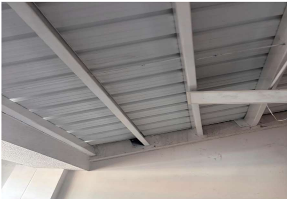
1. APLICACIÓN DE PINTURA ESMALTE SOBRE ESTRUCTURA METÁLICA DE CUBIERTA
