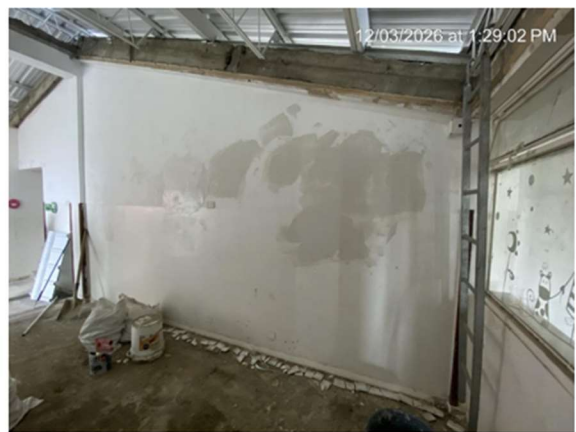
8. RESANE DE MUROS INTERNOS CON ESTUCO
