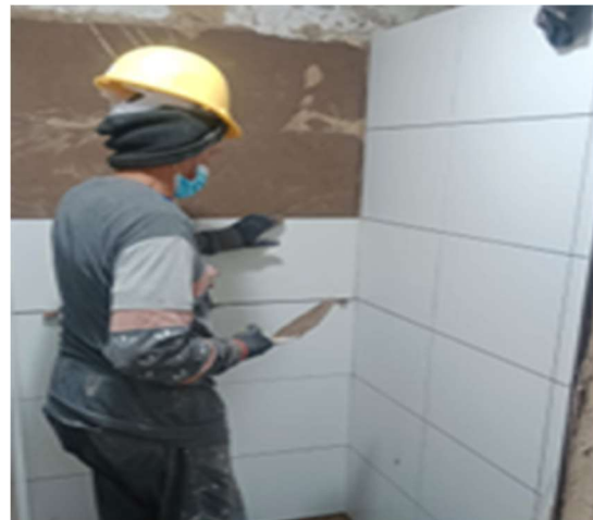
12. INSTALACION DE ENCHAPES
