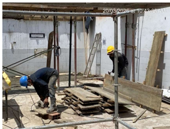
6. TESTERO PARA LA FUNDICIÓN DE LA VIGA CORONA
