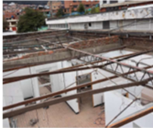
2. DESMONTE DE CERCHAS METÁLICAS
