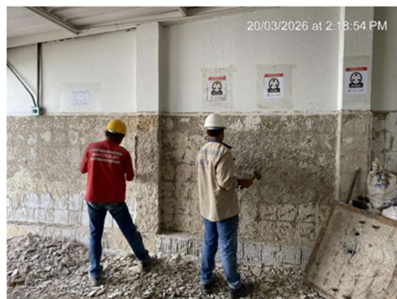
2. DESMONTE PAÑETE DE MUROS
