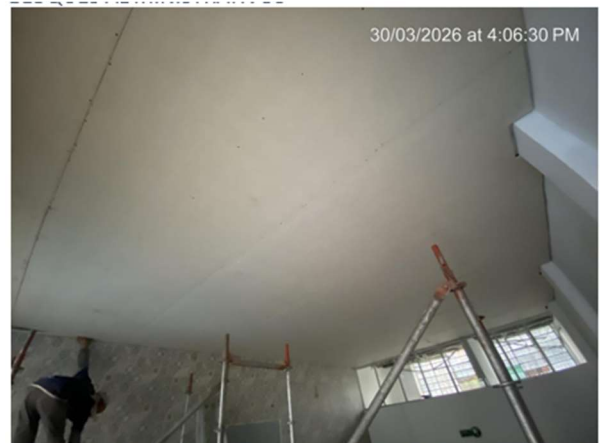
15. INSTALACIÓN CIELO RASO EN BLOQUE ADMINISTRATIVO
