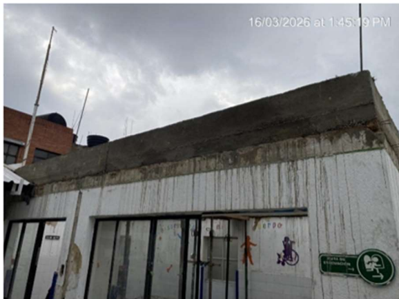
7. FUNDICIÓN DE VIGA CORONA EN CIERTOS SECTORES
