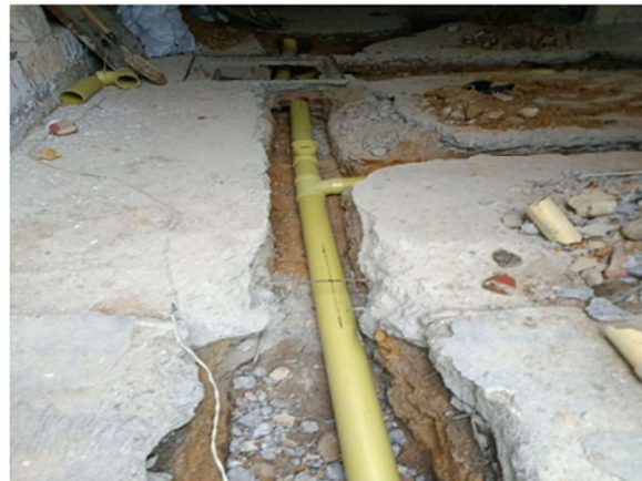
8. INSTALACIÓN TUBERÍA SANITARIA 4"
