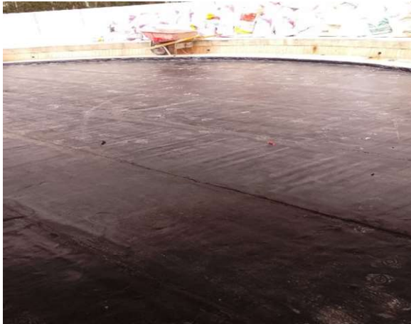
1. IMPERMEABILIZACIÓN DE TERRAZA
