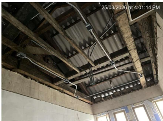
7. INSTALACIÓN TUBERÍA EMT Y CAJAS GALVANIZADAS BAÑO MUJERES 2do PISO
