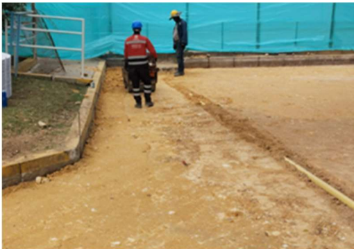
1. INSTALACIÓN DE REDES DE DESAGÜES
