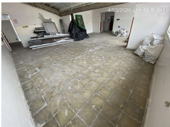
3. DESMONTE DE PISO EN VINILO
