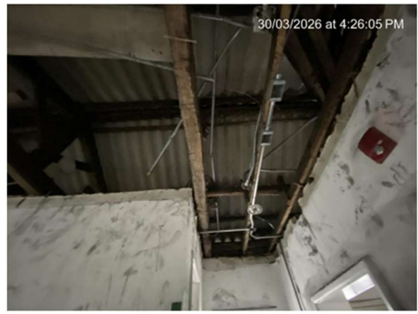
12. INSTALACIÓN TUBERÍA EMT Y CAJAS GALVANIZADAS ARCHIVO 2do PISO
