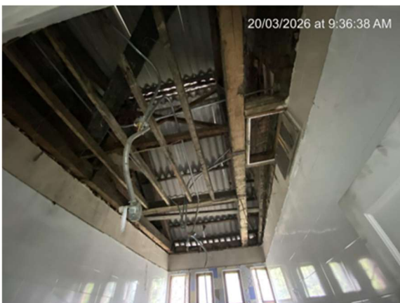
3. DESMONTE CIELO RASO EN ESTIRILLA MALLA BAÑO MUJERES 2do PISO
