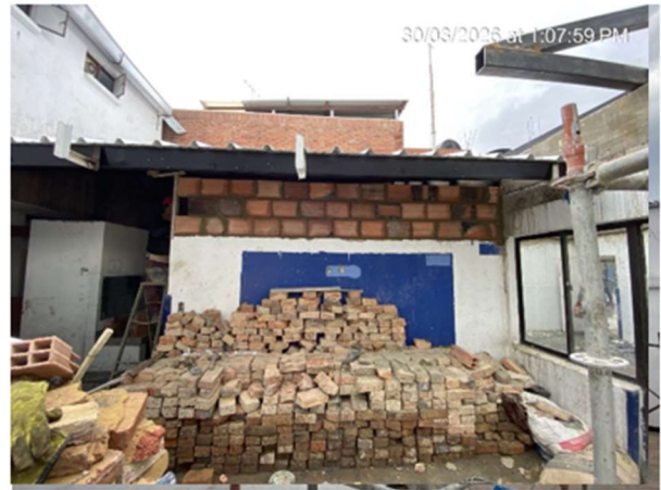
26. CONSTRUCCIÓN MURO MAMPOSTERÍA BAÑO
