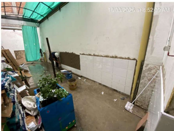
9. INSTALACIÓN ENCHAPE DE MURO
