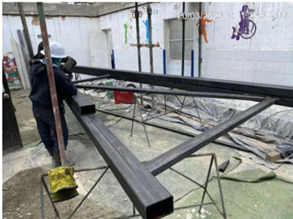
13. ARMADO ESTRUCTURA METÁLICA NUEVA CUBIERTO
