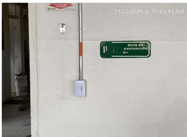
35. INSTALACIÓN INTERRUPTORES SEGUNDO PISO
