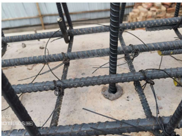
3. INSTALACIÓN DE ANCLAJES PARA VIGA CORONA
