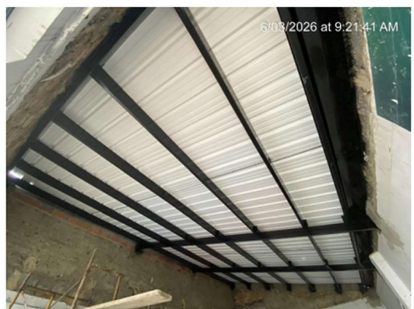
2. INSTALACIÓN DE CUBIERTA ECOROOF
