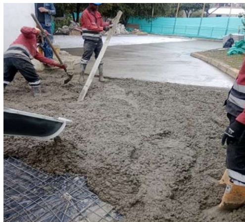
8. FUNDIDA DE PLACA DE PARQUEADERO
