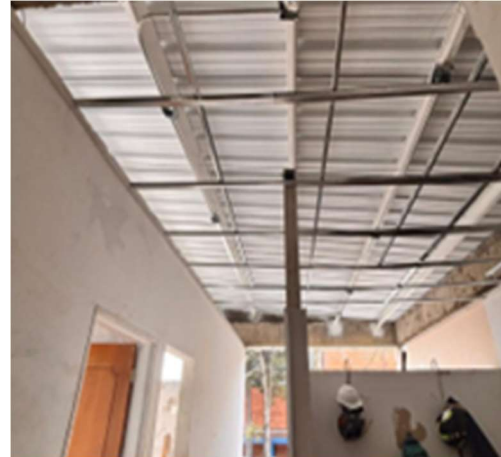
6. PINTURA CON ESMALTE PARA PERFILERÍA METÁLICA
