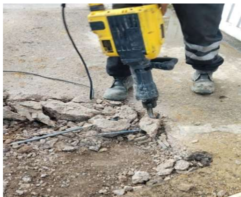
6. DEMOLICIÓN DE PLACA EXISTENTE
