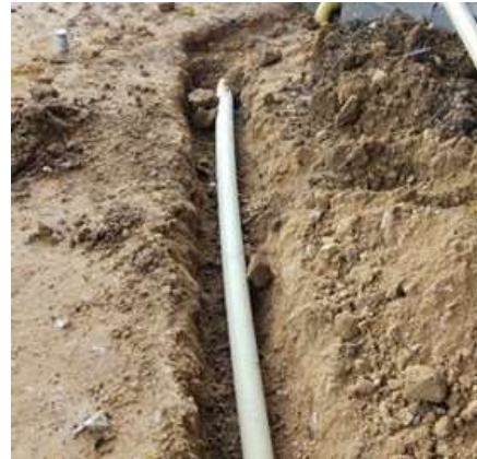
2. INSTALACION DE REDES DE SUMINISTRO
