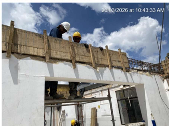
5. TESTERO PARA LA FUNDICIÓN DE LA VIGA CORONA
