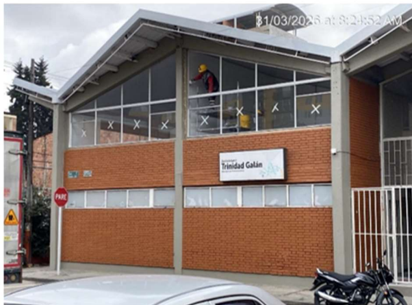
25. INSTALACIÓN DE VENTANERÍA FACHADA SEGUNDO PISO
