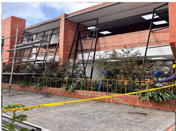
3. RETIRO DE VENTANAS DE FACHADA
