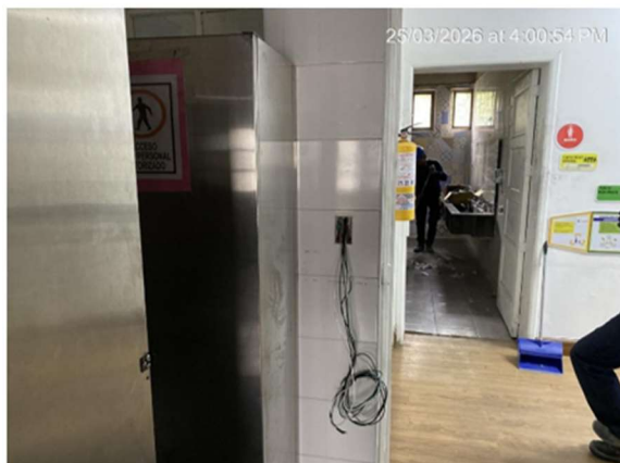
5. INSTALACIÓN CABLEADO PARA ILUMINACIÓN BAÑOS 2do PISO
