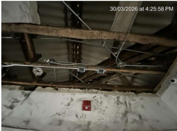
11. INSTALACIÓN TUBERÍA EMT Y CAJAS GALVANIZADAS ARCHIVO 2do PISO
