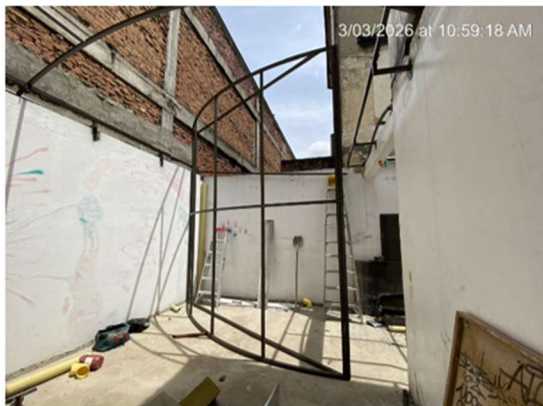
3. DESMONTE ESTRUCTURA DE CUBIERTA
