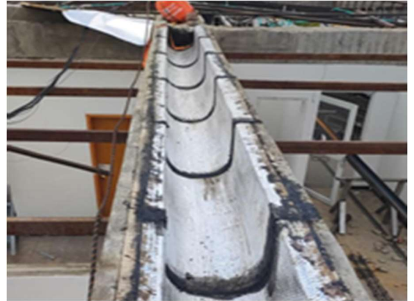
10. IMPERMEABILIZACIÓN DE VIGAS CANALES
