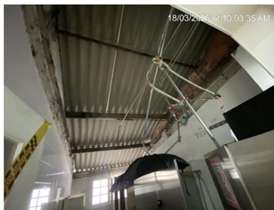
2. DESMONTE E INSTALACIÓN TEJAS BAÑOS 2do PISO
