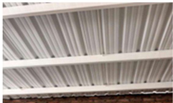
8. INSTALACION DE CUBIERTA
