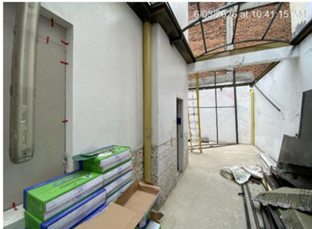
13. INSTALACIÓN DE BAJANTES ÁREA PATIOS
