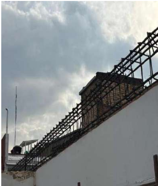
AMARRE DE HIERRO VIGA PERIMETRAL PARA APOYO DE CUBIERTA
