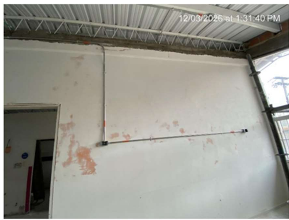
16. INSTALACIÓN TUBERÍA EMT Y CAJAS GALVANIZADAS
