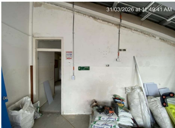
33. INSTALACIÓN TOMACORRIENTES SEGUNDO PISO
