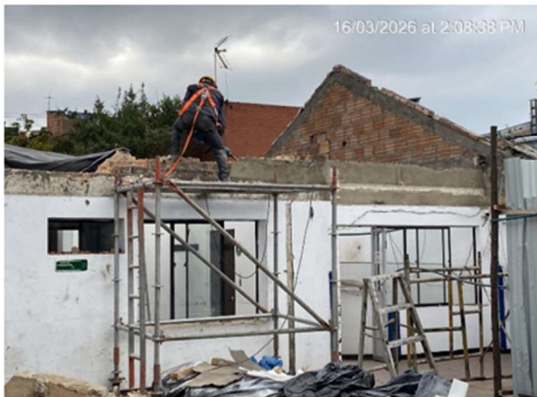
15. DEMOLICIÓN DE MUROS PARA LLEGAR NIVEL DESEADO
