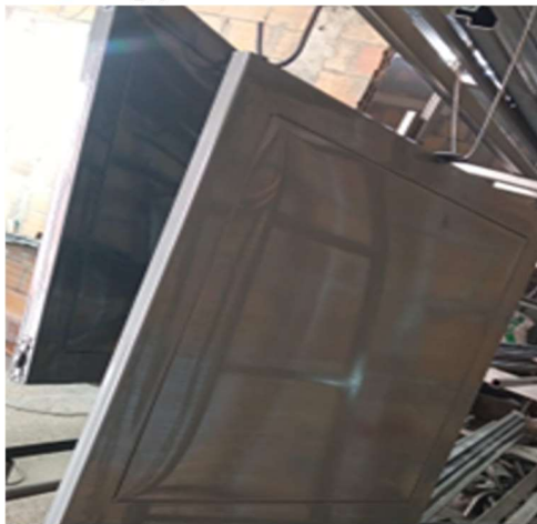
7. CAMBIO DE PUERTA METÁLICA EN CUARTO DE BOMBAS
