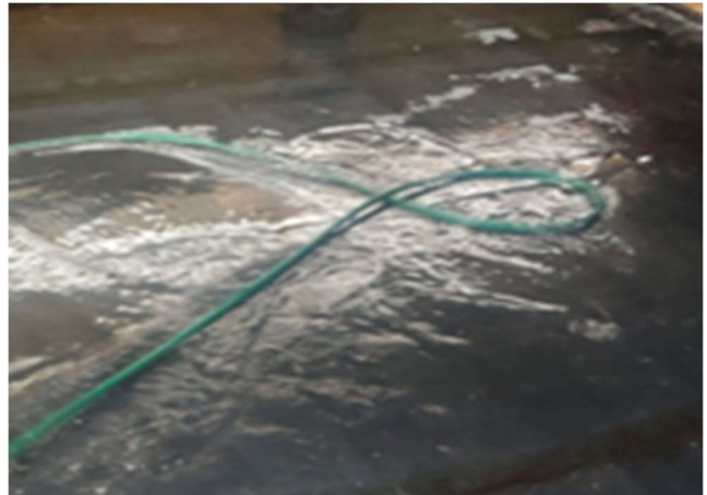
2. PRUEBA DE ESTANQUEIDAD
