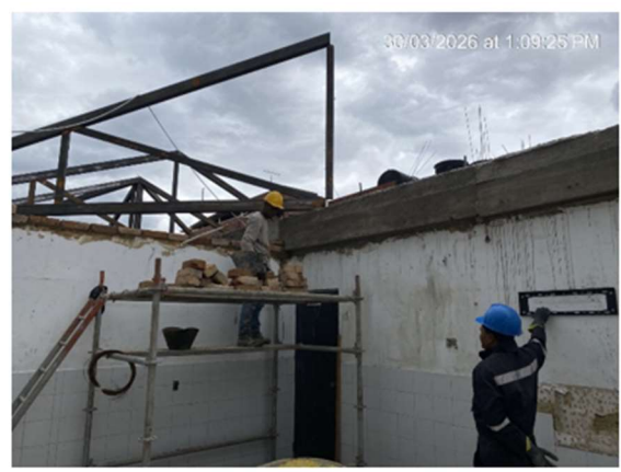
24. NIVELACIÓN DE VIGA CORONA CON MAMPOSTERÍA
