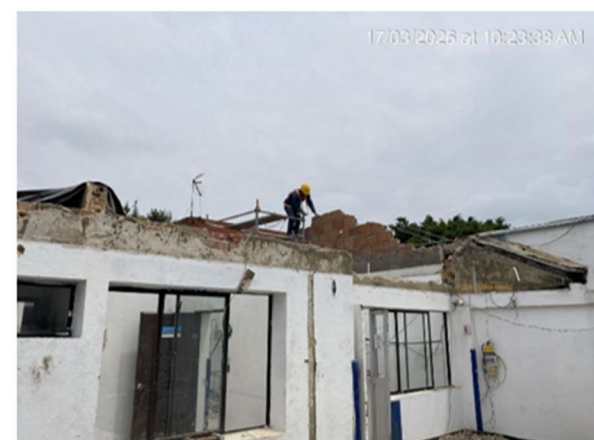
17. DEMOLICIÓN DE VIGA CONCRETO PARA NIVEL DESEADO
