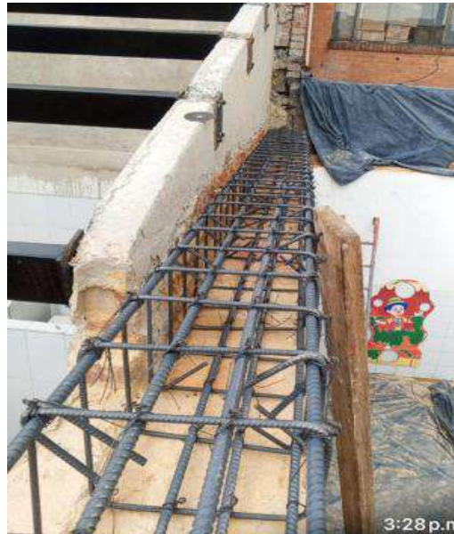
AMARRE DE HIERRO VIGA PERIMETRAL PARA APOYO DE CUBIERTA
