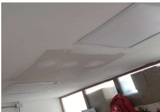
9. TAPADO PINTURA EN CIELO RASO DONDE SE CAMBIÓ LA ILUMINACIÓN
