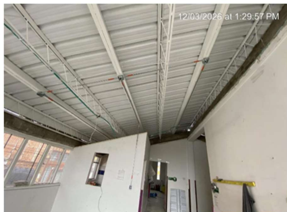
15. INSTALACIÓN TUBERÍA EMT Y CAJAS GALVANIZADAS
