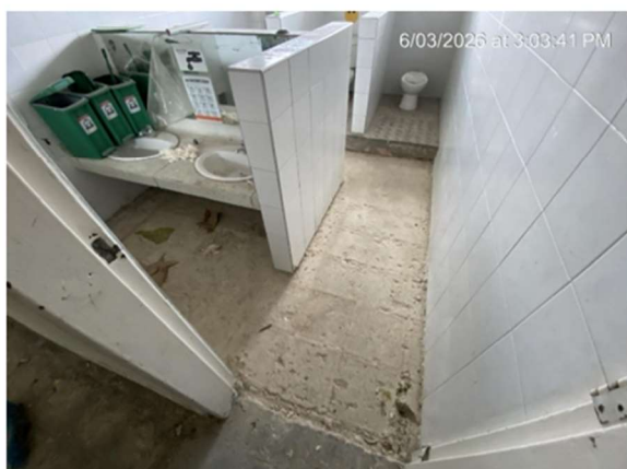
5. DEMOLICIÓN DE ENCHAPE DE PISO
