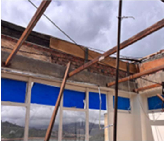
3. DESMONTE ESTRUCTURA LIVIANA
