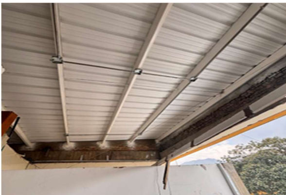
13. TENDIDO DE TUBERÍA EMT PUNTOS PARA ILUMINACIÓN Y TOMAS
