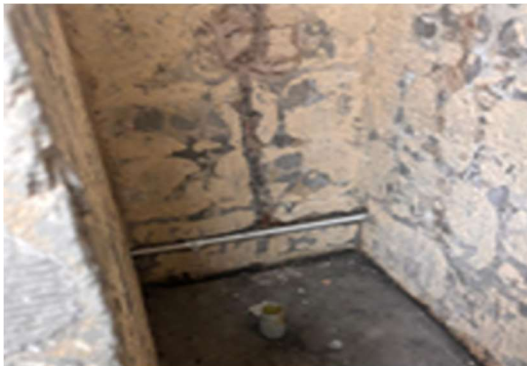
4. INSTALACION DE TUBERÍA SANITARIA
