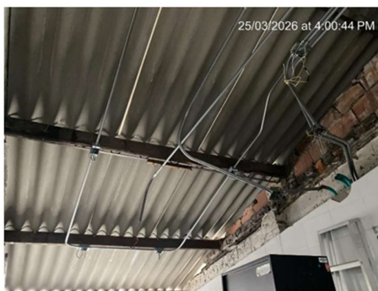
4. INSTALACIÓN TUBERÍA EMT Y CAJAS GALVANIZADAS BAÑO HOMBRES 2do PISO
