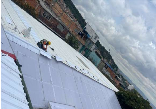
9. INSTALACION DE CABALLETE
