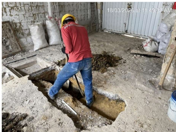
7. EXCAVACIÓN PARA PUNTOS SANITARIOS
