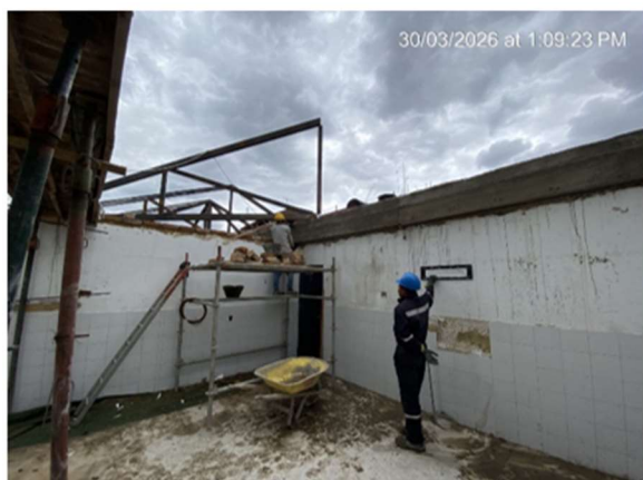
23. NIVELACIÓN DE VIGA CORONA CON MAMPOSTERÍA
