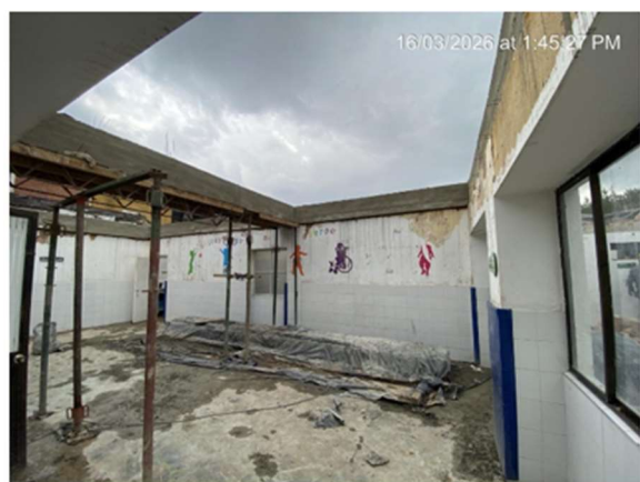
8. FUNDICIÓN DE VIGA CORONA EN CIERTOS SECTORES
