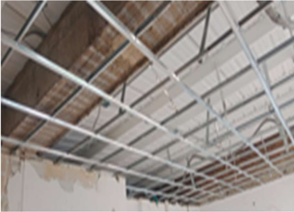
9. INSTALACION DE ESTRUCTURA PARA DRYWALL
