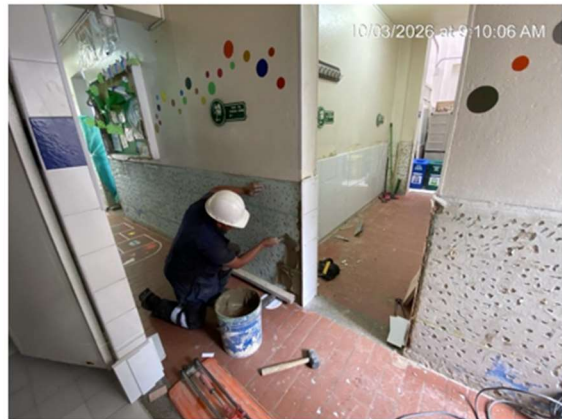
8. INSTALACIÓN ENCHAPE DE MURO
