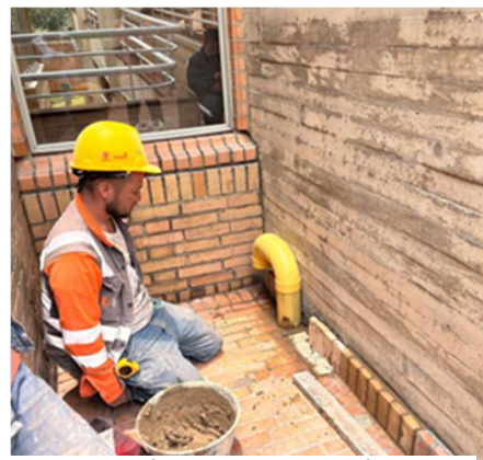
6. PERFORACIÓN PARA VENTILACIÓN DE TANQUE
