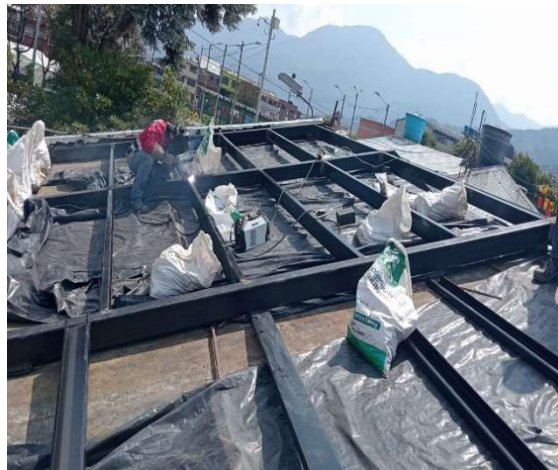
4. INSTALACION DE NUEVA ESTRUCTURA PARA CUBIERTA
