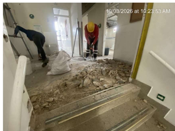
10. DEMOLICIÓN DE SOBREPISO ÁREA HALL
