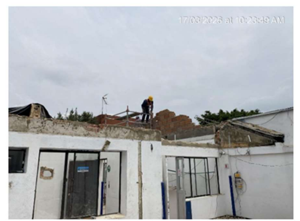
18. DEMOLICIÓN DE VIGA CONCRETO PARA NIVEL DESEADO
