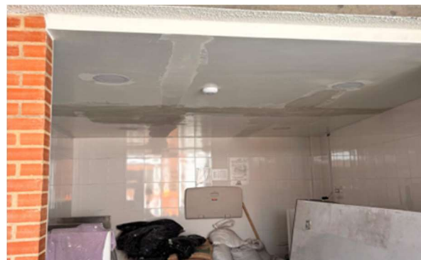
10. TAPADO PINTURA EN CIELO RASO DONDE SE CAMBIÓ LA ILUMINACIÓN
