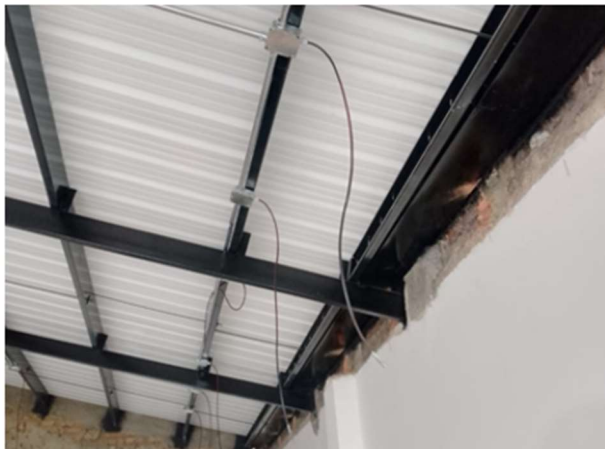
17. INSTALACIÓN DE CABLEADO PARA ILUMINACIÓN BLOQUES ADMINISTRATIVOS
