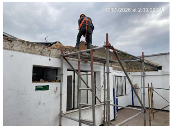
14. DEMOLICIÓN DE MUROS PARA LLEGAR NIVEL DESEADO
