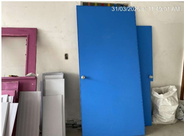
31. APLICACIÓN PINTURA PARA PUERTAS
