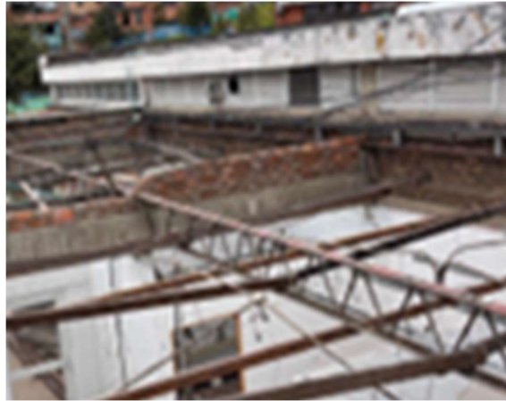
4. DESMONTE DE CERCHAS METÁLICAS
