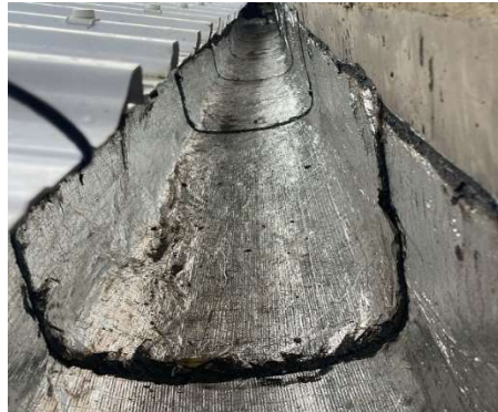
10. CAMBIO DE IMPERMEABILIZACIÓN
