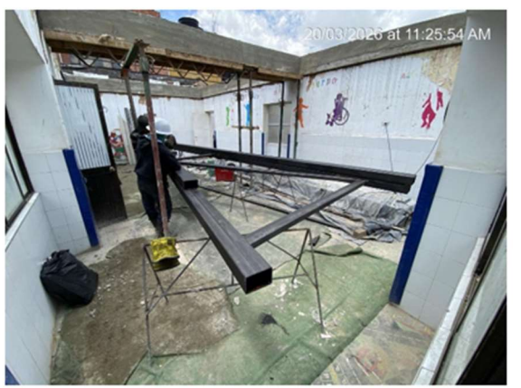
12. ARMADO ESTRUCTURA METÁLICA NUEVA CUBIERTA
