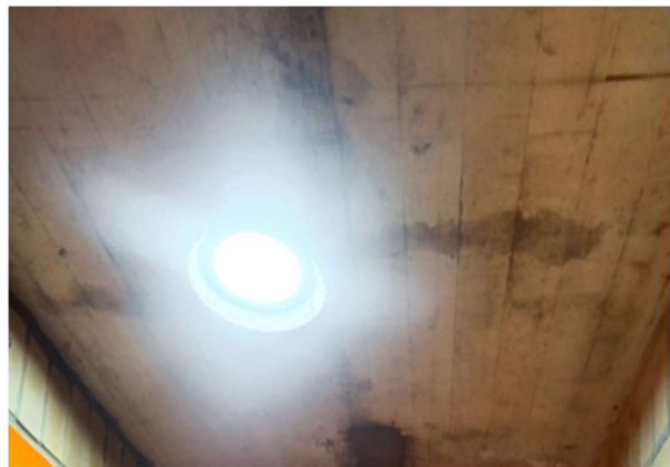
4. REPARACIÓN DE FILTRACIÓN EN TERRAZA DEL SEGUNDO PISO
