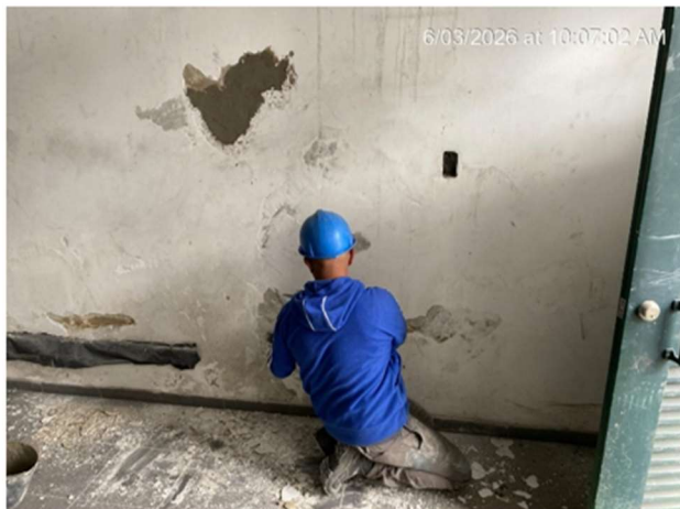
3. RESANE DE MUROS
