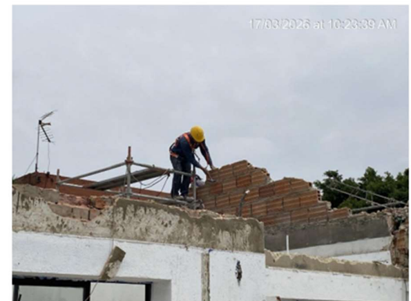
16. DEMOLICIÓN DE MUROS PARA LLEGAR NIVEL DESEADO
