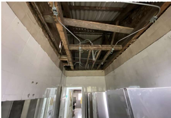
9. INSTALACIÓN CABLEADO ILUMINACIÓN BAÑO MUJERES 2do PISO
