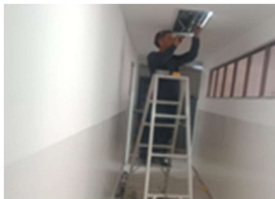
6. INSTALACIÓN DE LÁMPARAS
