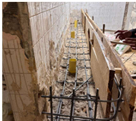
10. CONSTRUCCIÓN LAVAMANOS EN CONCRETO
