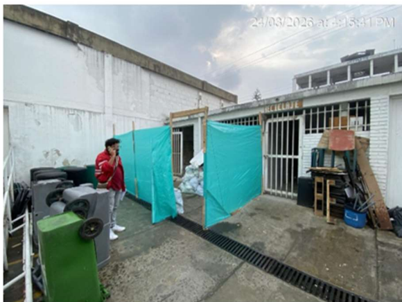
1. INSTALACIÓN CERRAMIENTO EN POLISOMBRA
