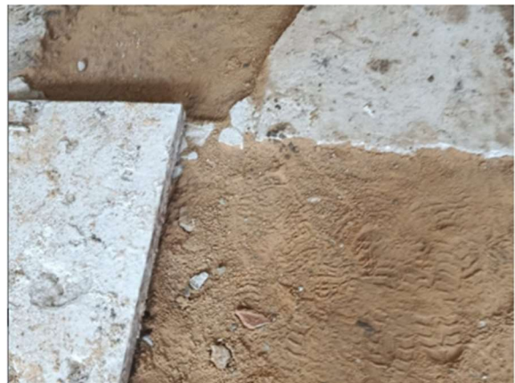
10. RELLENO TUBERÍA SANITARIA 4"
