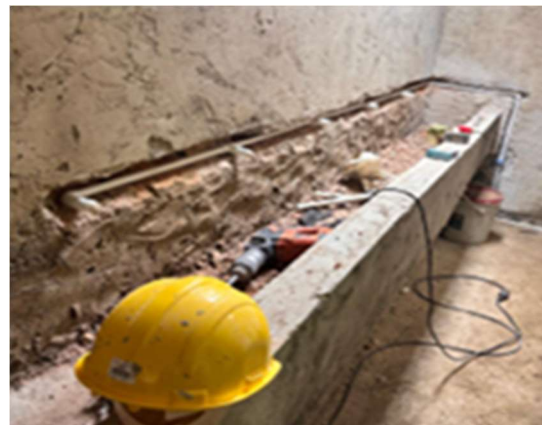
8. INSTALACION DE REDES HIDROSANITARIAS
