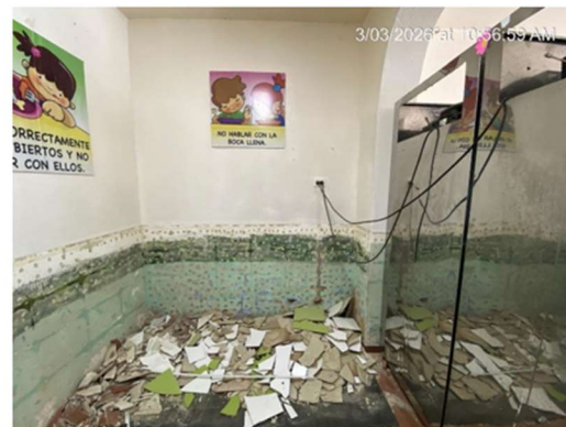
2. DEMOLICIÓN DE ENCHAFE DE MURO
