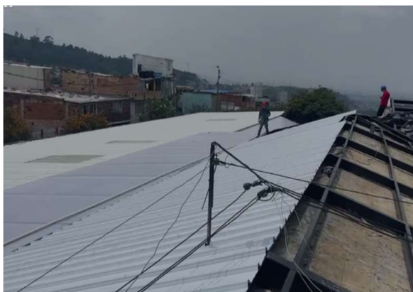
5. INSTALACION DE TEJA Y CABALLETE DEMOLICIÓN DE PLACA EXISTENTE
