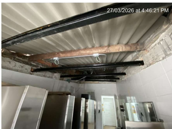
11. INSTALACIÓN ESTRUCTURA METÁLICA BAÑO DE HOMBRES SEGUNDO PISO
