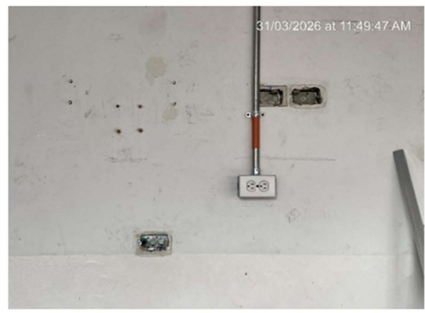
34. INSTALACIÓN TOMACORRIENTES SEGUNDO PISO
