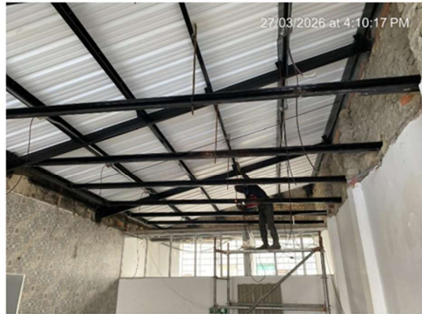
14. INSTALACIÓN ESTRUCTURA METÁLICA PARA CIELO RASO BLOQUES ADMINISTRATIVOS
