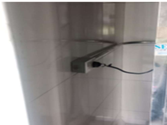
7. INSTALACION DE PUNTOS ELÉCTRICOS
