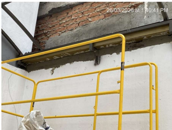
27. CONSTRUCCIÓN MURO BAJO CANAL PATIOS TRASEROS
