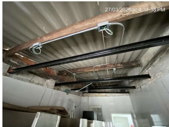
8. INSTALACIÓN CABLEADO ILUMINACIÓN BAÑO MUJERES 2do PISO
