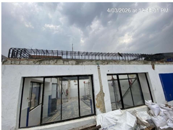
1. ARMADO ACERO LONGITUDINAL Y FLEJES VIGA CORONA
