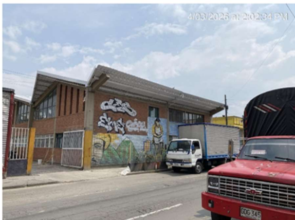
1. INSTALACIÓN DE CUBIERTA ECOROOF
