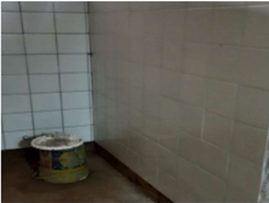
1. INSTALACIÓN DE ENCHAPE 20X20
