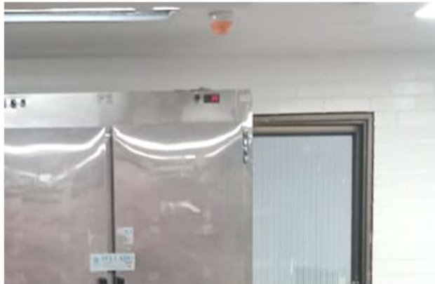
8. INSTALACION DE SISTEMA DE DETECCIÓN
