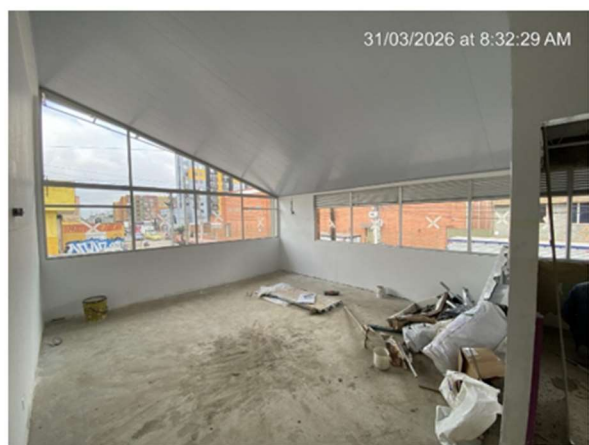
26. INSTALACIÓN DE VENTANERÍA FACHADA SEGUNDO PISO
