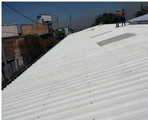
3. MANTENIMIENTO DE CUBIERTA EXISTENTE
