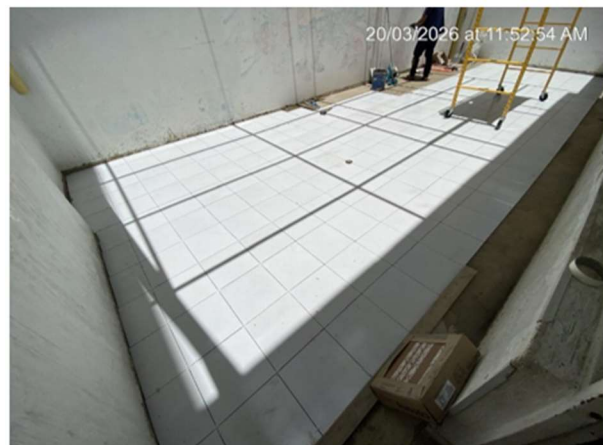
21. INSTALACIÓN DE ENCHAFE DE PISO ÁREA PATIO TRASERO
