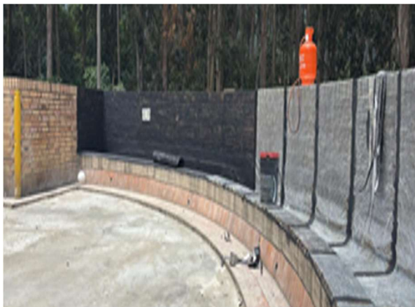
5. CAMBIO DE MANTO IMPERMEABILIZANTE EN ÁREA INTERVENIDA
