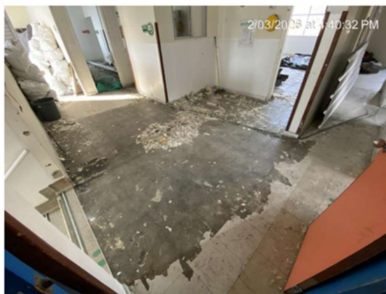
2. DESMONTE DE PISO EN VINILO
