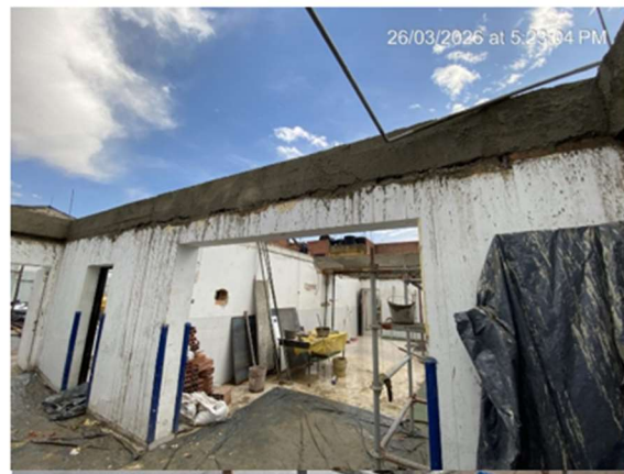
20. SAFARREADA EN VIGA CORONA
