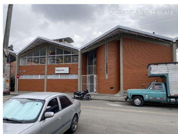
30. APLICACIÓN PINTURA PARA LA FACHADA SEDE
