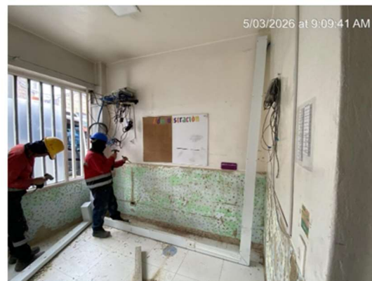
6. DESMONTE E INSTALACIÓN CANALETA METÁLICA
