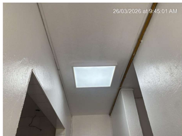
23. DESMONTE E INSTALACIÓN LÁMPARA
