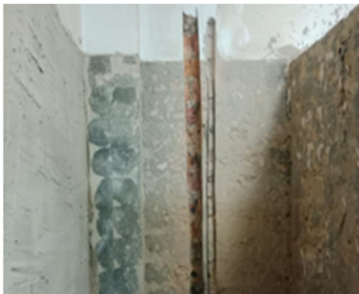
7. REGATAS PARA INSTALACION DE REDES
