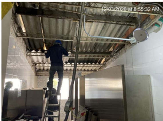
1. DESMONTE E INSTALACIÓN TEJAS BAÑOS 2do PISO
