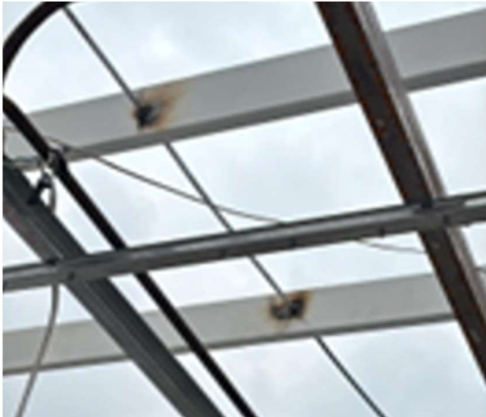
5. INSTALACION DE ESTRUCTURA METÁLICA PARA CUBIERTA
