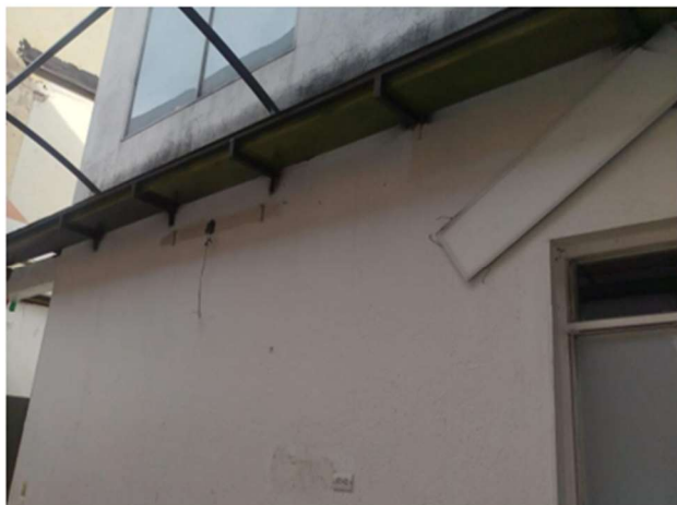
17. INSTALACIÓN DE CANAL ÁREA PATIOS
