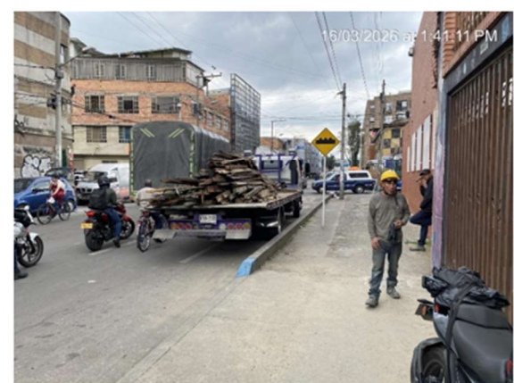
10. DESMONTE Y RETIRO DE ESTRUCTURA DE SOPORTE EN MADERA DE LA CUBIERTA EXISTENTE
