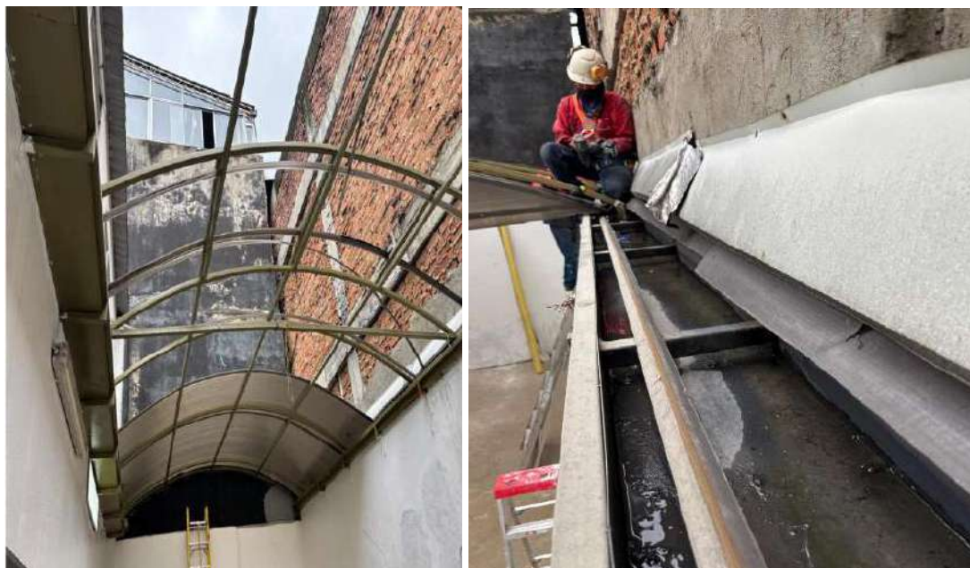
Mantenimiento estructura metalica y cambio de polycarbonato
