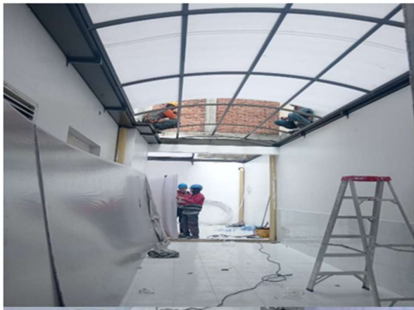
25. INSTALACIÓN DE POLICARBONATO PATIOS TRASEROS
