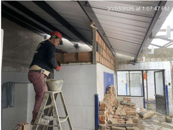
25. CONSTRUCCIÓN MURO MAMPOSTERÍA BAÑO
