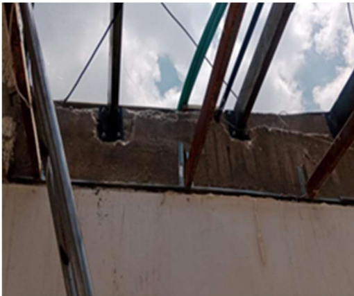
1. DESMONTE DE CERCHAS METÁLICAS
