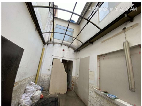
16. INSTALACIÓN DE CANAL ÁREA PATIOS
