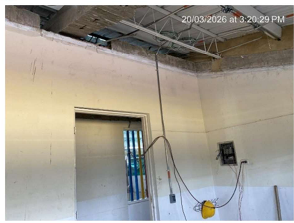
28. INSTALACIÓN CABLEADO PARA ILUMINACIÓN Y FUERZA
