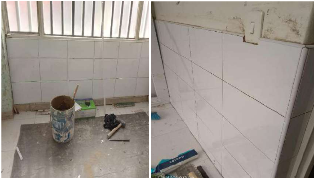
Enchape de muros y salones
