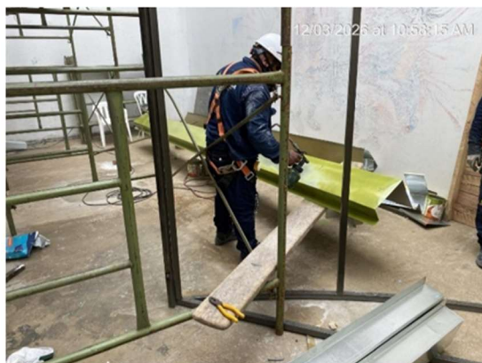
5. APLICACIÓN PINTURA CANAL ÁREA PATIOS
