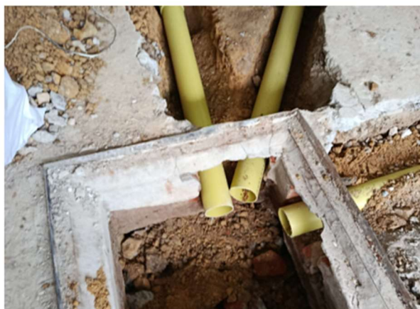
9. INSTALACIÓN TUBERÍA SANITARIA 4"
