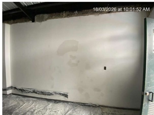
4. RESANE DE MUROS
