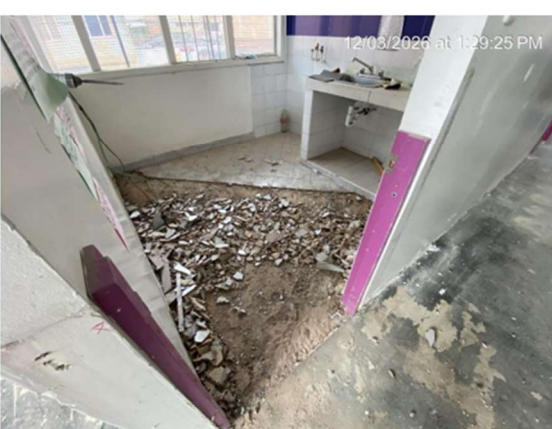
6. DEMOLICIÓN DE ENCHAPE DE PISO
