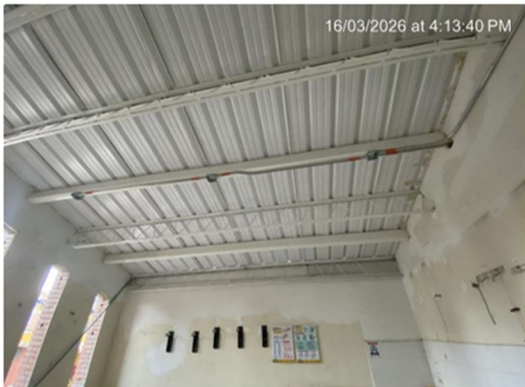
7. RESANE DE MUROS INTERNOS CON ESTUCO
