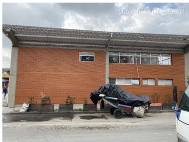
29. APLICACIÓN PINTURA PARA LA FACHADA SEDE
