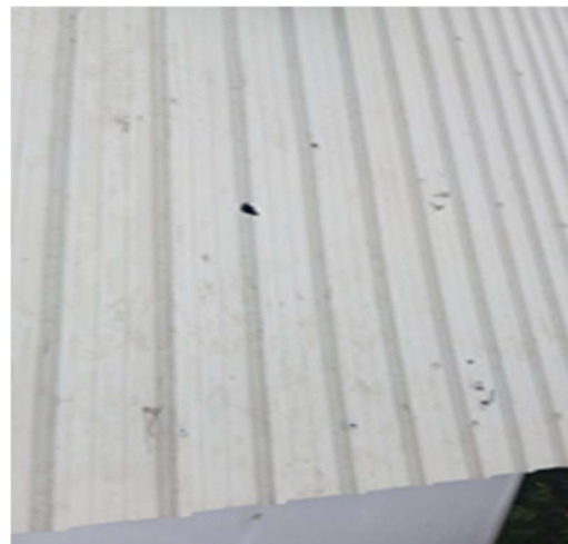
14. CAMBIO DE TEJAS ROTAS
