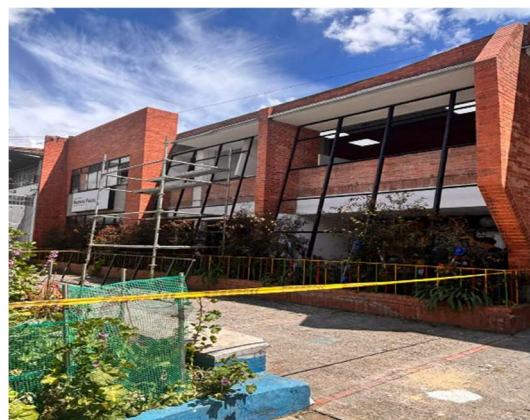
4. INSTALACION DE VENTANAS Y PERFILERÍA EN FACHADA
