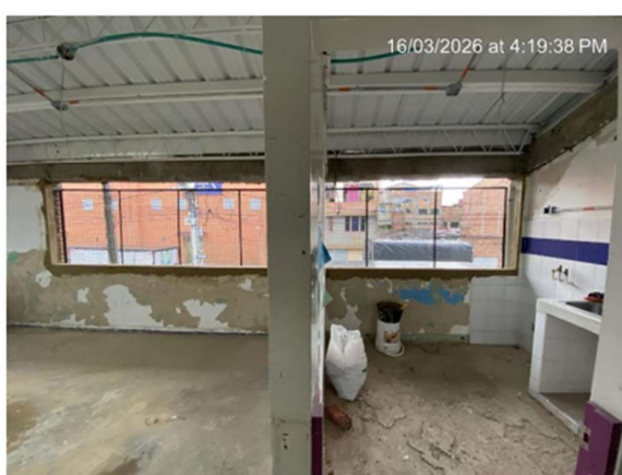
18. DESMONTE DE VENTANAS FACHADA SEGUNDO PISO
