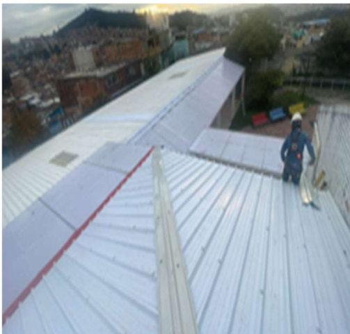
13. SE REALIZA EL CAMBIO DE FLANCHES
