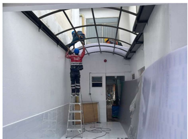
24. INSTALACIÓN DE POLICARBONATO PATIOS TRASEROS
