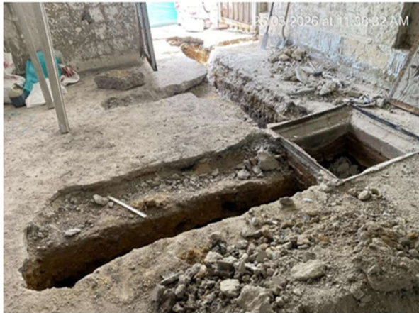
5. DEMOLICIÓN PLACA DE CONTRAPISO
