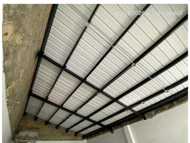
8. INSTALACIÓN TUBERÍA EMT Y CAJAS GALVANIZADAS
