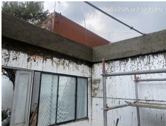
19. SAFARREADA EN VIGA CORONA
