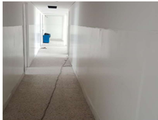
2. APLICACIÓN DE PINTURA ESMALTE Y VINÍLICA SOBRE MUROS INTERIORES
