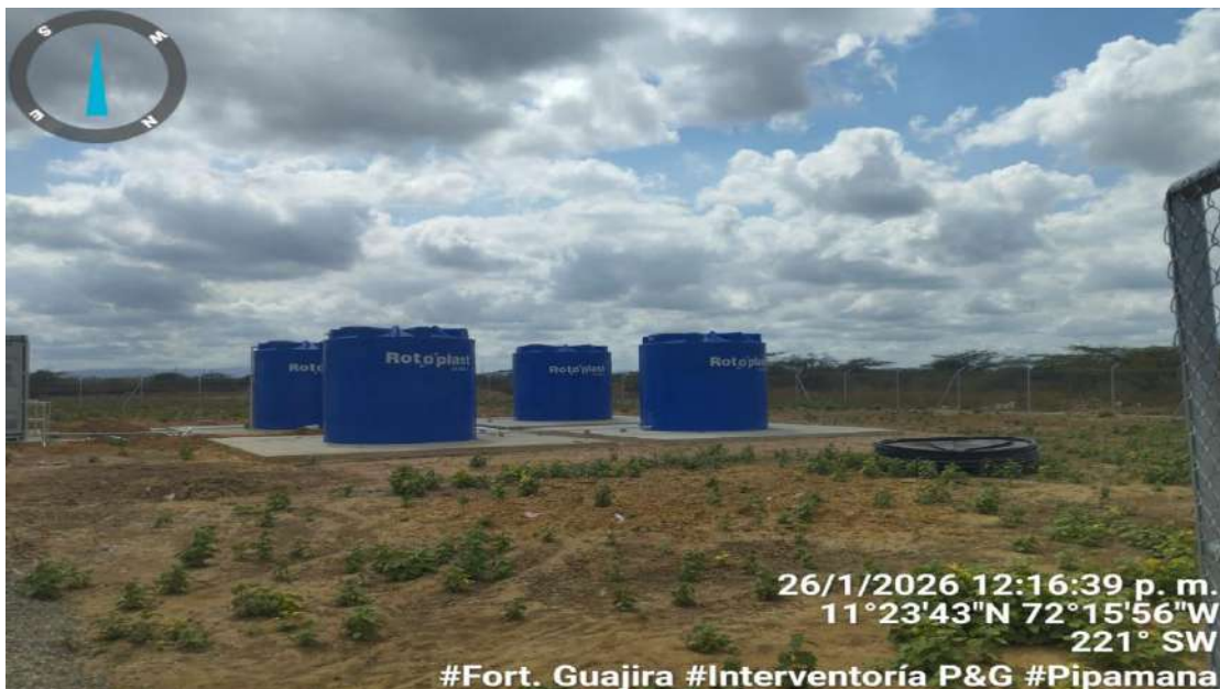
Seguimiento Proceso Constructivo Pipamana
