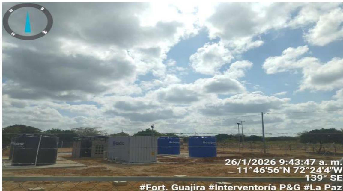
Seguimiento Proceso Constructivo La Paz
