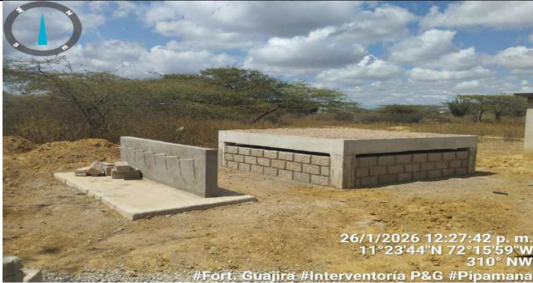
Seguimiento a procesos constructivos de bebederos
