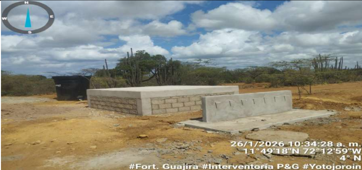
Verificación procesos constructivos bebederos faltantes
