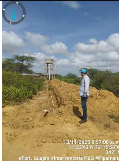
Verificación de instalación tuberías a bebederos.
