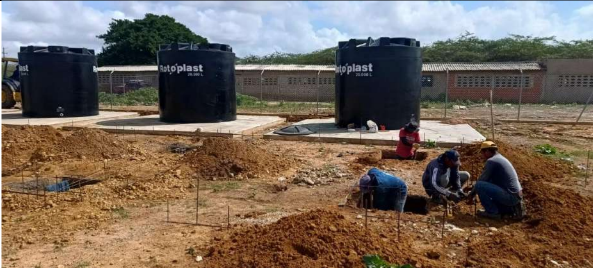
Verificación procesos constructivos en Pipamana
