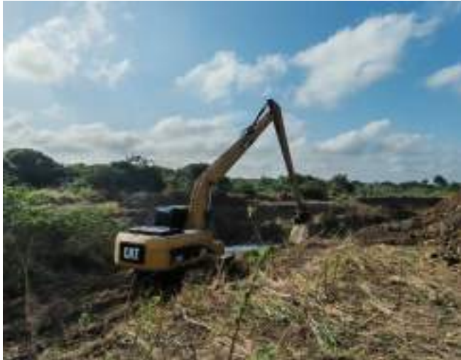
Seguimiento a limpieza para la recuperación ambiental en el adicional del tramo principal, específicamente en la abscisa K0+420 costado izquierdo
