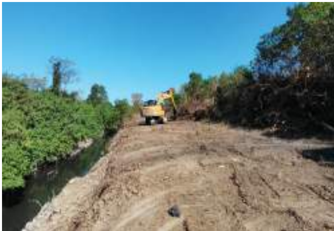
Limpieza para recuperación mecánica, perfilado y conformación de la sección transversal en el costado izquierdo del tramo principal (adicional) del arroyo León en la abscisa K0+850
