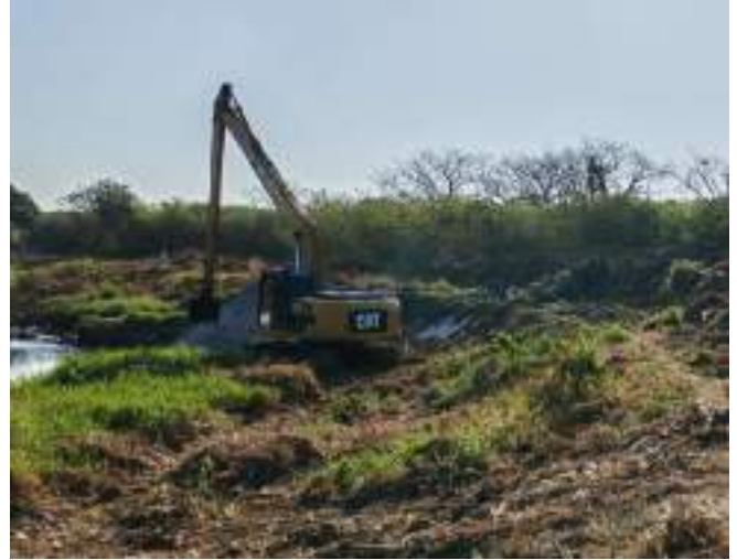
Seguimiento a limpieza para la recuperación ambiental en el adicional del tramo principal, específicamente en la abscisa K0+050 costado izquierdo
