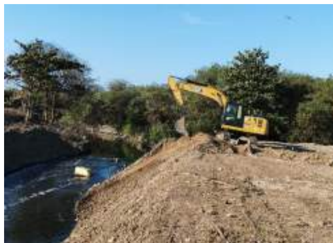
Seguimiento a limpieza para la recuperación ambiental en el adicional del tramo principal, específicamente en la abscisa K0+180 costado derecho
