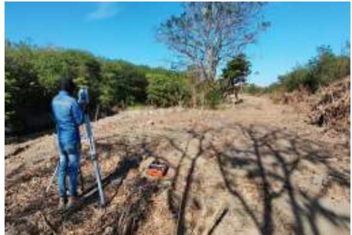
Seguimiento y control a trazado y replanteo inicial en brazo auxiliar K0+400 tramo adicional
