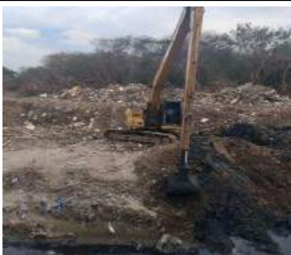
Imagen 12: Maquinaria utilizada en obra
