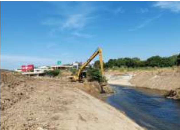
Seguimiento a limpieza para la recuperación ambiental en el adicional del tramo principal, específicamente en la abscisa K0+100 costado izquierdo
