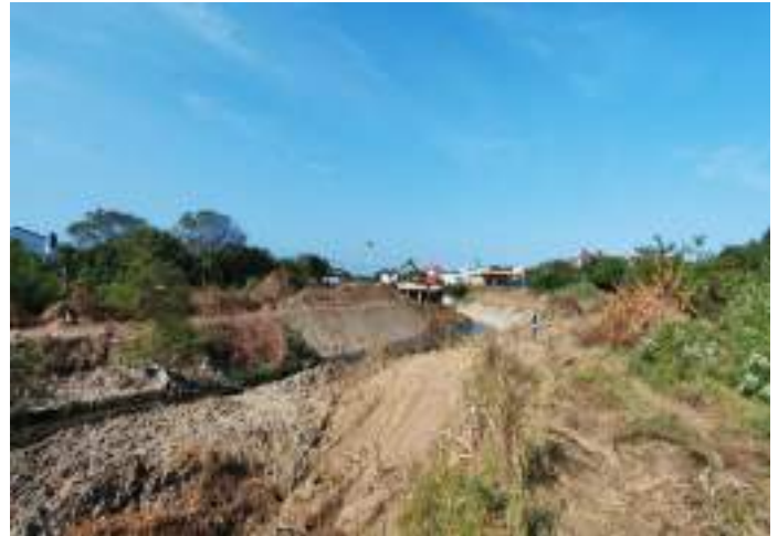
Vista de maquinaria desde la abscisa K1+180 trabajos en ambos costados
