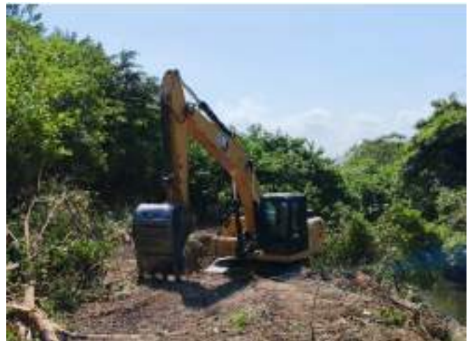
Limpieza para recuperación mecánica, perfilado y conformación de la sección transversal en el costado izquierdo del tramo principal (adicional) del arroyo León en la abscisa K0+050
