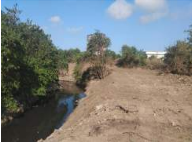
Limpieza para recuperación mecánica, perfilado y conformación de la sección transversal en el costado izquierdo del tramo principal (adicional) del arroyo León en la abscisa K0+900
