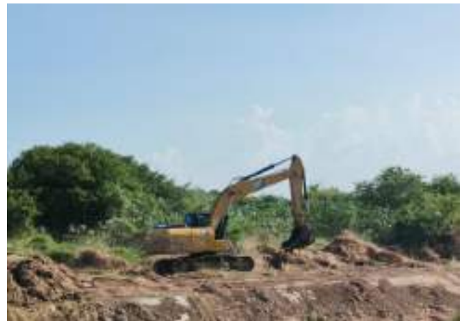
Seguimiento a limpieza para la recuperación ambiental en el adicional del tramo principal, específicamente en la abscisa K0+150 costado izquierdo
