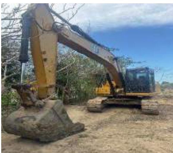
Imagen 14: Maquinaria utilizada en obra
