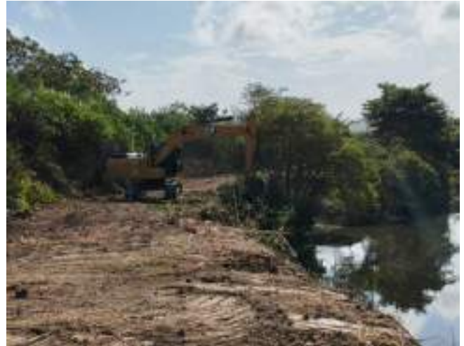
Seguimiento a limpieza para la recuperación ambiental en el adicional del tramo principal, específicamente en la abscisa K0+480 costado izquierdo
