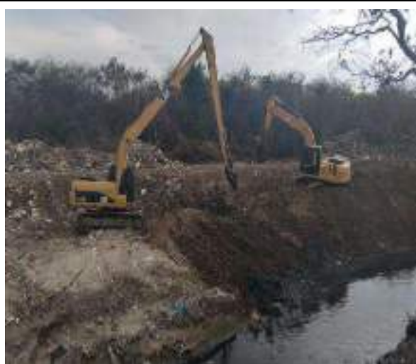
Imagen 13: Maquinaria utilizada en obra
