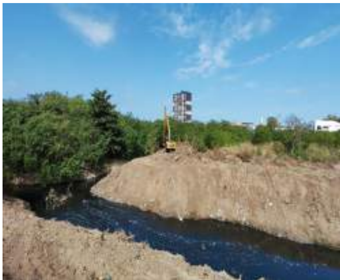
Seguimiento a limpieza para recuperación mecánica, perfilado y conformación de la sección transversal en el costado izquierdo del tramo principal (adicional) del arroyo León en la abscisa K0+400
