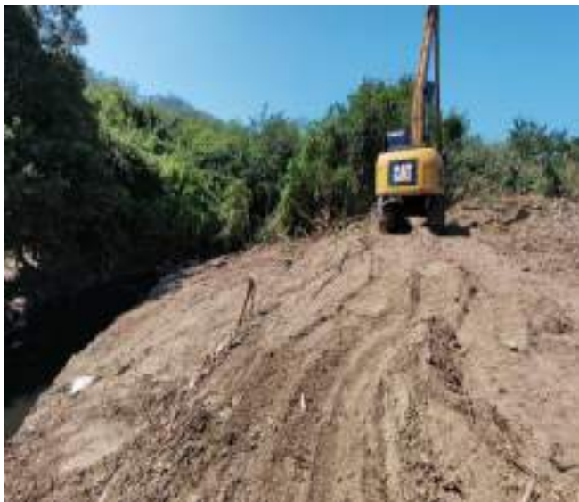
Maquinaria en tramo adicional para limpieza para recuperación ambiental, específicamente en abscisa K1+080 Talud izquierdo Tramo Adicional
