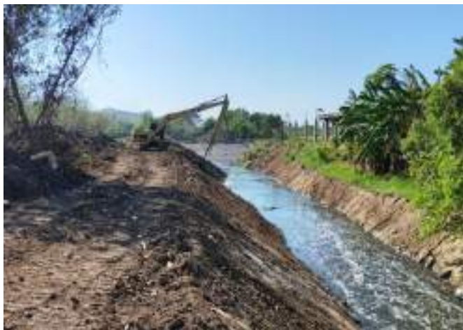
Seguimiento a limpieza para la recuperación ambiental en el adicional del tramo principal, específicamente en la abscisa K0+200 costado derecho
