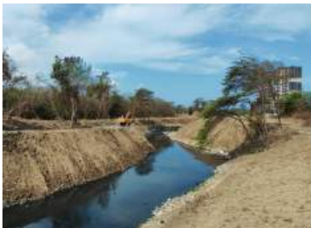
Seguimiento a limpieza para la recuperación ambiental en el adicional del tramo principal, específicamente en la abscisa K0+150 costado derecho
