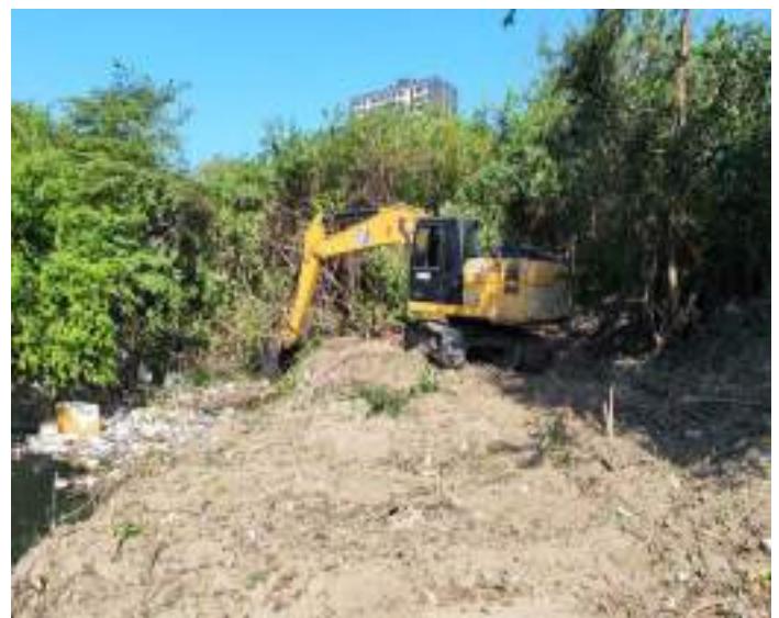
Limpieza para recuperación mecánica, perfilado y conformación de la sección transversal en el costado izquierdo del tramo principal (adicional) del arroyo León en la abscisa K0+700
