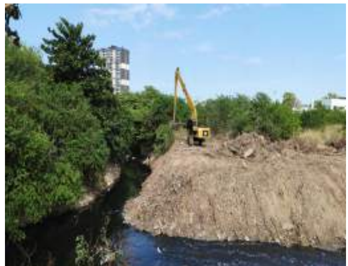
Seguimiento a limpieza para recuperación mecánica, perfilado y conformación de la sección transversal en el costado izquierdo del tramo principal (adicional) del arroyo León en la abscisa K0+420
