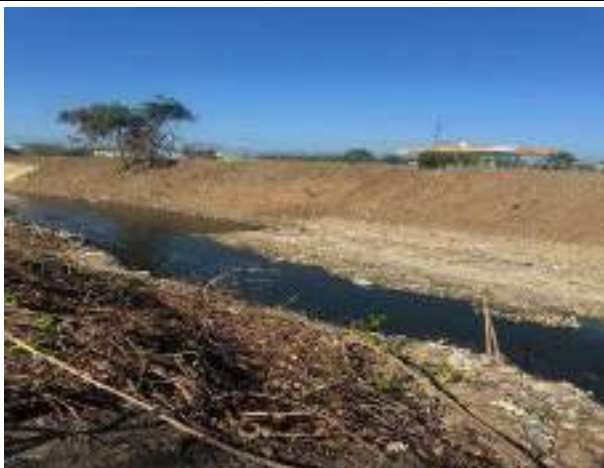
Imagen 18: Conformación de talud Arroyo León
