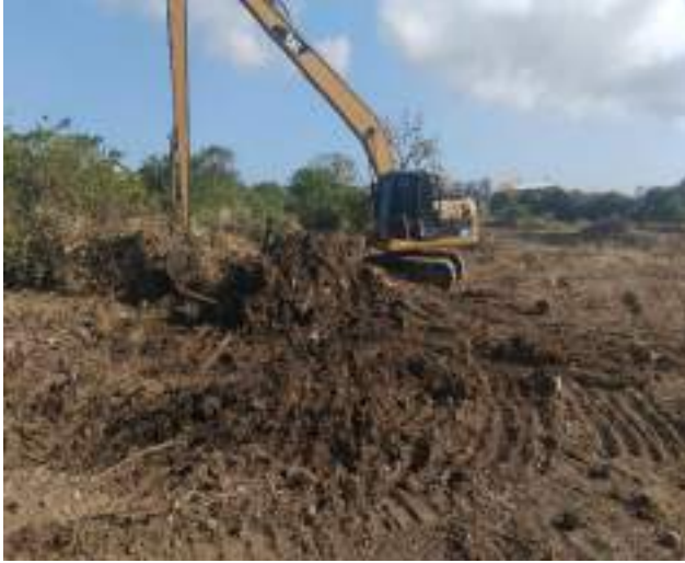
Seguimiento a limpieza para recuperación mecánica, perfilado y conformación de la sección transversal en el costado izquierdo del tramo principal (adicional) del arroyo León en la abscisa K0+650
