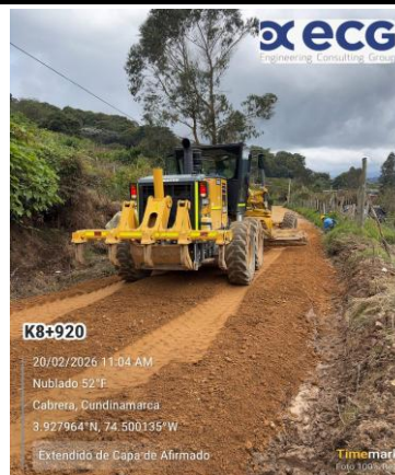
Extendido material afirmado
