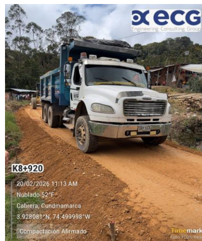
Transporte de material.
