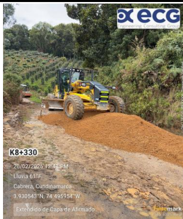
Extendido material afirmado
