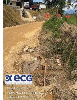
INSPECCIONES DE POSIBLES PUNTOS CRITICOS
