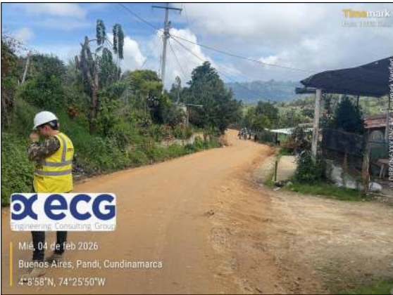
COMPACTACION DE MATERIAL GRANULAR
