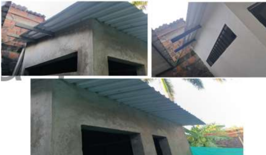
Ilustración 14. Estructura para cubierta en lámina galvanizada
