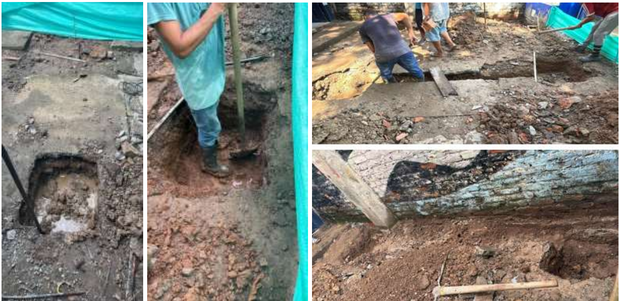
Ilustración 1. Explanación y excavaciones
