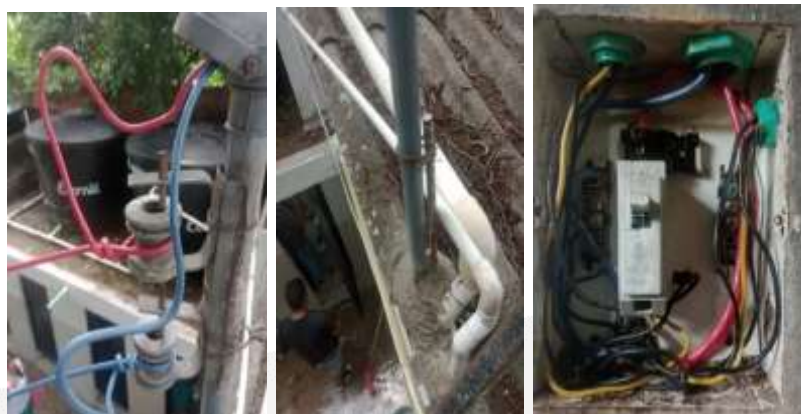
Ilustración 26 Acometida aérea 10m PVC
