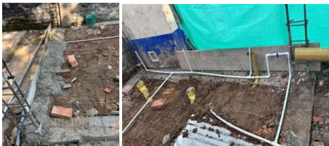
Ilustración 10. Refuerzo de malla electrosoldada
