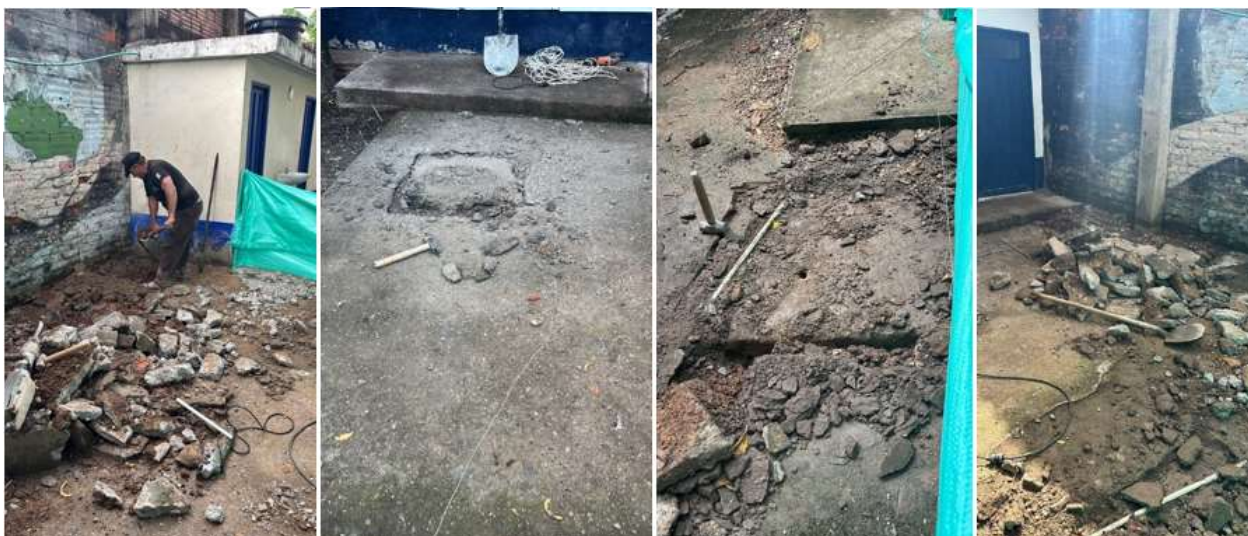
Ilustración 46. Demolición de placa piso existente
