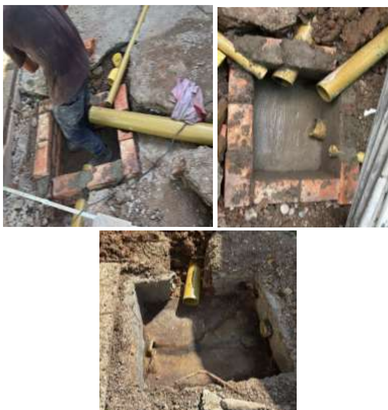
Ilustración 5. Instalación de cajas de inspección
