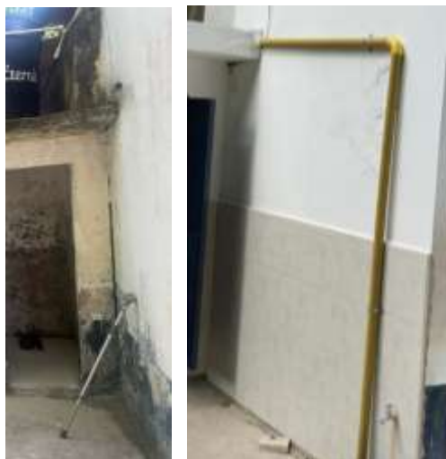
Ilustración 51 Red sanitaria para bajantes de aguas lluvias
