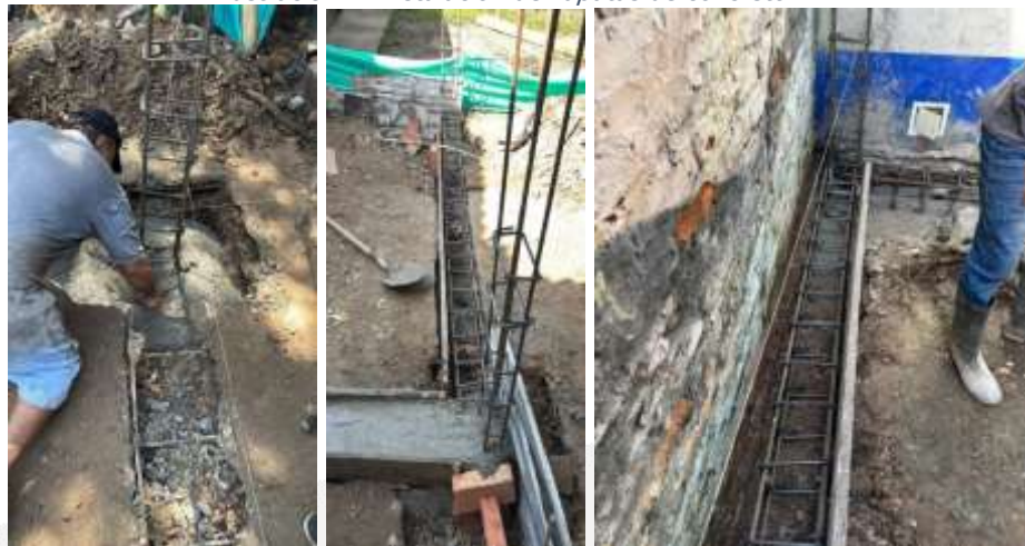
Ilustración 4. Instalación de zapatas de concreto
