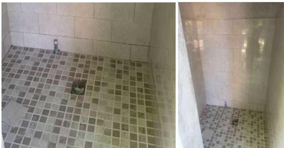
Ilustración 42. Cerámica piso trafico 5
