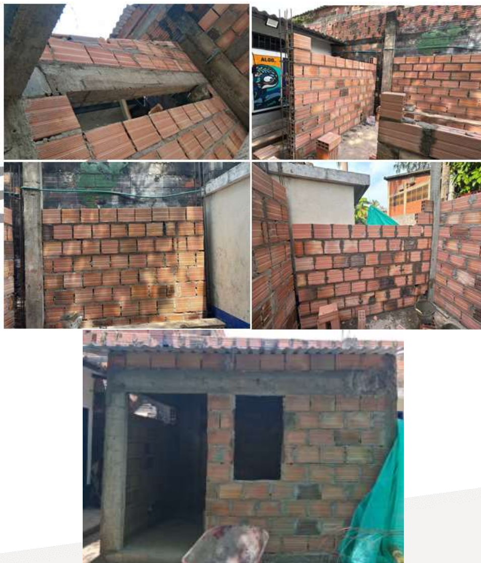
Ilustración 11. Muro en bloque N° 5
