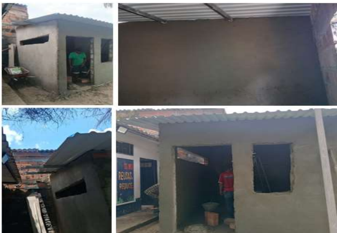
Ilustración 12. Pañete liso muros
