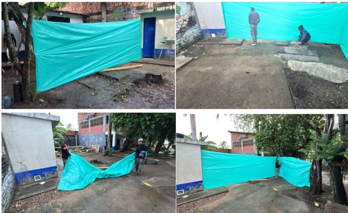
Ilustración 47. Instalación de lona verde
