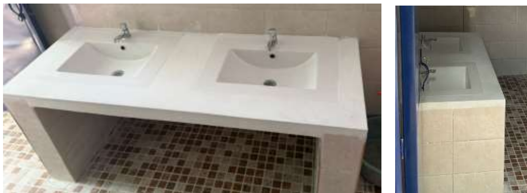
Ilustración 34 Suministro e instalación lavamanos de empotrar
