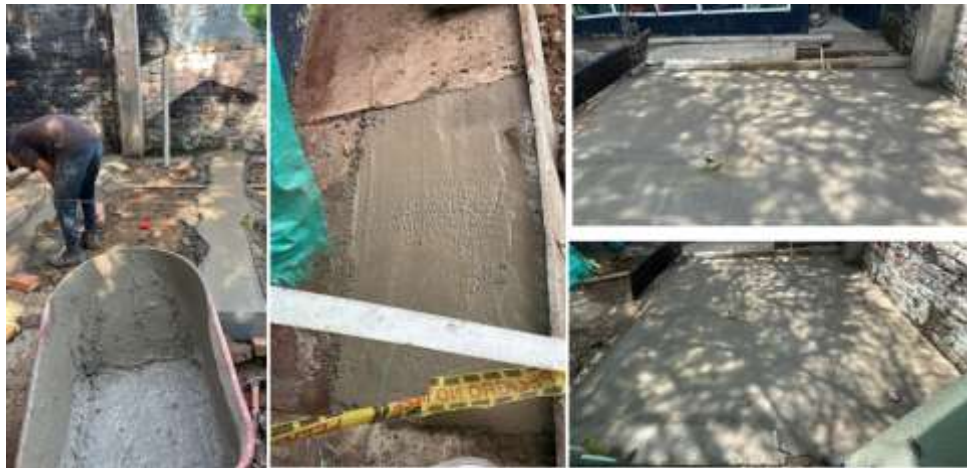
Ilustración 30 Placa base concreto
