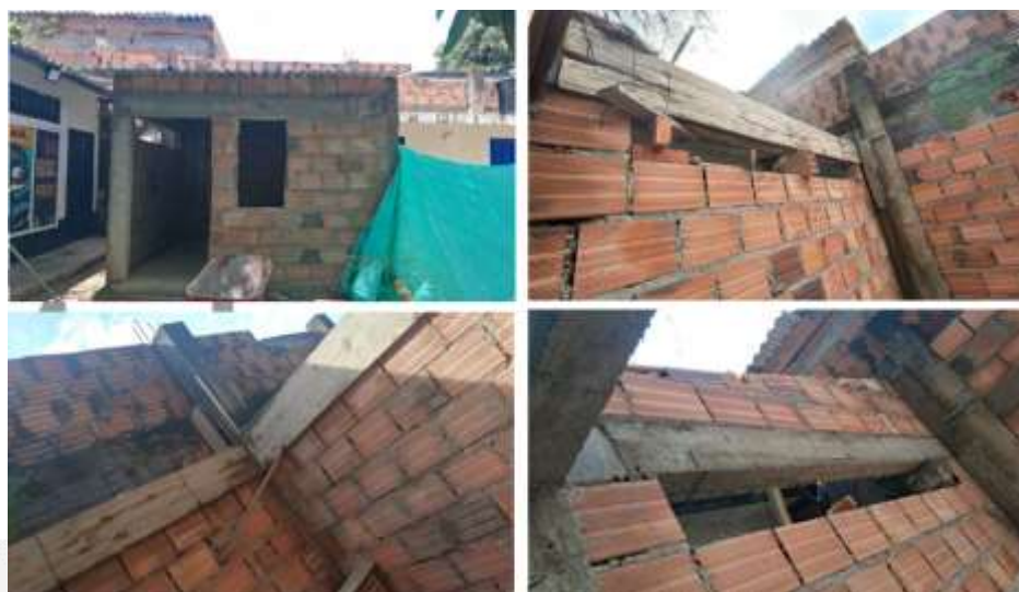
Ilustración 7. Viga aérea 3500 PSI
