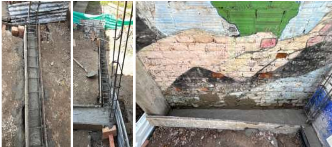
Ilustración 3. Instalación de vigas de amarre
