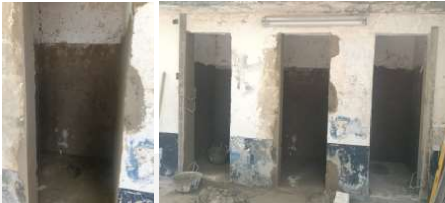
Ilustración 39. Pañete liso muros
