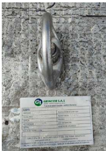
Imagen 7. Punto de anclaje
