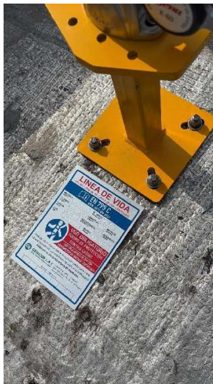
Imagen 1. Línea de vida horizontal sobre cubierta
