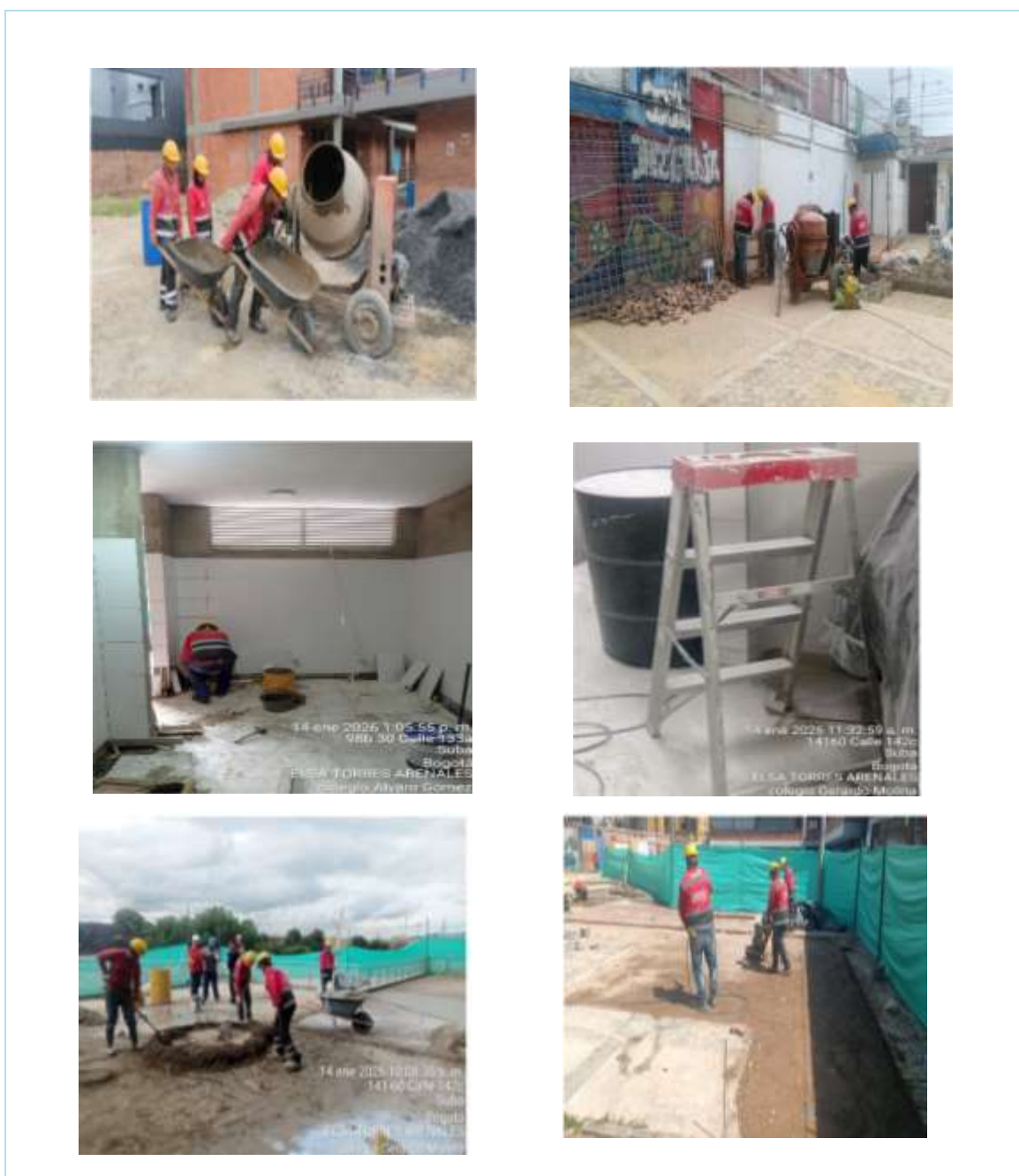
Ilustración 10 Registro fotografico de seguimiento, control en frentes de obra.
