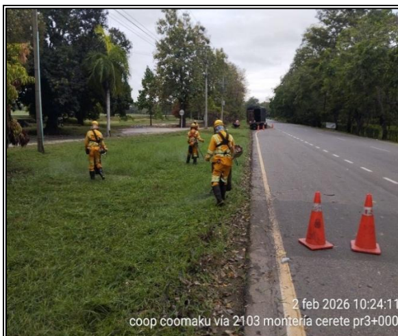
Rocería. PR3+0000 Separador. Vía 2103
