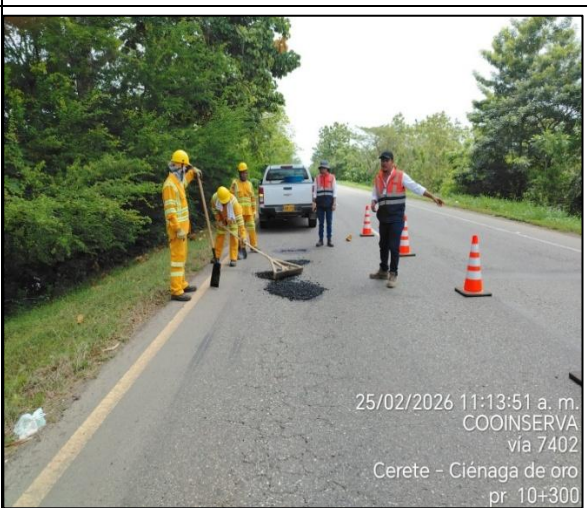
Parcheo Mezcla Asfáltica. PR10+0300 Vía 7402
