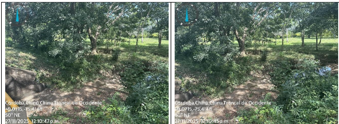
PUENTE CARRANZO II. En Buen estado. Requiere barandas metálicas.
