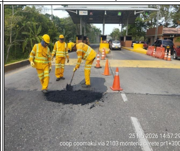
Parcheo Mezcla Asfáltica. PR6+0000 Vía Postobón -Aeropuerto
