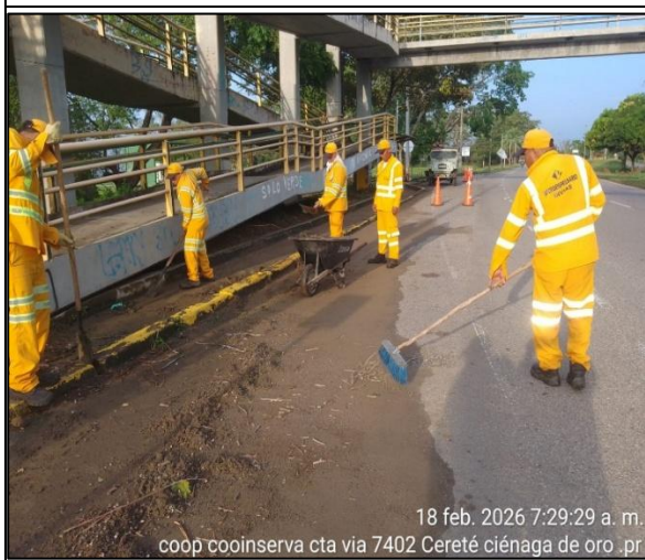
Embellecimiento Puente Peatonal. PR10+0250. Vía 7402
