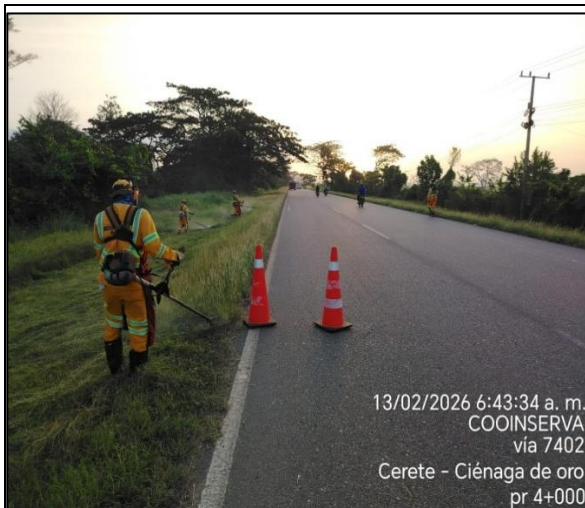
Rocería. PR4+0000 Calzada Izquierda. Vía 7402
