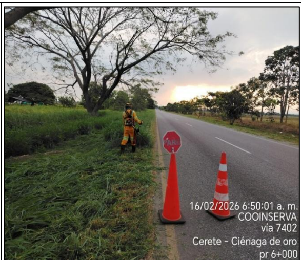
Rocería. PR6+0000 Calzada Derecha. Vía 7402
