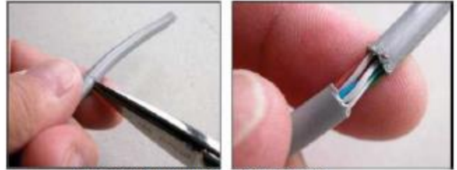
Figura 3. Retiro del revestimiento del cable UTP
