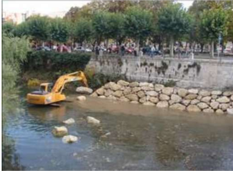
Figura 3. Protección de orilla con enrocado (Fuente: http://www.alpesaexcavaciones.com/galerias.aspx )
