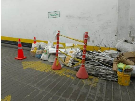
Fotografía No. 3 señalización y demarcación
