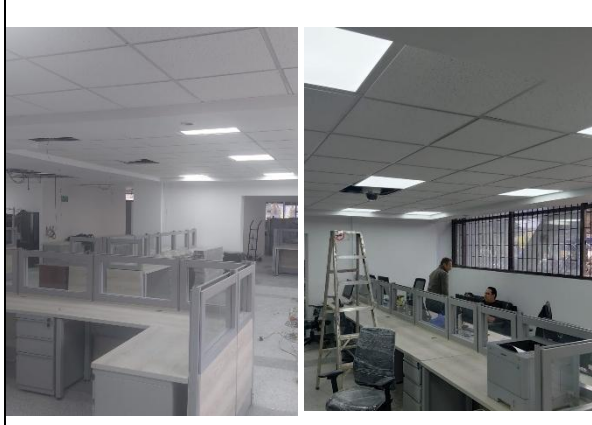
Fotografía No. 4 Inspección de áreas
