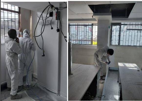
Fotografía No. 5 supervisión de actividades
