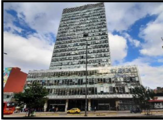
Imagen03. EDIFICIO HERNANDO MORALES MOLINA: Dirección: Carrera 10 N° 14-33
