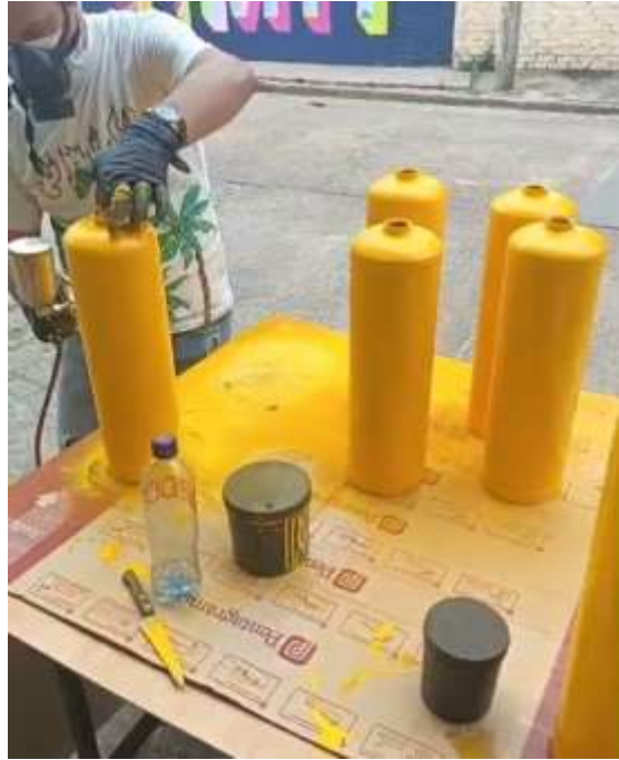
Mantenimiento a extintores deteriorados en pintura, y accesorios
