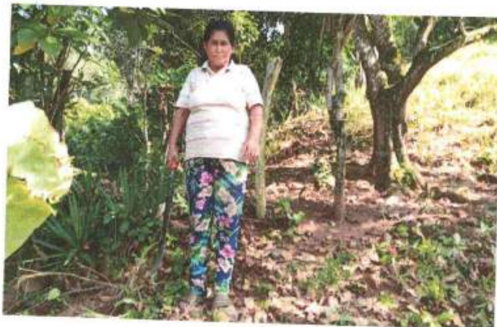
Imagen N°2: AREA DE EL GALPON, LIMPIEZA, ADECUACION
