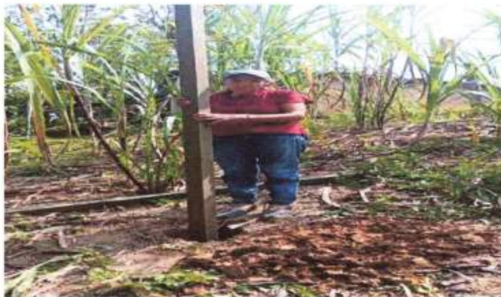
Imagen N°2: AREA DE EL GALPON, EN ACTIVIDAD DE CONSTRUCCION
