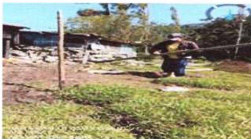
Imagen N°2: AREA DE EL GALPON, LABOR DE CONSTRUCCION DE EL GALPON
