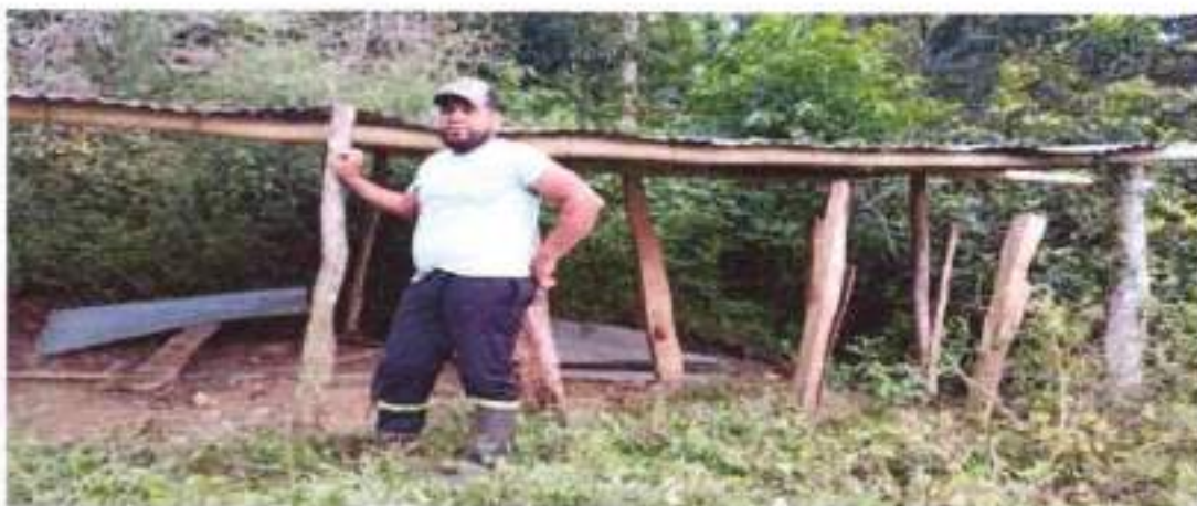
Imagen N°2: AREA DE EL GALPON, LIMPIEZA, ADECUACION
