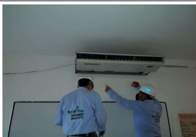
FOTOGRAFIA No. 4: Mantenimiento y Limpieza del Sistema de Refrigeración A.A CCIT Montería
