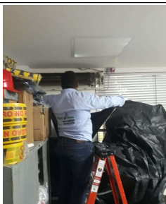
FOTOGRAFIA No. 7: Mantenimiento y Limpieza del Sistema de Refrigeración A.A Sede Administrativa
