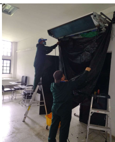
FOTOGRAFIA No. 4: Mantenimiento y Limpieza del Sistema de Refrigeración A.A CCIT Lórica
