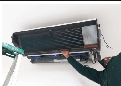
FOTOGRAFIA No. 5: Mantenimiento y Limpieza del Sistema de Refrigeración A.A CCIT Montería
