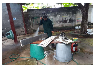
FOTOGRAFIA No. 2: Mantenimiento y Limpieza del Sistema de Refrigeración A.A CCIT Lórica
