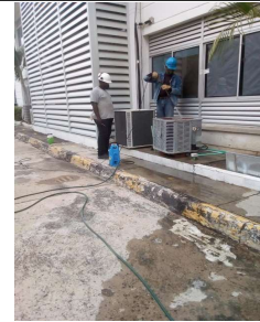
FOTOGRAFIA No. 12: Mantenimiento y Limpieza del Sistema de Refrigeración A.A. CCIT Montelibano
