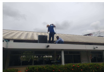
FOTOGRAFIA No. 3: Mantenimiento y Limpieza del Sistema de Refrigeración A.A CCIT Montería
