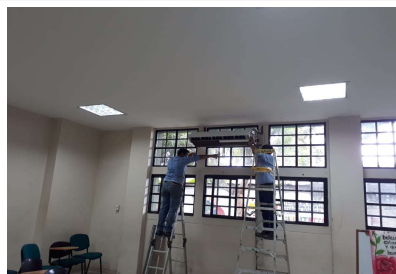
FOTOGRAFIA No. 1: Mantenimiento y Limpieza del Sistema de Refrigeración A.A CCIT Lórica
