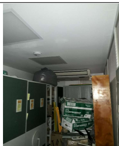
FOTOGRAFIA No. 11: Mantenimiento y Limpieza del Sistema de Refrigeración A.A Sede Administrativa
