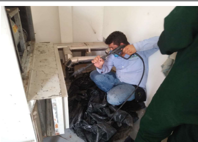
FOTOGRAFIA No. 7: Mantenimiento y Limpieza del Sistema de Refrigeración A.A. CCIT Montelibano
