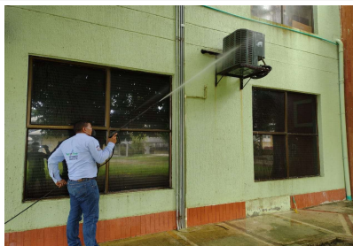
FOTOGRAFIA No. 2: Mantenimiento y Limpieza del Sistema de Refrigeración A.A CCIT Montería
