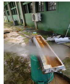
FOTOGRAFIA No. 3: Mantenimiento y Limpieza del Sistema de Refrigeración A.A CCIT Lórica
