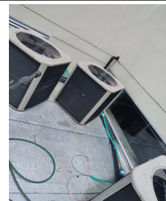
FOTOGRAFIA No. 11: Mantenimiento y Limpieza del Sistema de Refrigeración A.A. CCIT Montelibano
