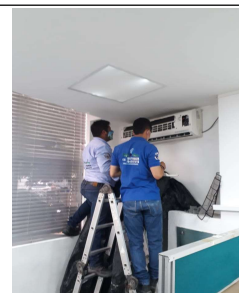
FOTOGRAFIA No. 12: Mantenimiento y Limpieza del Sistema de Refrigeración A.A Sede Administrativa
