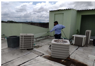
FOTOGRAFIA No. 1: Mantenimiento y Limpieza del Sistema de Refrigeración A.A CCIT Montería
