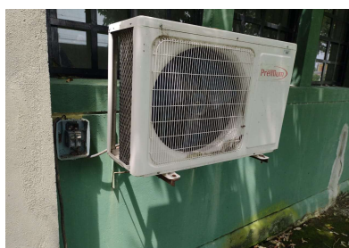
FOTOGRAFIA No. 5: Mantenimiento y Limpieza del Sistema de Refrigeración A.A CCIT Lórica
