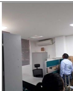
FOTOGRAFIA No. 10: Mantenimiento y Limpieza del Sistema de Refrigeración A.A Sede Administrativa
