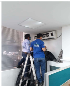
FOTOGRAFIA No. 8: Mantenimiento y Limpieza del Sistema de Refrigeración A.A Sede Administrativa
