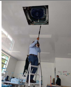
FOTOGRAFIA No. 8: Mantenimiento y Limpieza del Sistema de Refrigeración A.A. CCIT Montelibano
