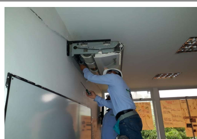
FOTOGRAFIA No. 6: Mantenimiento y Limpieza del Sistema de Refrigeración A.A CCIT Montería
