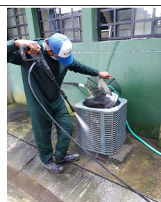
FOTOGRAFIA No. 6: Mantenimiento y Limpieza del Sistema de Refrigeración A.A CCIT Lórica
