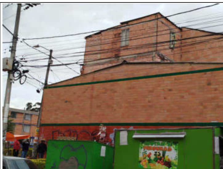
IMAGEN 4. Foto externa de construcción piso 4
