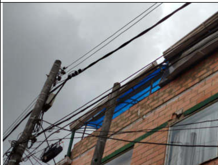
IMAGEN 6. Foto externa de construcción piso 4
