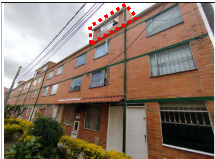
IMAGEN 3. Fachada lateral con construcción del piso 4
