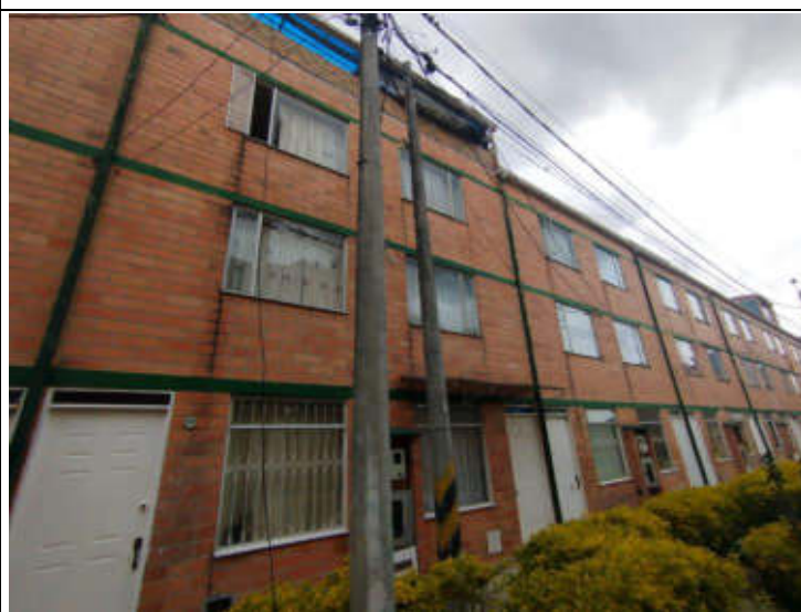
IMAGEN 6. Foto externa de construcción piso 4
