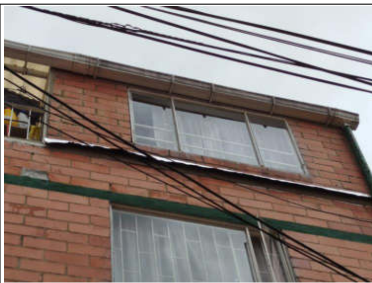
IMAGEN 4. Foto externa de construcción piso 4
