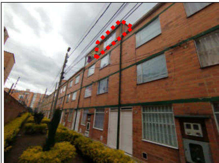
IMAGEN 3. Fachada lateral con construcción del piso 4
