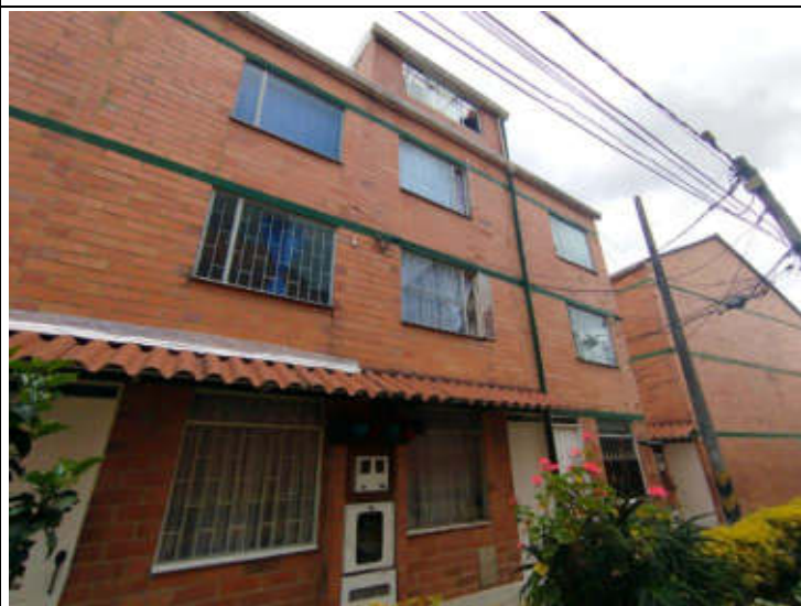
IMAGEN 6. Foto externa de construcción piso 4
