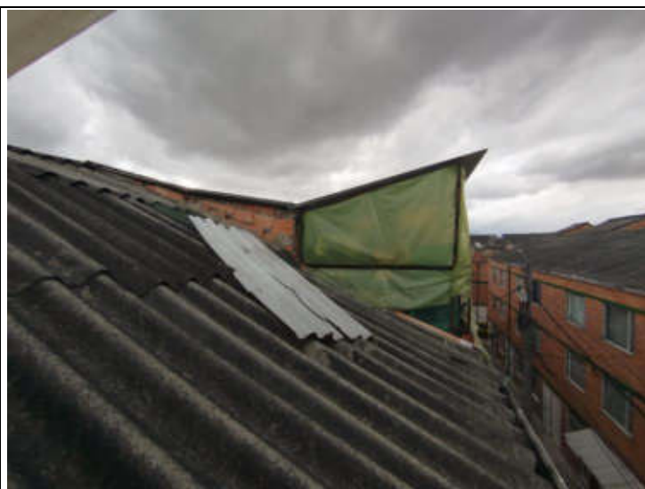
IMAGEN 4. Foto externa de construcción piso 4
