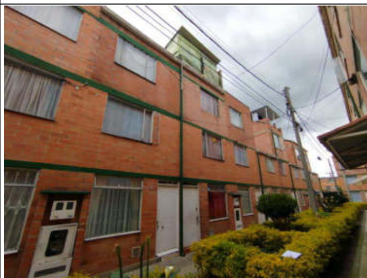
IMAGEN 6. Foto externa de construcción piso 4
