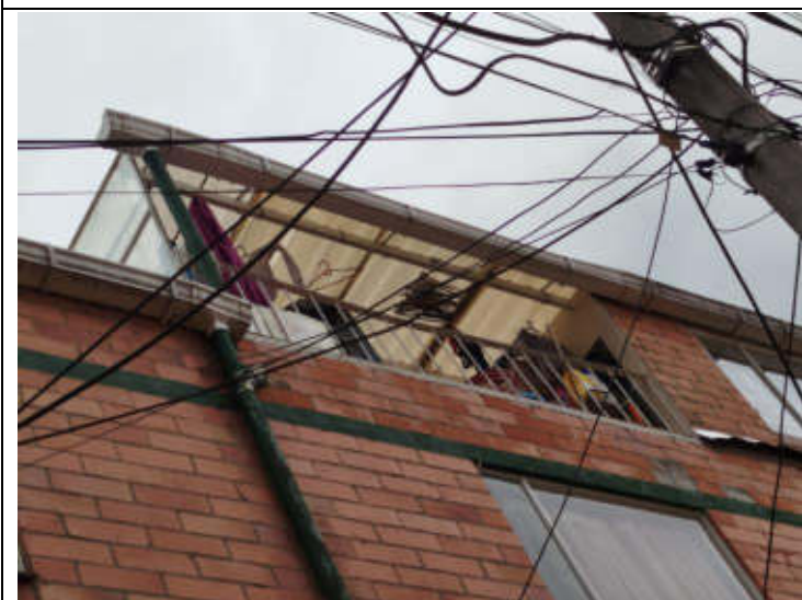
IMAGEN 5. Foto externa de construcción piso 4
