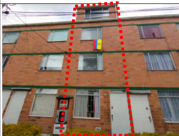
IMAGEN 1: Fachada frontal casa N° 139
