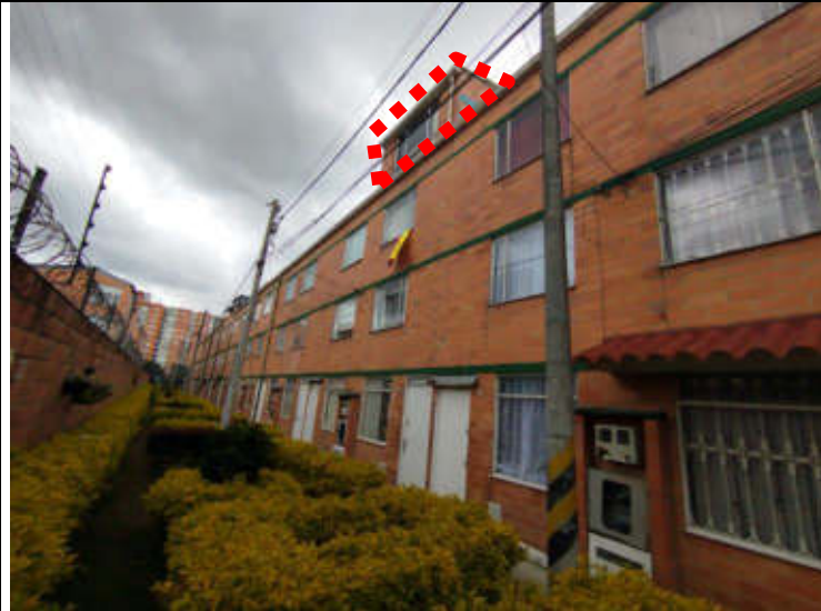
IMAGEN 3. Fachada lateral con construcción del piso 4
