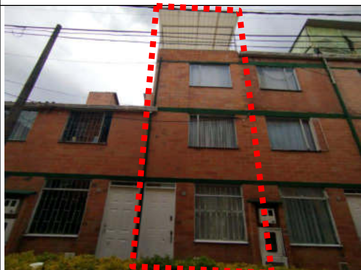
IMAGEN 1: Fachada frontal casa N° 177
