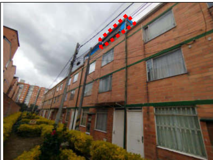
IMAGEN 3. Fachada lateral con construcción del piso 4
