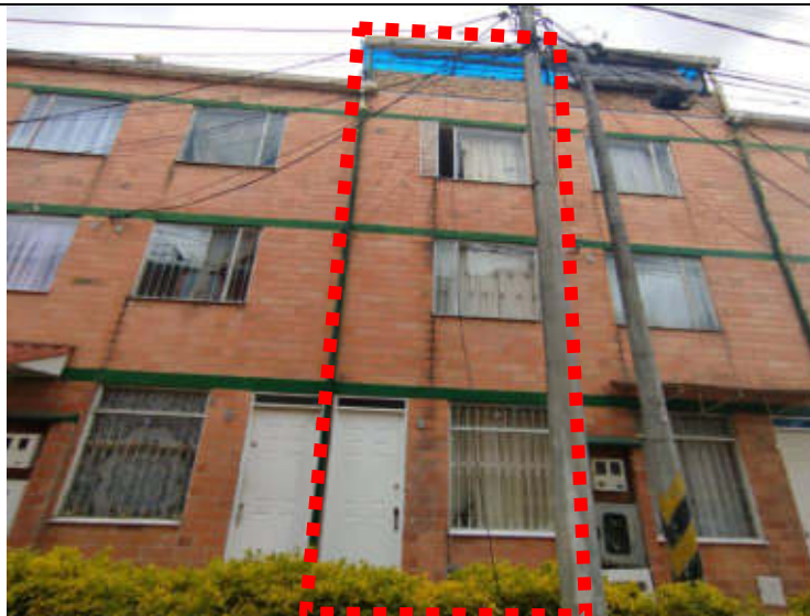
IMAGEN 1: Fachada frontal casa N° 130
