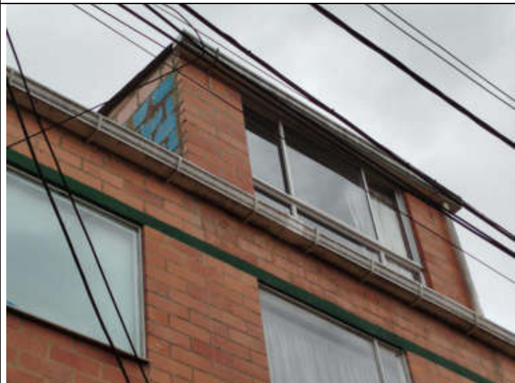
IMAGEN 5. Foto externa de construcción piso 4
