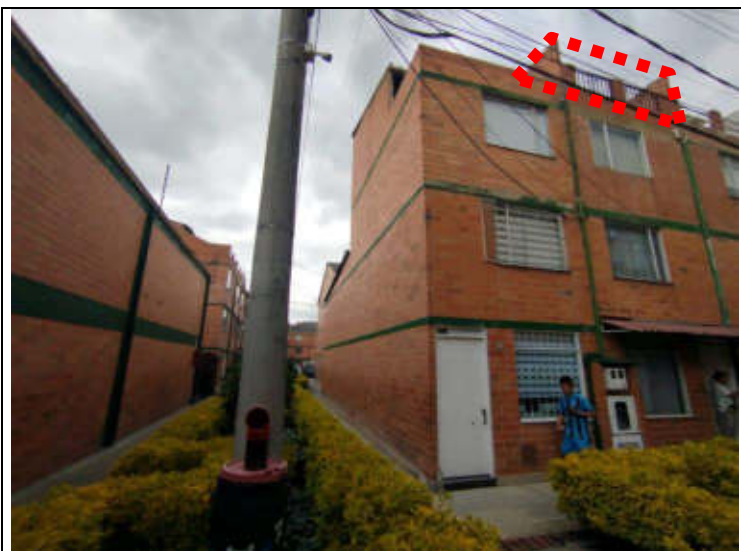
IMAGEN 3. Fachada lateral con construcción del piso 4
