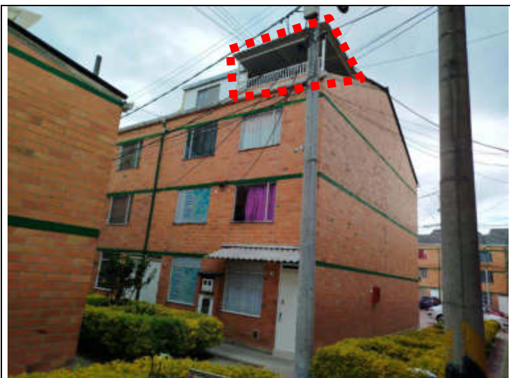
IMAGEN 3. Fachada lateral con construcción del piso 4
