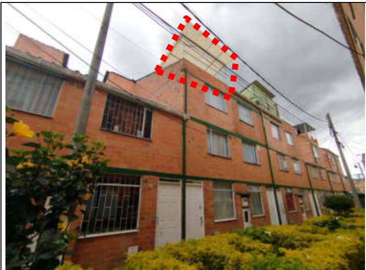
IMAGEN 3. Fachada lateral con construcción del piso 4
