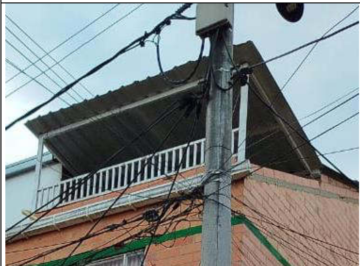
IMAGEN 5. Foto externa de construcción piso 4
