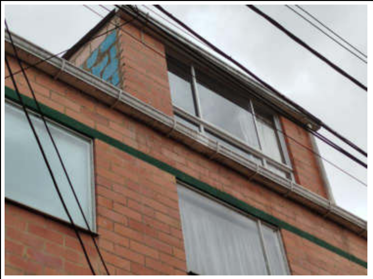
IMAGEN 4. Foto externa de construcción piso 4
