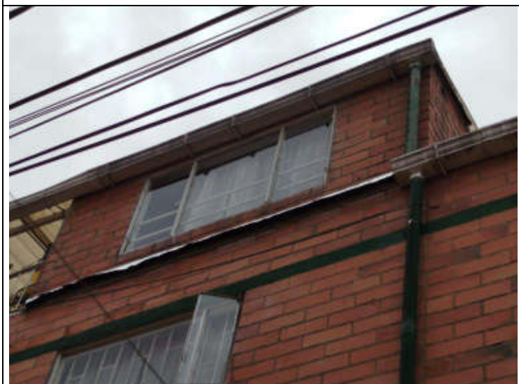
IMAGEN 5. Foto externa de construcción piso 4
