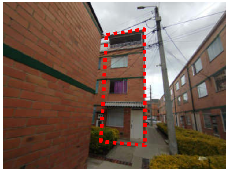
IMAGEN 1: Fachada frontal casa N° 174
