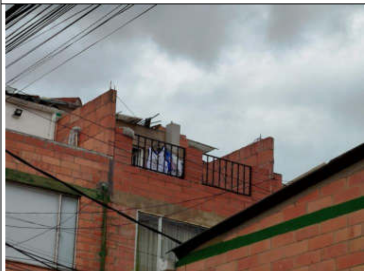
IMAGEN 5. Foto externa de construcción piso 4
