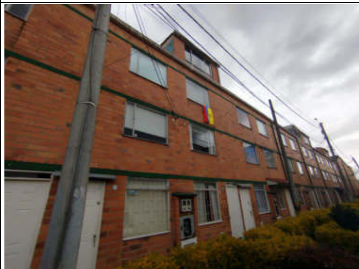
IMAGEN 6. Foto externa de construcción piso 4
