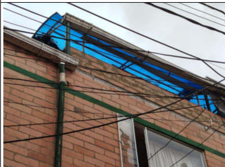
IMAGEN 5. Foto externa de construcción piso 4
