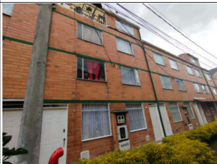
IMAGEN 6. Foto externa de construcción piso 4
