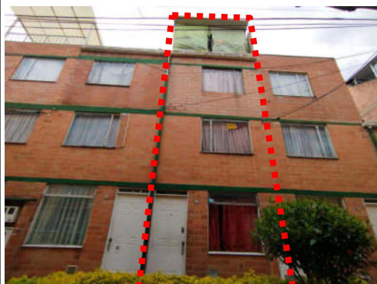
IMAGEN 1: Fachada frontal casa N° 179
