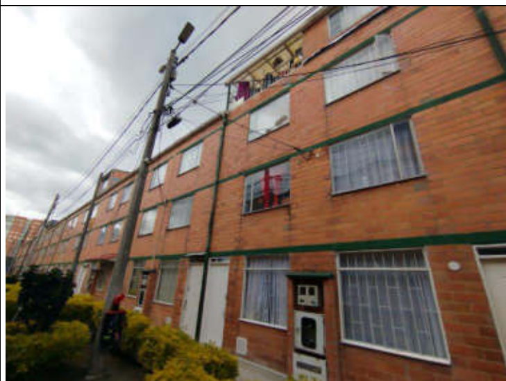
IMAGEN 6. Foto externa de construcción piso 4
