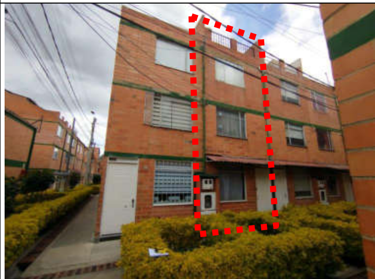
IMAGEN 1: Fachada frontal casa N° 188
