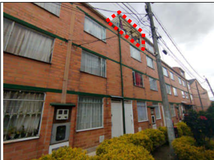
IMAGEN 3. Fachada lateral con construcción del piso 4
