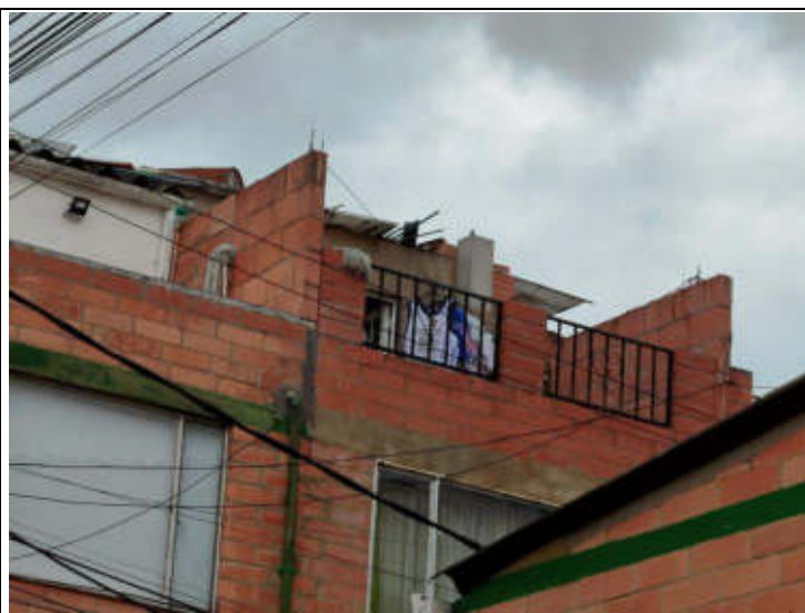
IMAGEN 4. Foto externa de construcción piso 4
