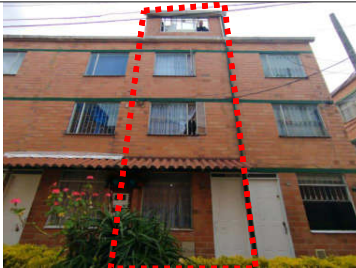
IMAGEN 1: Fachada frontal casa N° 149
