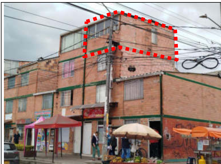
IMAGEN 3. Foto externa de construcción piso 4
