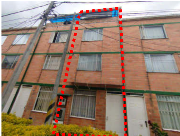
IMAGEN 1: Fachada frontal casa N° 131
