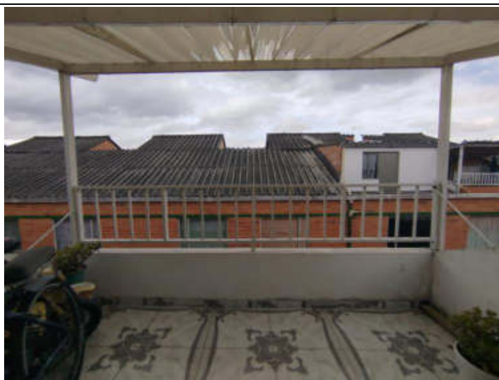
IMAGEN 6. Foto interna de construcción piso 4
