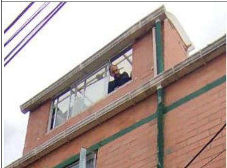
IMAGEN 5. Foto externa de construcción piso 4
