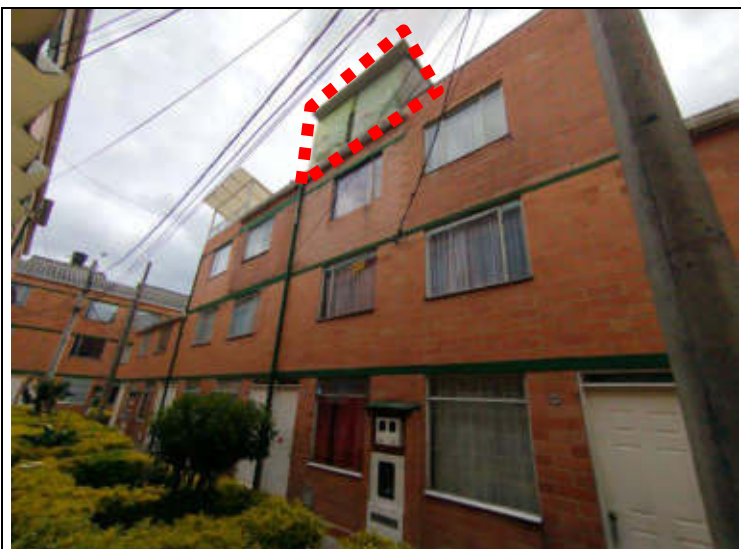
IMAGEN 3. Fachada lateral con construcción del piso 4
