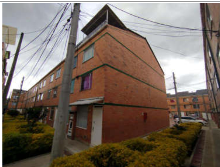
IMAGEN 6. Foto externa de construcción piso 4
