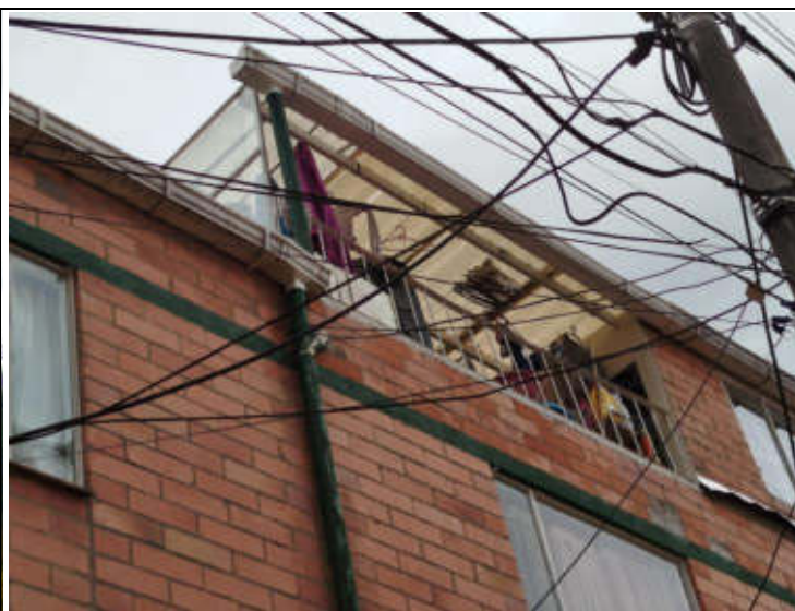
IMAGEN 4. Foto externa de construcción piso 4
