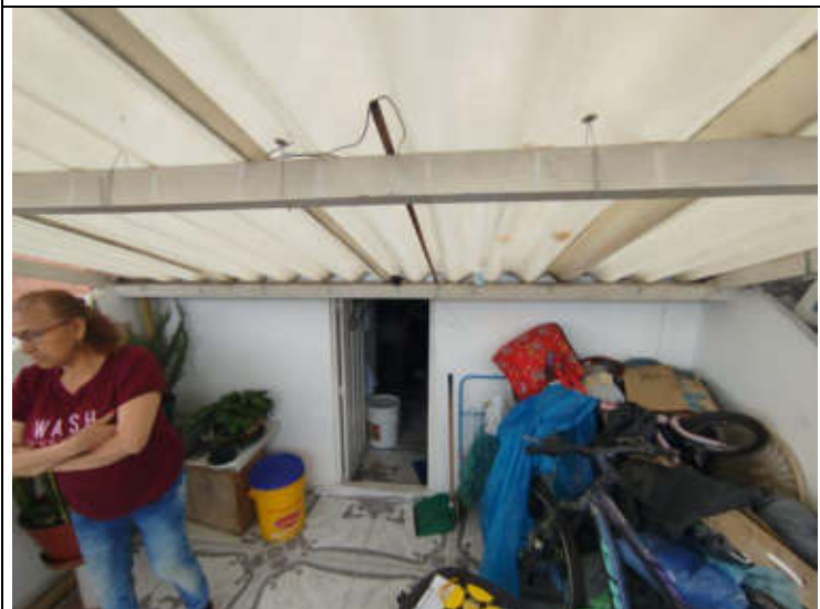
IMAGEN 5. Foto interna de construcción piso 4
