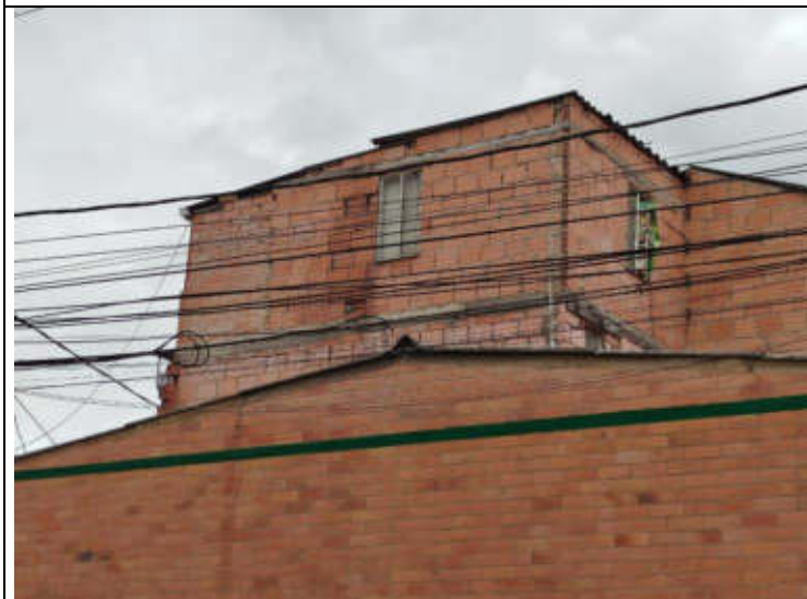
IMAGEN 5. Foto externa de construcción piso 4
