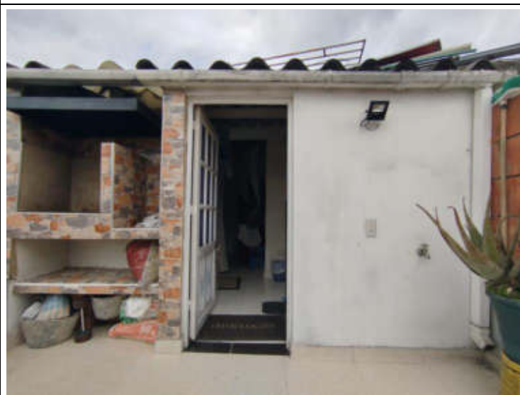
IMAGEN 5. Foto interna de construcción piso 4
