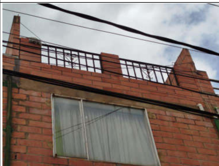
IMAGEN 6. Foto externa de construcción piso 4
