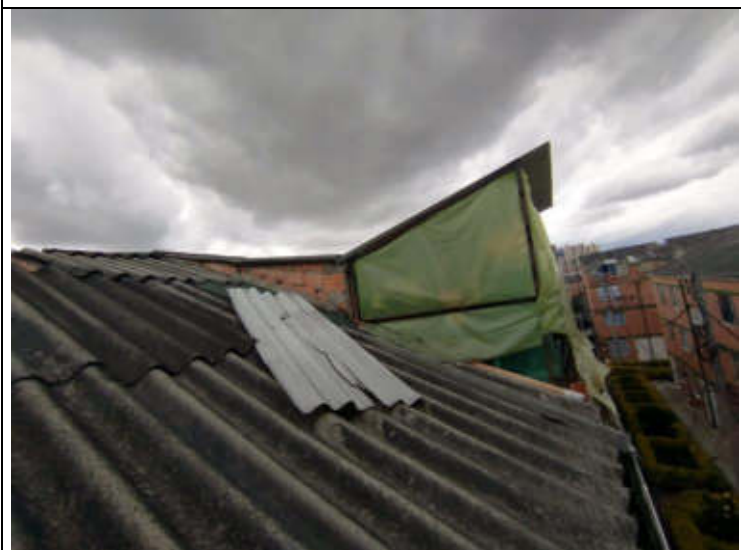
IMAGEN 5. Foto externa de construcción piso 4
