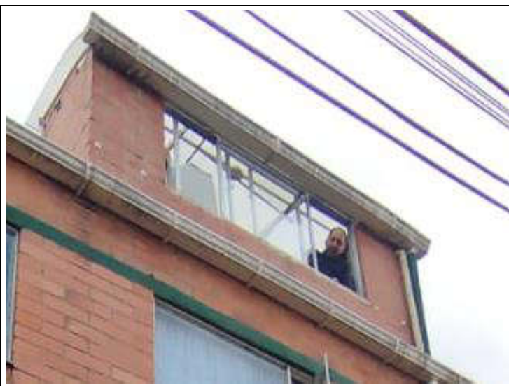
IMAGEN 4. Foto externa de construcción piso 4
