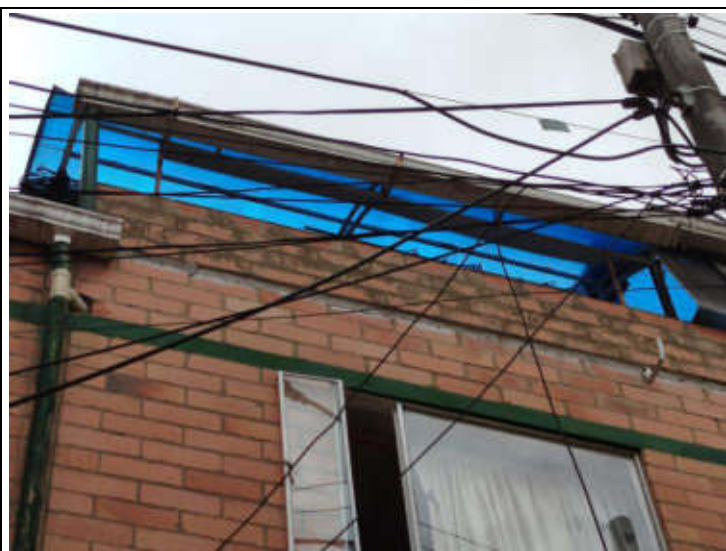
IMAGEN 4. Foto externa de construcción piso 4
