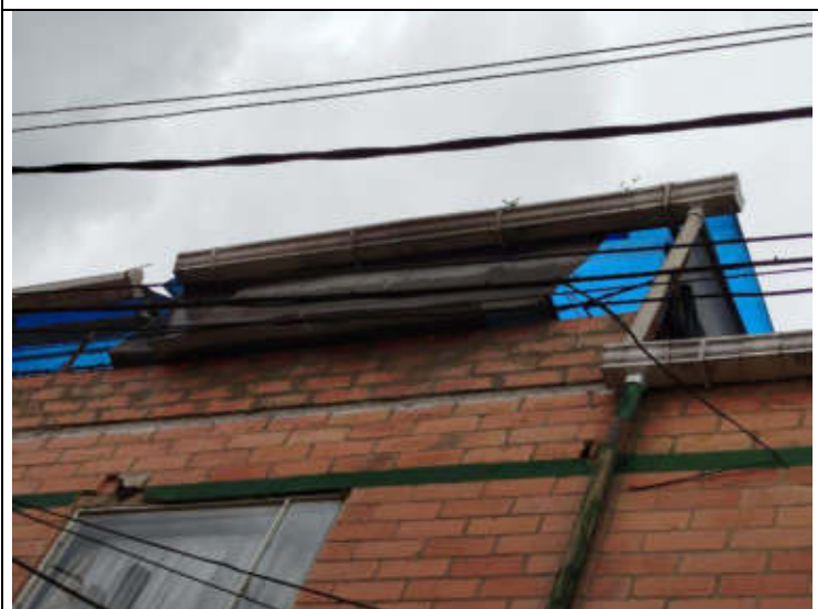
IMAGEN 5. Foto externa de construcción piso 4
