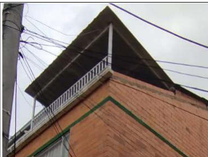
IMAGEN 4. Foto externa de construcción piso 4
