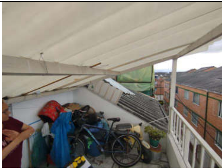
IMAGEN 4. Foto interna de construcción piso 4
