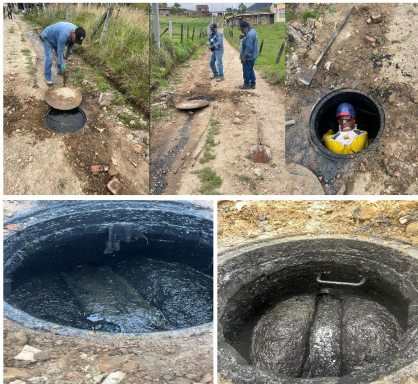
Anexo 4. Visita técnica con la cuadrilla de saneamiento para nivelación de tapas de inspección sistema séptico CAI La Aurora Baja.
