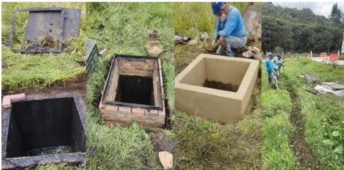
Anexo 5. Informe de visita técnica realizada en atención a la solicitud de inspección por posible afectación por fuga de ARD en red de alcantarillado en El predio El Descanso, sector El Salitre km 10, vía Bogotá–La Calera
