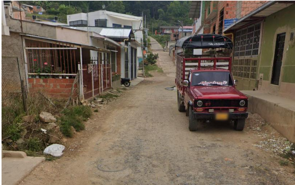
Fotografía 2. Carrera 8 en afirmado
