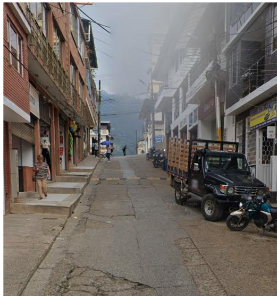
Fotografía 4. Carrera 5 en pavimento deteriorado
