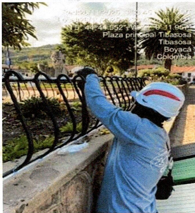
Imagen 17. Registro de instalación de manguera en el parque principal
