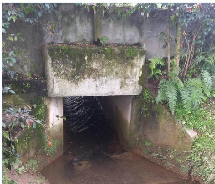
Figura 10. Box culvert 2 al interior del proyecto Coruña Unidad Residencial - P4
