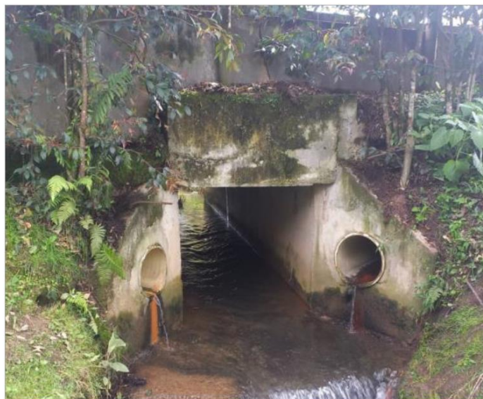
Figura 9. Box culvert 1 al interior del proyecto Coruña Unidad Residencial - P3
