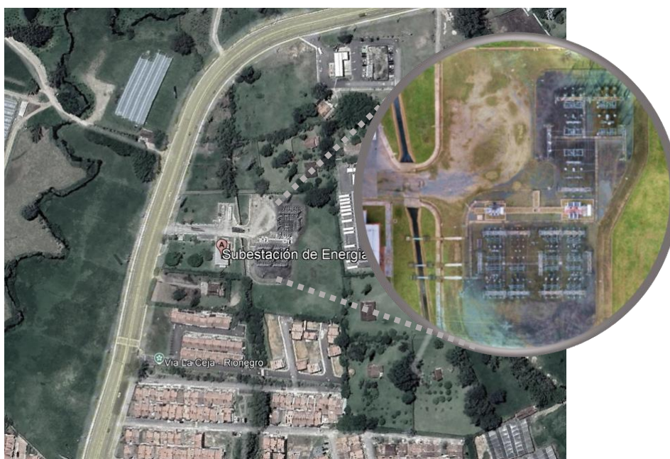
Figura 1. Localización subestación La Ceja.
