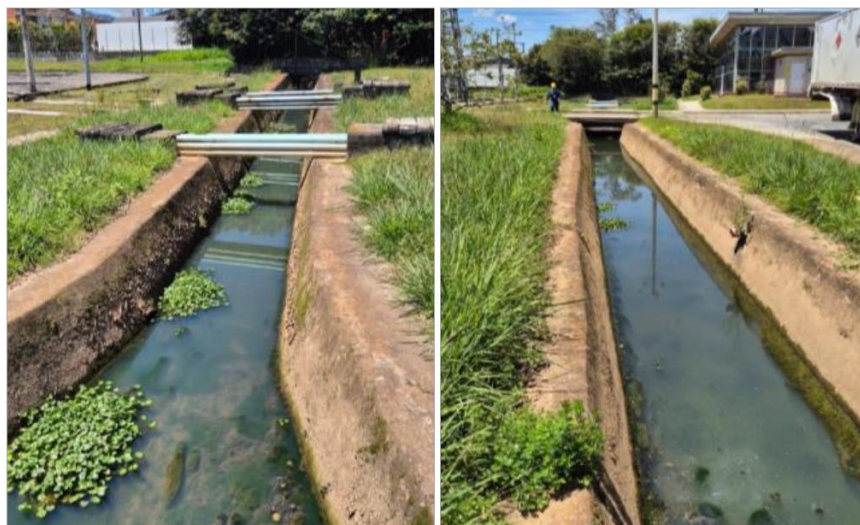
Figura 15. Canal de la quebrada San Joaquín al interior de la Subestación la Ceja – P8
