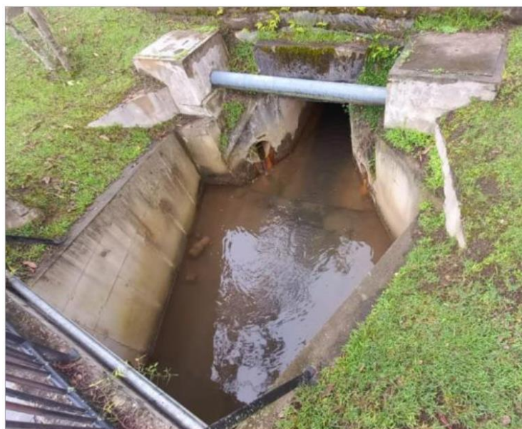
Figura 11. Box culvert 3 al interior del proyecto Coruña Unidad Residencial - P5
