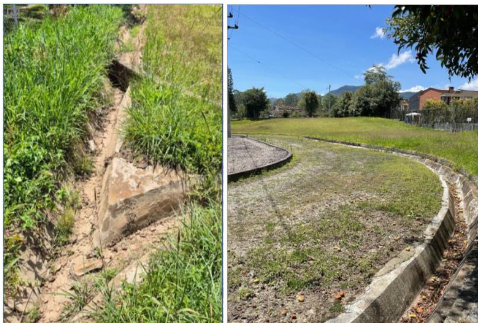
Figura 23. Estado de las obras para el manejo de las aguas de escorrentía al interior de la subestación la Ceja
