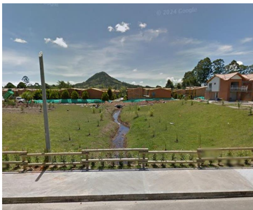
Figura 8. Conformación del cauce de la quebrada San Joaquín en el tramo aledaño a Jardines de la Pradera – P2
