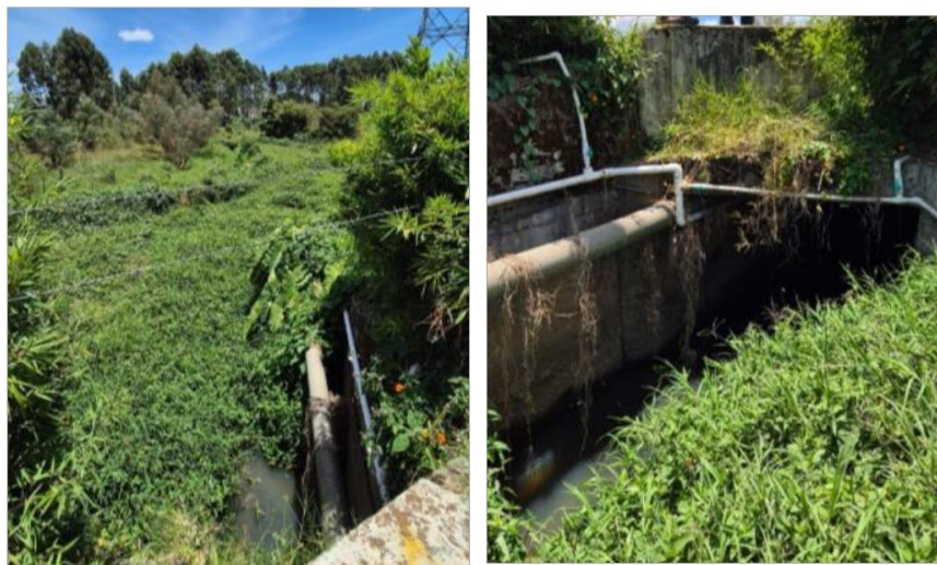
Conformación del cauce a la salida del box culvert de la Vía la Ceja – Rionegro (imagen izquierda) y Salida box culvert la Ceja – Rionegro (imagen derecha)
