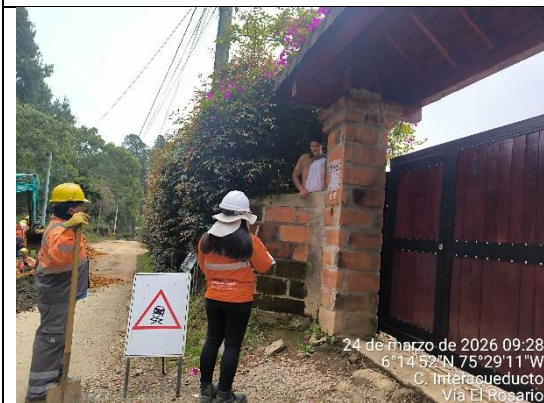
Foto 25 Recorrido del equipo social para identificación de clientes potenciales para el servicio de acueducto de CAPB (Vía El Rosario)
