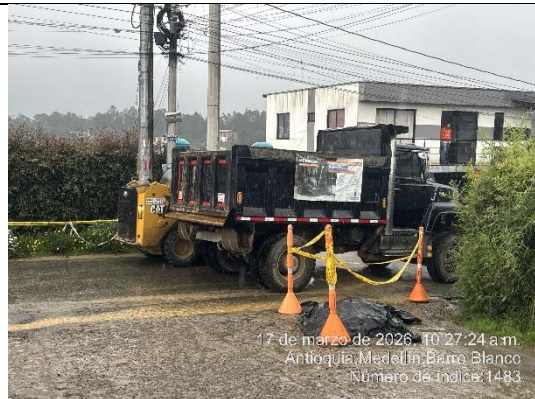
Foto 7 Lona informativa en volqueta en obra
