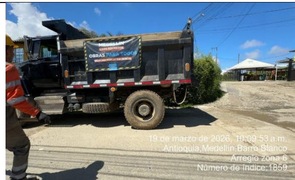
Foto 6 Lona informativa en volqueta en obra
