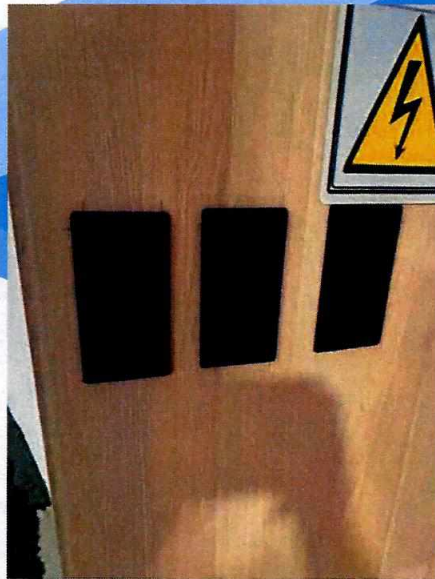
Enchape de pared en lamina de madera RH melamina 15 mm.
