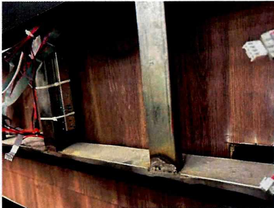
Estructura metálica de soporte pantalla LED.
