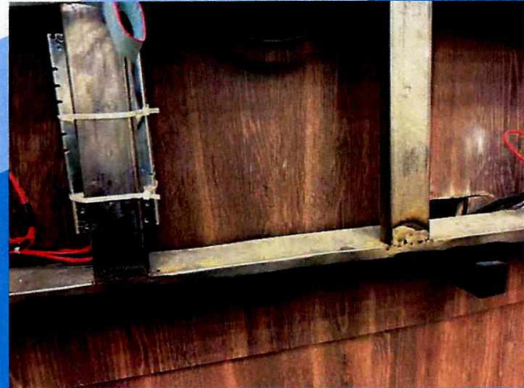
Estructura metálica de soporte pantalla LED.
