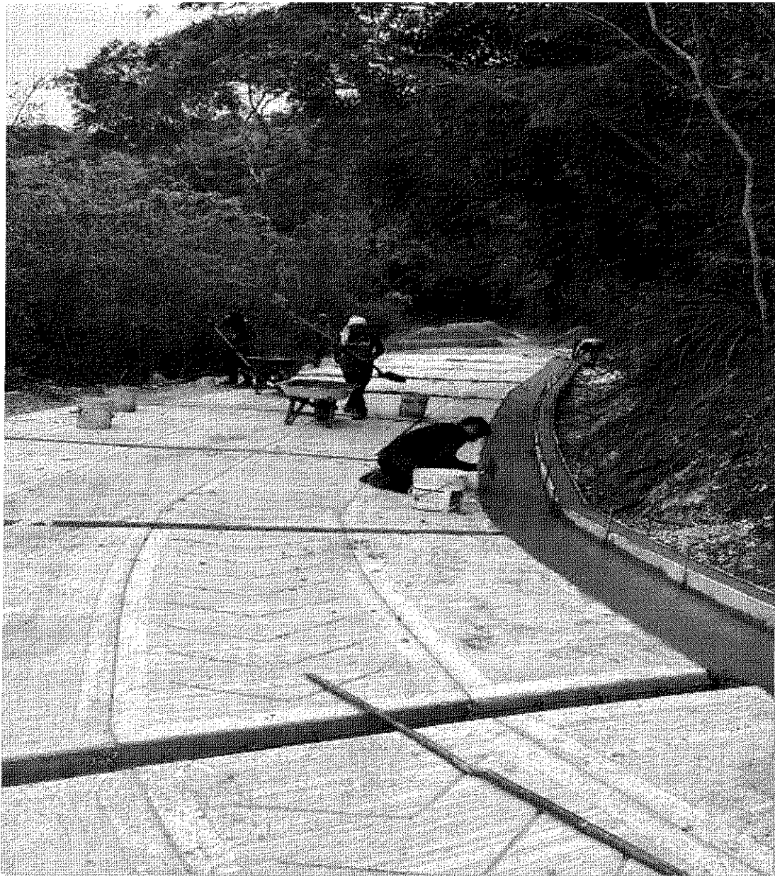
Ilustración 13 Vaciado cunetas con bordillos
