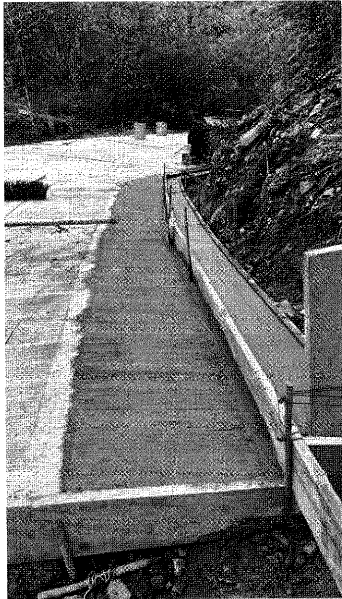
Ilustración 14 Vaciado cunetas con bordillos
