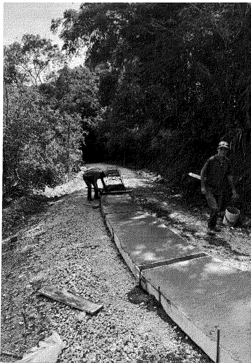
Ilustración 7 Vaciado losa central en ciclópeo
