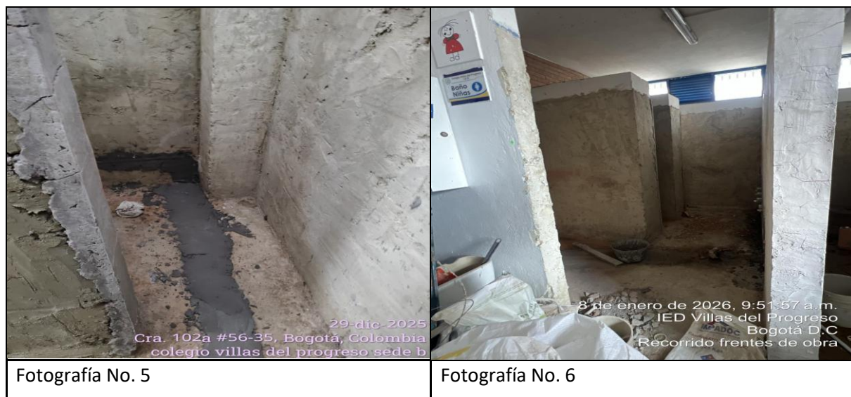
Ilustración 4. Registro fotográfico Villas del Progreso
