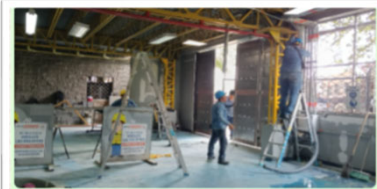
Instalación de coraza
