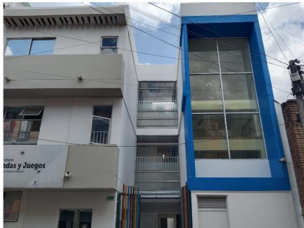
Escalera de emergencia
