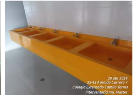
FOTO 3 Y 4: Instalación de grifería tipo push en lavamanos corridos de policarbo.
