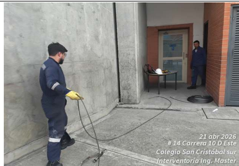
FOTO 3: Sustitución del cable de tracción en ambos equipos de transporte vertical (ascensores), conforme a especificaciones técnicas y condiciones operativas del sistema.
