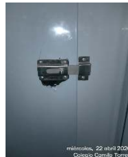
FOTO 9 Y 10: Instalación de divisiones en acero inoxidable y montaje de cerrojos manuales, conforme a especificaciones técnicas y planos aprobados.
