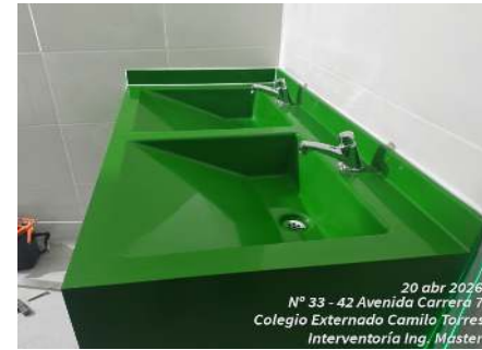
FOTO 3 Y 4: Instalación de grifería tipo push en lavamanos corridos de policarbo.
