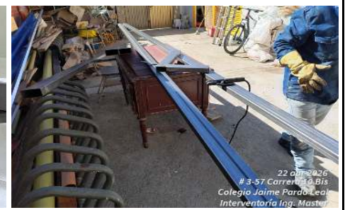
FOTO 3 y 4: Construcción de estructura metálica de soporte para lavamanos, integrada a mesón corrido en policuarzo, conforme a especificaciones técnicas de diseño y requerimientos del proyecto.
