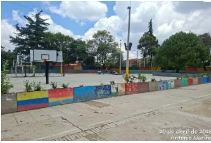
FOTO 5 y 6: Se realiza la ubicación de jardineras de concreto en disposición perimetral y como elemento divisorio entre las dos canchas, conforme a planos de diseño y especificaciones técnicas del proyecto.
