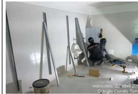
FOTO 11 Y 12: Instalación de divisiones en acero inoxidable y montaje de cerrojos manuales, conforme a especificaciones técnicas y planos aprobados.
