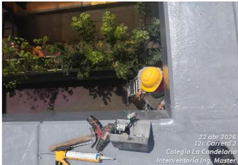
FOTO 1 y 2: Se realiza la reinstalación de luminarias y rejillas previamente desmontadas para la aplicación de poliurea, conforme a especificaciones técnicas y condiciones de operación del sistema impermeable.
