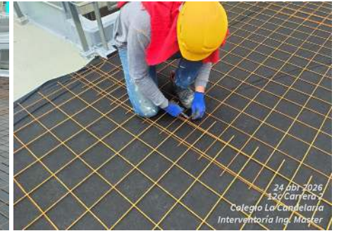
FOTO 7 y 8: Se realiza la instalación de geotextil no tejido (NT) como capa de protección del sistema, así como la colocación de malla electrosoldada para el control de fisuración del alístate, conforme a especificaciones técnicas del proyecto.
