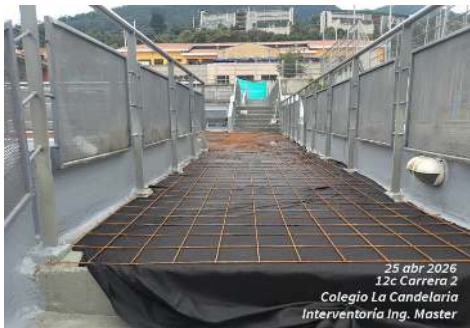
FOTO 5 y 6: Se realiza la instalación de geotextil no tejido (NT) como capa de protección del sistema, así como la colocación de malla electrosoldada para el control de fisuración del alístate, conforme a especificaciones técnicas del proyecto.
