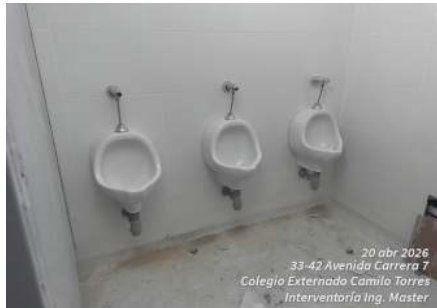
FOTO 5 Y 6: Instalación de aparatos sanitarios (orinales) y divisiones en acero inoxidable, conforme a especificaciones técnicas y planos aprobados.
