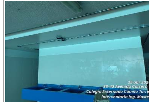
FOTO 15 y 16: Instalación de tubería eléctrica tipo EMT y al tendido de cableado asociado en los baños de los pisos 4°, 3°, 2° y 1°, conforme a especificaciones técnicas y planos eléctricos aprobados.
