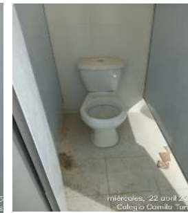
FOTO 7 y 8: Instalación de aparatos sanitarios (inodoros) y divisiones en acero inoxidable, conforme a especificaciones técnicas y planos aprobados.
