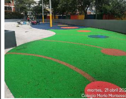
FOTO 3 y 4: Se ejecutan actividades de reparaciones puntuales de fisuras en placa, adicionalmente se continua con la instalación del piso chip.
