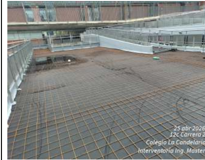
FOTO 7 y 8: Se realiza la instalación de geotextil no tejido (NT) como capa de protección del sistema, así como la colocación de malla electrosoldada para el control de fisuración del alístate, conforme a especificaciones técnicas del proyecto.
