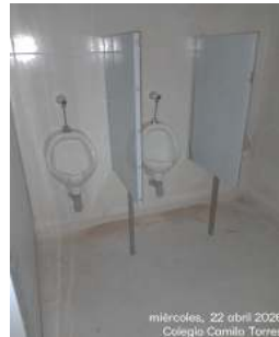
FOTO 5 Y 6: Instalación de aparatos sanitarios (orinales) y divisiones en acero inoxidable, conforme a especificaciones técnicas y planos aprobados.
