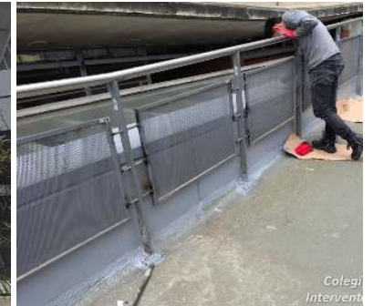
FOTO 3 y 4: Se realiza la reinstalación de luminarias y rejillas previamente desmontadas para la aplicación de poliurea, conforme a especificaciones técnicas y condiciones de operación del sistema impermeable.
