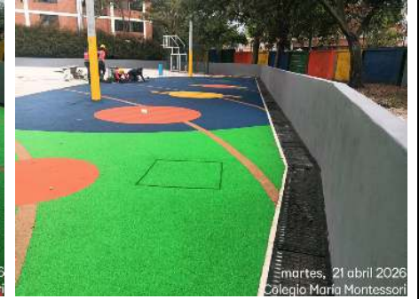
FOTO 3 y 4: Se ejecutan actividades de reparaciones puntuales de fisuras en placa, adicionalmente se continua con la instalación del piso chip.
