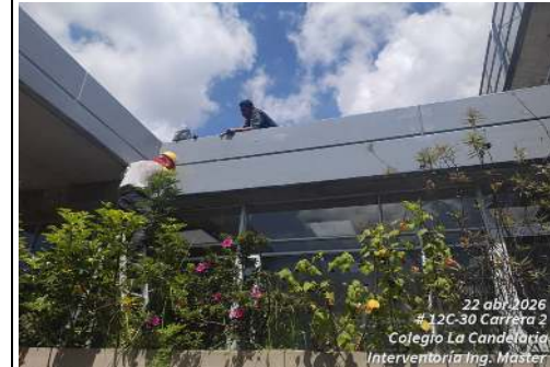
FOTO 3 y 4: Se realiza la reinstalación de luminarias y rejillas previamente desmontadas para la aplicación de poliurea, conforme a especificaciones técnicas y condiciones de operación del sistema impermeable.
