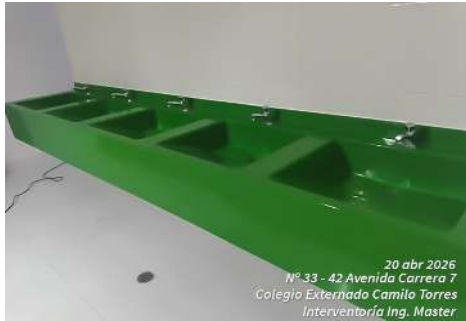
FOTO 1 Y 2: Instalación de grifería tipo push en lavamanos corridos de policarbo.
