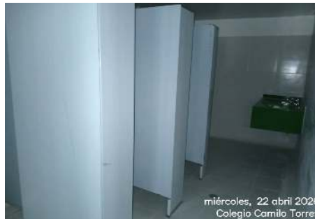
FOTO 9 Y 10: Instalación de divisiones en acero inoxidable y montaje de cerrojos manuales, conforme a especificaciones técnicas y planos aprobados.
