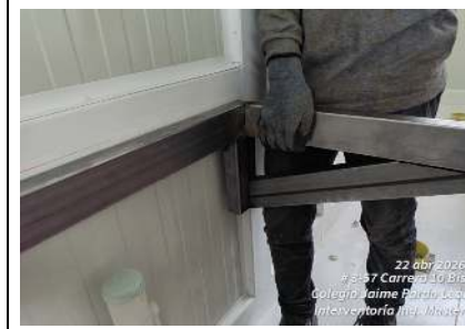
FOTO 3 y 4: Construcción de estructura metálica de soporte para lavamanos, integrada a mesón corrido en policuarzo, conforme a especificaciones técnicas de diseño y requerimientos del proyecto.
