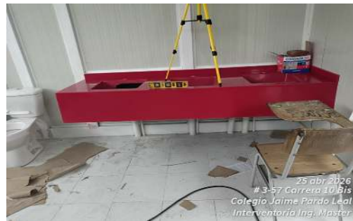
FOTO 5 y 6: Construcción de estructura metálica de soporte para lavamanos, integrada a mesón corrido en policuarzo, conforme a especificaciones técnicas de diseño y requerimientos del proyecto.
