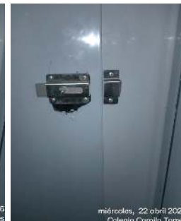
FOTO 9 Y 10: Instalación de divisiones en acero inoxidable y montaje de cerrojos manuales, conforme a especificaciones técnicas y planos aprobados.
