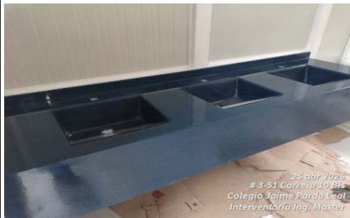
FOTO 5 y 6: Construcción de estructura metálica de soporte para lavamanos, integrada a mesón corrido en policuarzo, conforme a especificaciones técnicas de diseño y requerimientos del proyecto.
