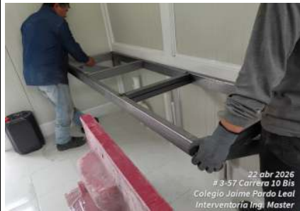
FOTO 1 y 2: Construcción de estructura metálica de soporte para lavamanos, integrada a mesón corrido en policuarzo, conforme a especificaciones técnicas de diseño y requerimientos del proyecto.
