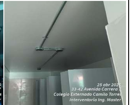
FOTO 15 y 16: Instalación de tubería eléctrica tipo EMT y al tendido de cableado asociado en los baños de los pisos 4°, 3°, 2° y 1°, conforme a especificaciones técnicas y planos eléctricos aprobados.
