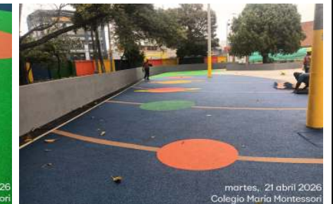
FOTO 7 y 8: Se ejecutan actividades de reparaciones puntuales de fisuras en placa, adicionalmente se continua con la instalación del piso chip.
