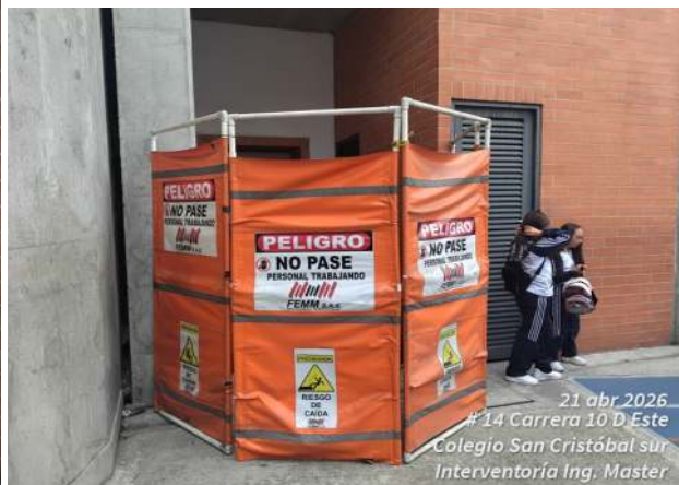
FOTO 1 y 2: Ceramientos de las zonas intervenidas.
