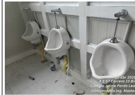
FOTO 7 y 8: Instalación de aparatos sanitarios en baños modulares, incluyendo unidades sanitarias (inodoros) y orinales, conforme a especificaciones técnicas y planos aprobados.
