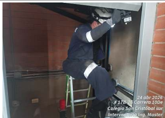
FOTO 13 y 14: Ejecución de actividades de intervención integral y mantenimiento de sistemas de transporte vertical (ascensores).
