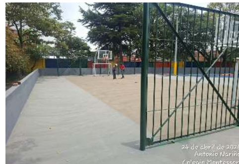
FOTO 9 y 10: Actividades de aplicación de capa de recibase sobre la totalidad de la superficie previamente conformada; adicionalmente, se realiza el refuerzo del sistema con recibase en la zona correspondiente a la cancha multifuncional.
