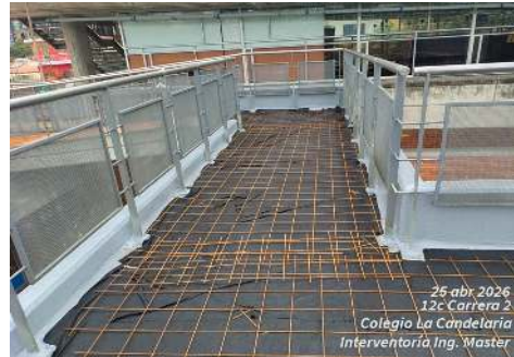
FOTO 5 y 6: Se realiza la instalación de geotextil no tejido (NT) como capa de protección del sistema, así como la colocación de malla electrosoldada para el control de fisuración del alístate, conforme a especificaciones técnicas del proyecto.
