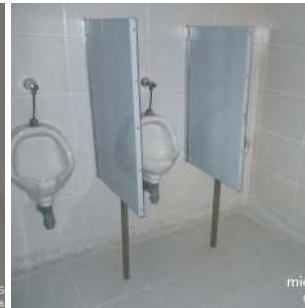
FOTO 5 Y 6: Instalación de aparatos sanitarios (orinales) y divisiones en acero inoxidable, conforme a especificaciones técnicas y planos aprobados.
