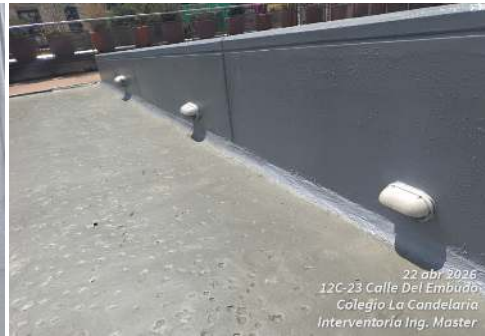
FOTO 1 y 2: Se realiza la reinstalación de luminarias y rejillas previamente desmontadas para la aplicación de poliurea, conforme a especificaciones técnicas y condiciones de operación del sistema impermeable.
