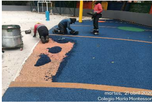
FOTO 1 y 2: Se ejecutan actividades de reparaciones puntuales de fisuras en placa, adicionalmente se continua con la instalación del piso chip.
