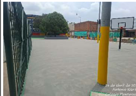
FOTO 11 y 12: Actividades de aplicación de capa de recibase sobre la totalidad de la superficie previamente conformada; adicionalmente, se realiza el refuerzo del sistema con recibase en la zona correspondiente a la cancha multifuncional.
