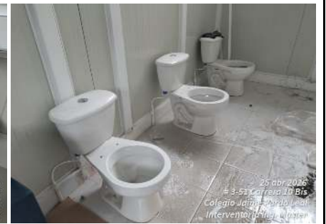
FOTO 7 y 8: Instalación de aparatos sanitarios en baños modulares, incluyendo unidades sanitarias (inodoros) y orinales, conforme a especificaciones técnicas y planos aprobados.
