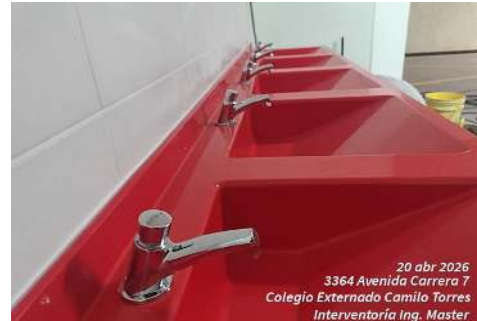
FOTO 1 Y 2: Instalación de grifería tipo push en lavamanos corridos de policarbo.
