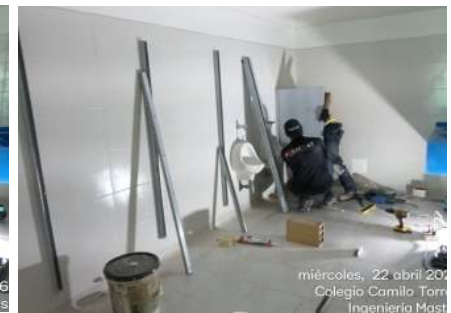
FOTO 11 Y 12: Instalación de divisiones en acero inoxidable y montaje de cerrojos manuales, conforme a especificaciones técnicas y planos aprobados.
