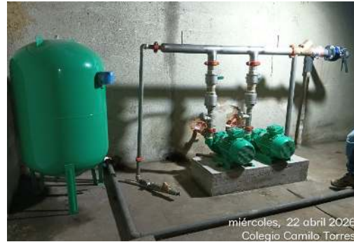
FOTO 13 Y 14: Armado y construcción de sistemas de bombeo para la alimentación de tanque de agua potable, conforme a especificaciones técnicas, planos hidráulicos y requerimientos operativos del proyecto.
