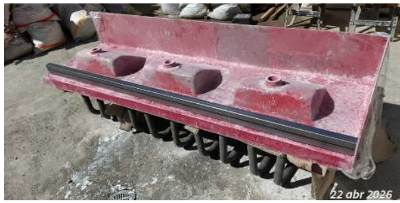
FOTO 1 y 2: Construcción de estructura metálica de soporte para lavamanos, integrada a mesón corrido en policuarzo, conforme a especificaciones técnicas de diseño y requerimientos del proyecto.
