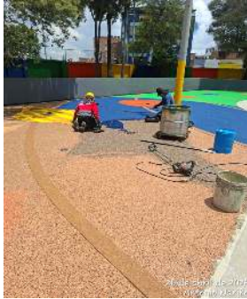
FOTO 1 y 2: Se ejecutan actividades de reparaciones puntuales de fisuras en placa, adicionalmente se continua con la instalación del piso chip.
