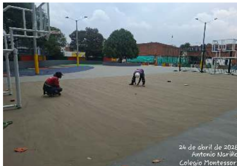
FOTO 9 y 10: Actividades de aplicación de capa de recibase sobre la totalidad de la superficie previamente conformada; adicionalmente, se realiza el refuerzo del sistema con recibase en la zona correspondiente a la cancha multifuncional.
