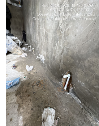
FOTO 2: Instalación de tubería de agua potable - Colegio Republica Federal Alemania
