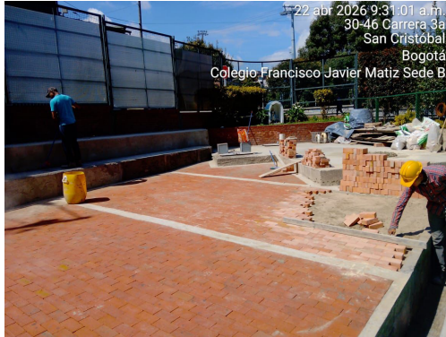
FOTO 1: Instalación de adoquín - Javier Matiz B
