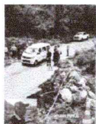
AVANZA EN UN 60% OBRA EN LA VÍA EL MORRO
