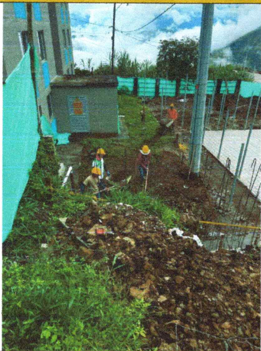
Limpieza entre la caja CJ02 Y CJ06
