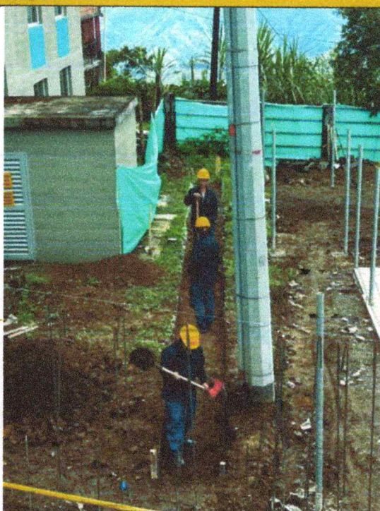
Excavación entre la caja CJ02 Y CJ06
