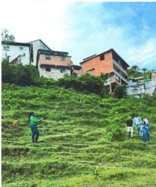
Recorrido de sitio de obra
