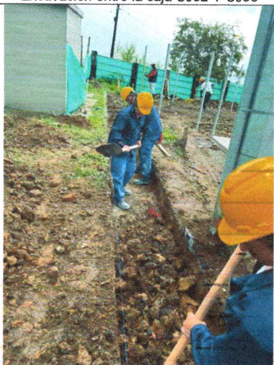
Excavación entre la caja CJ02 Y CJ06
