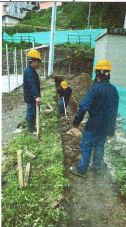
Excavación entre la caja CJ02 Y CJ06
