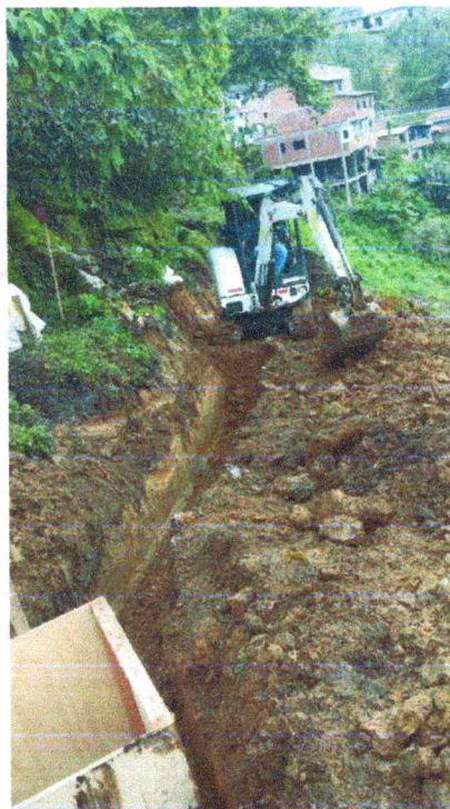
Excavación entre la CJ012 A LA CJ014
