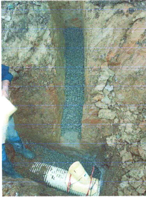
Instalación de triturado y SILLA YEE Triturado entre la caja CJ12 ALA CJ14
