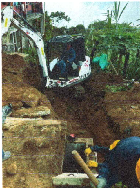
Inspección de caja Domiciliar DM1 entre caja CJ06 AL CJ 08
