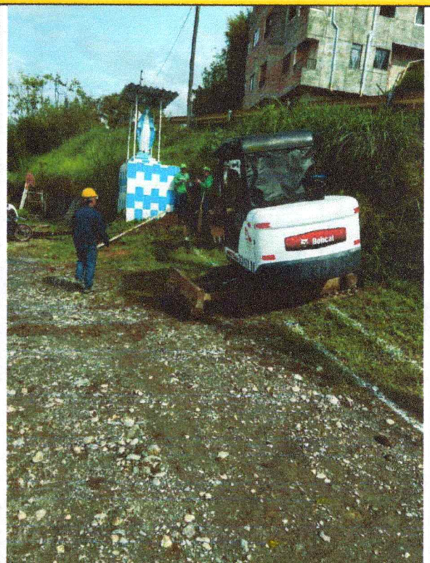
se inicia con la excavación entre la caja CJ45B2 ALA CJ 01
