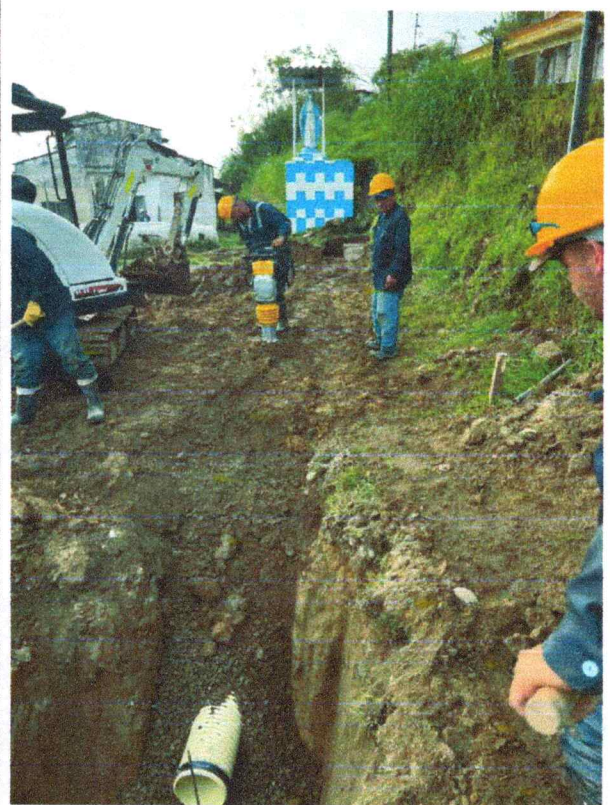
Lleno de excavación con material de excavación CJ45b2 ala CJ01
