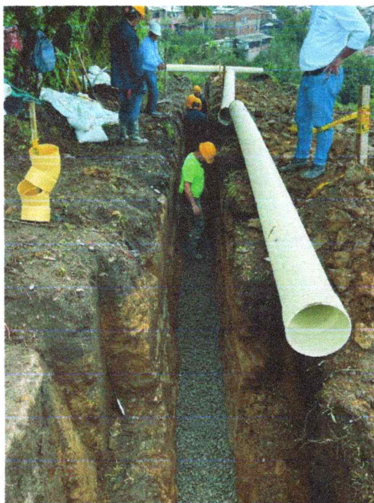
Instalación de Triturado entre la caja CJ010 A LA CJ012
