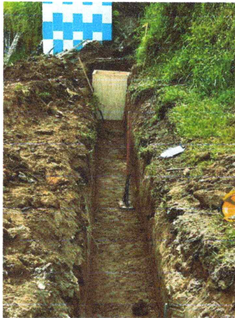
excavación entre la caja CJ45B2 ALA CJ01
