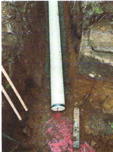
Prueba de Hidráulica caja entre la CJ08 A LA CJ010
