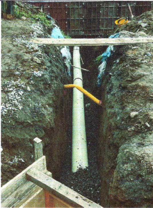
Instalación de tubería de 10" y triturado entre la caja CJ01 ALA CJ 02
