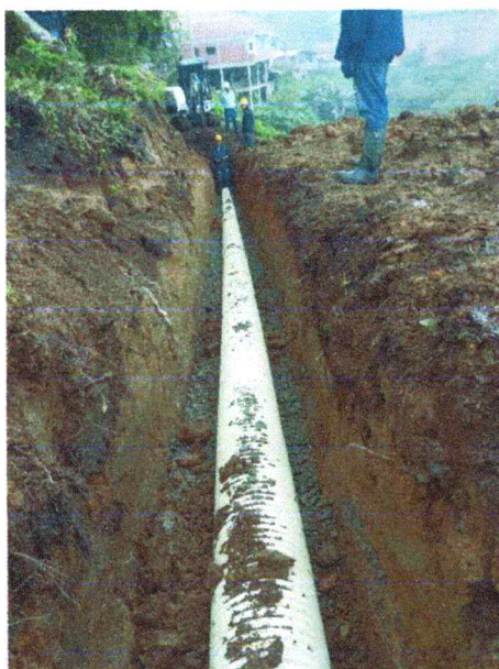
Instalación de Triturado entre la caja CJ12 ALA CJ14 Y TUBERIA de 10"
