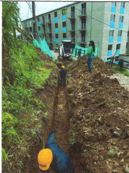
Excavación mecánica excavación con material de excavación CJ45b2 ala CJ01
