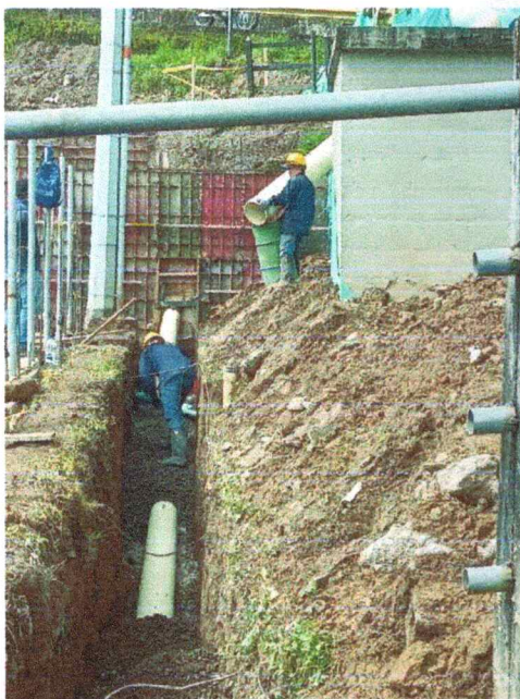
Instalación de Triturado entre la caja CJ02 ALA CJ06
