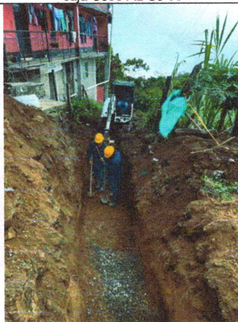
Instalación de tubería Domiciliar de 6" entre caja CJ06 AL CJ 08
