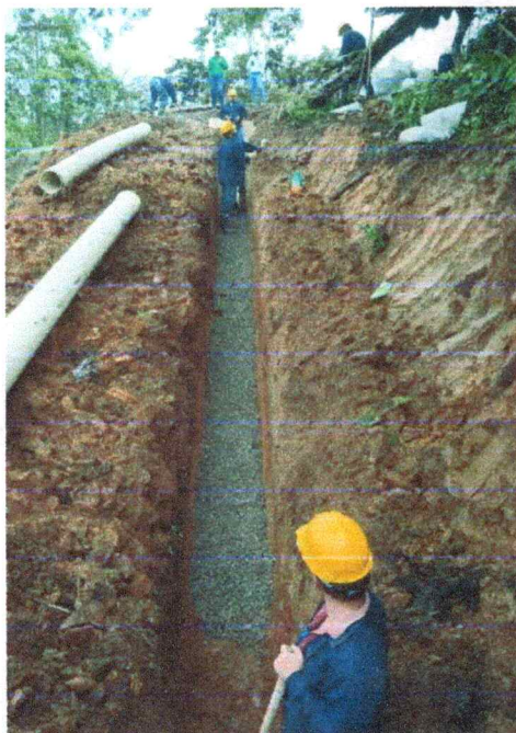
Instalación de Triturado entre la caja CJ010 A LA CJ012
