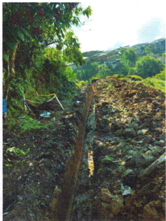
Excavación entre la CJ010 A LA CJ012
