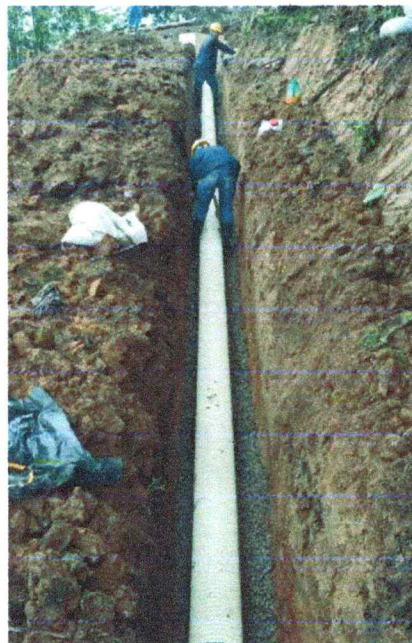
Instalación de Triturado entre la caja CJ010 A LA CJ012 y tubería de 10"
