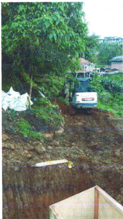
Excavación entre la CJ012 A LA CJ014
