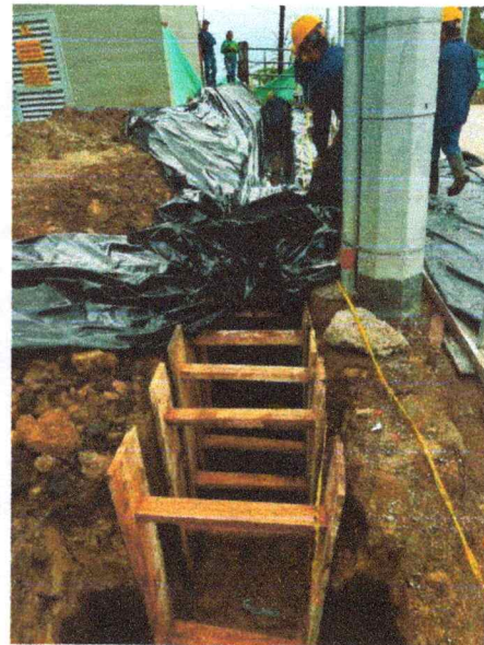
Entibado entre la caja CJ02 ALA CJ06
