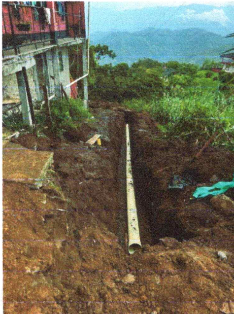
Instalación de Triturado entre la caja entre la CJ08 A LA CJ010 Y TUBERIA de 10"
