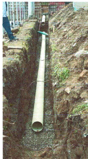
Instalación de Triturado entre la caja CJ02 ALA CJ06 Y TUBERIA de 10"
