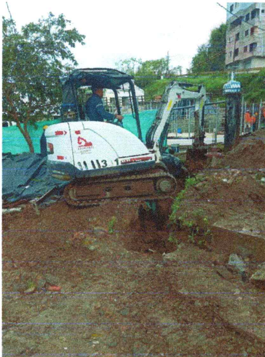
Excavación entre la caja CJ06 AL CJ08
