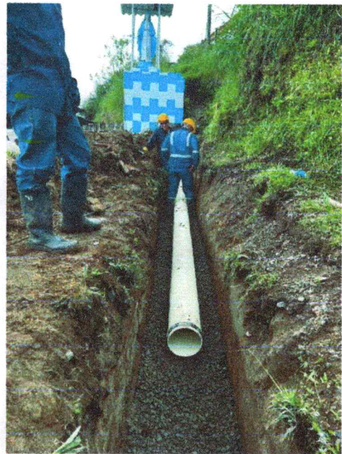
Intalacion de Triturado y Tubería 10"
