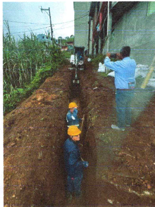
Excavación entre la CJ08 A LA CJ010
