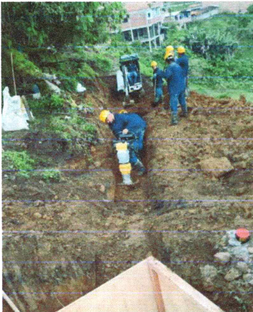
Compactación Mecánica entre la caja CJ12 ALA CJ14
