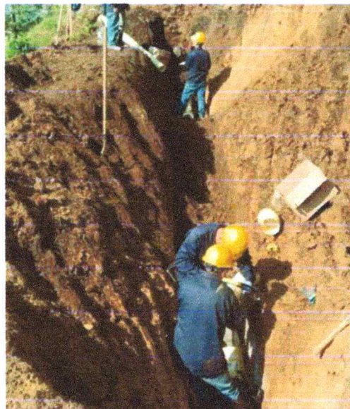
Instalación de SILLA YEE entre la caja CJ14 ALA CJ574 Y TUBERIA de 6"
