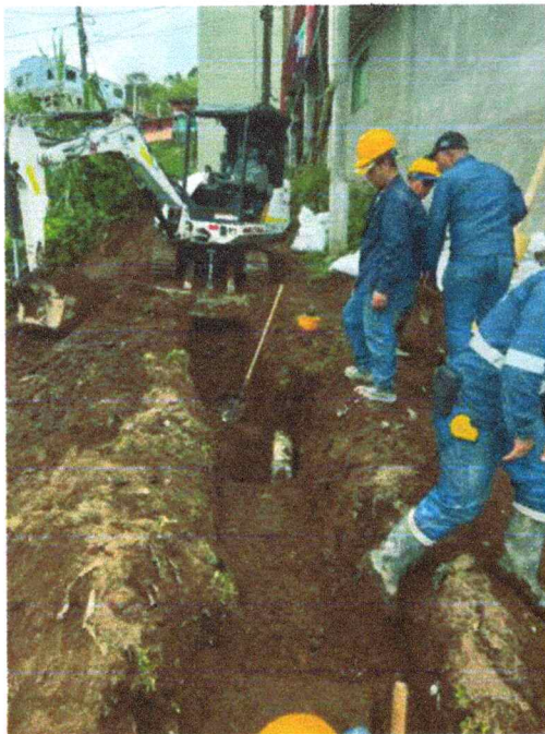
Excavación entre la CJ08 A LA CJ010
