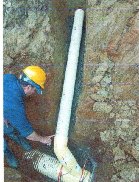
Instalación de ntre la caja CJ12 ALA CJ14 Y TUBERIA de 6"
