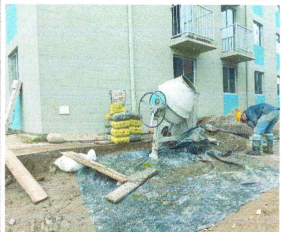
Protección del área de trabajo.
