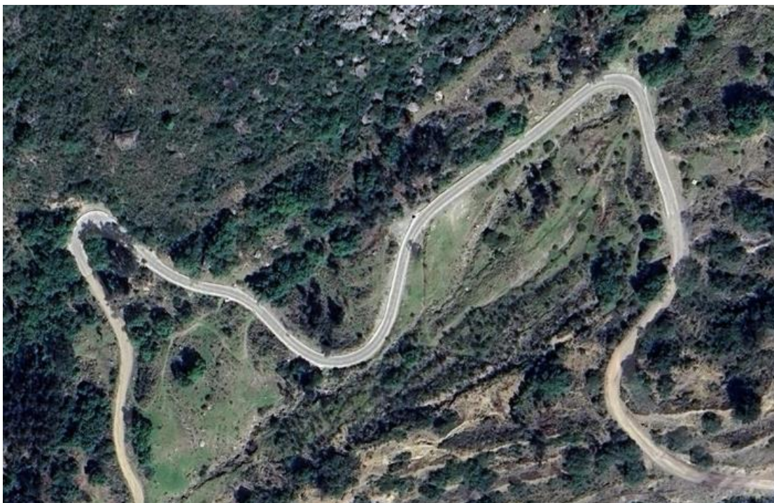
Vista área general del tramo de placa huella construida
