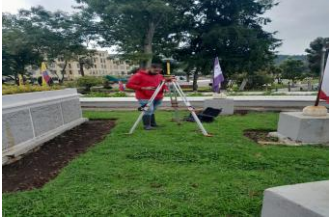
Inicio levantamiento topográfico
