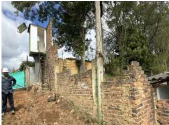
Estructuras a demoler tramo #1
