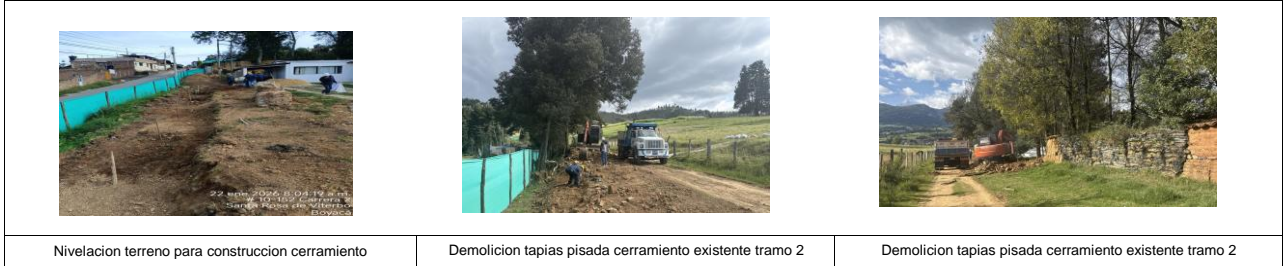
Nivelacion terreno para construccion cerramiento
