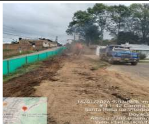
Demolición cerramiento existente tramo #1
