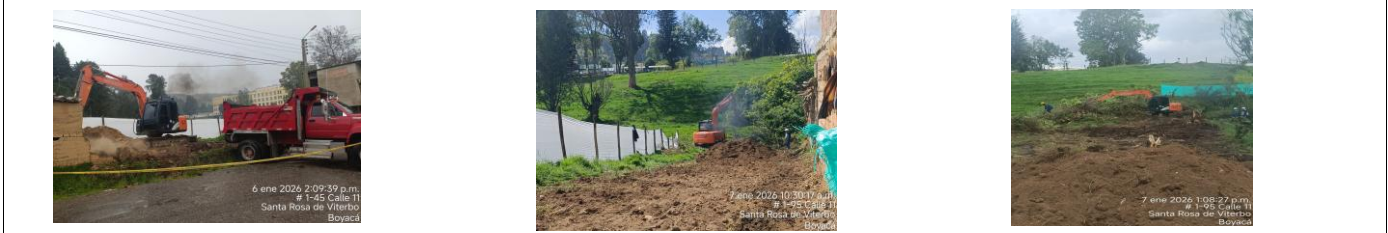
Demolición muro existente
