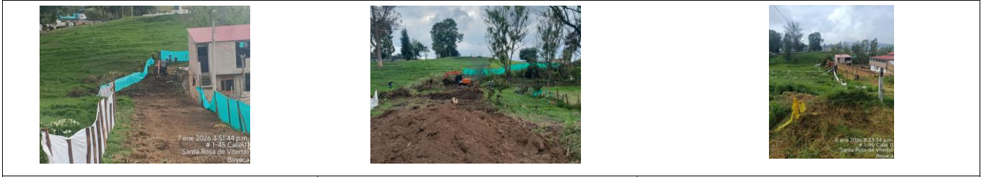
Descapote mecánico
