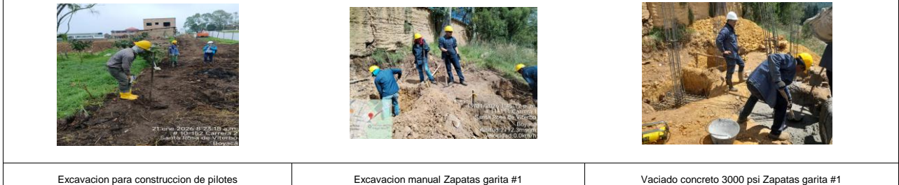
Excavacion para construccion de pilotes
