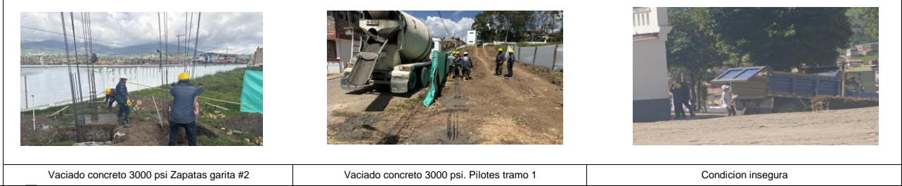
Vaciado concreto 3000 psi Zapatas garita #2
