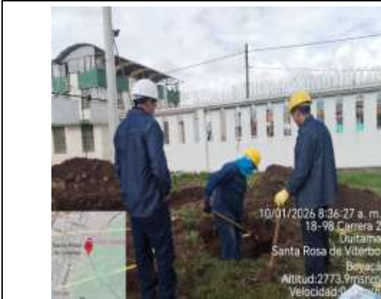
Excavación manual para construcción zapatas G1
