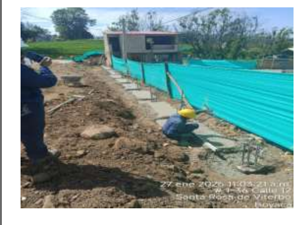
Instalación concreto de limpieza Tramo #1
