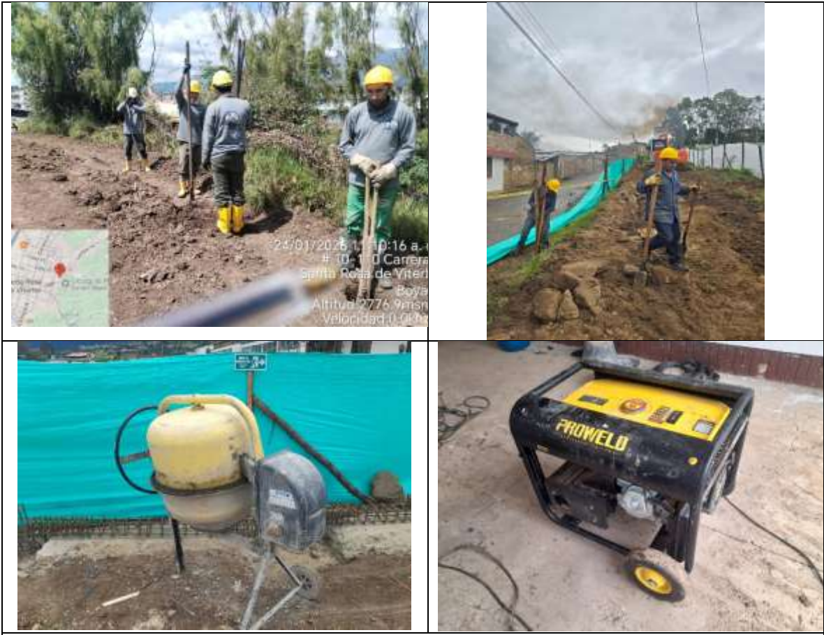
Uso de herramientas manuales para instalación de cerramiento en obra.
