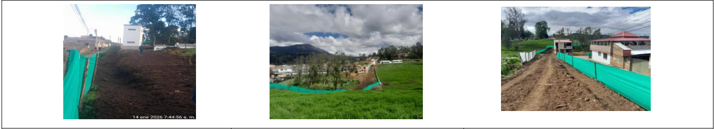
Descapote mecánico
