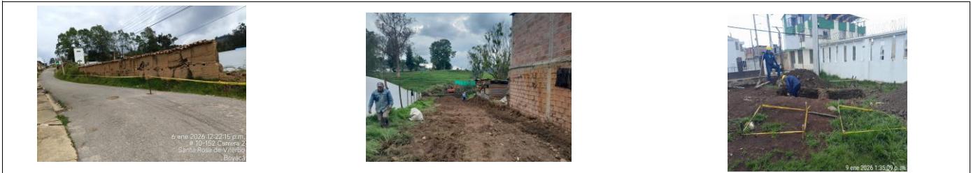
Construcción del cerramiento provisional
