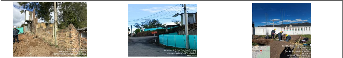
Demolición construcciones existentes
