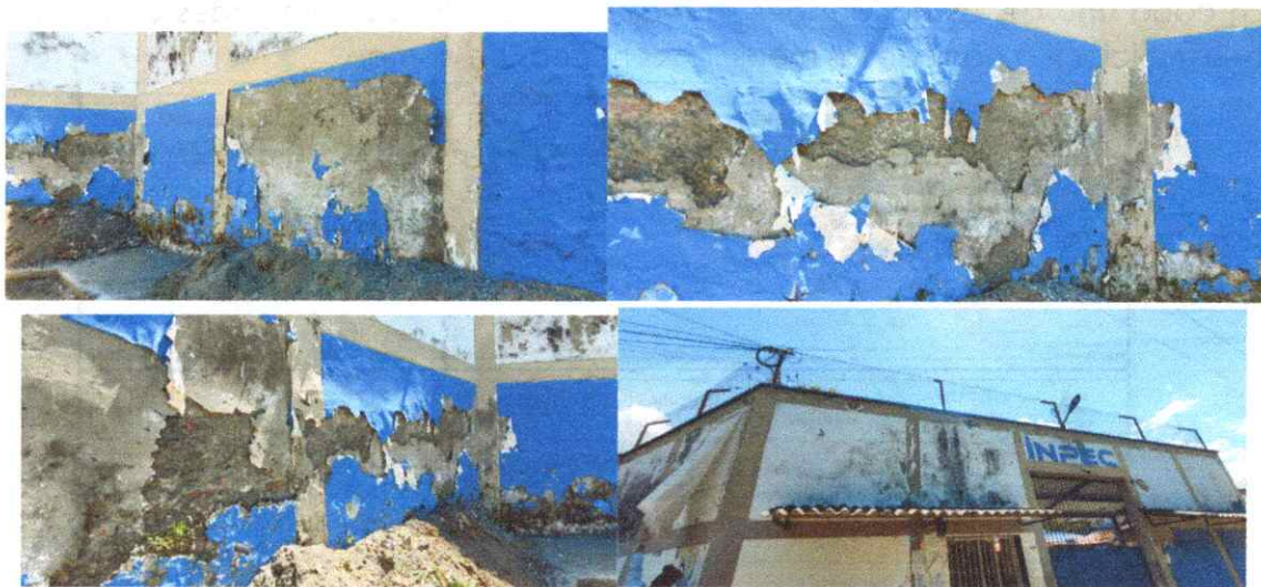
Figura 5. Estado actual del proyecto antes de intervención.
