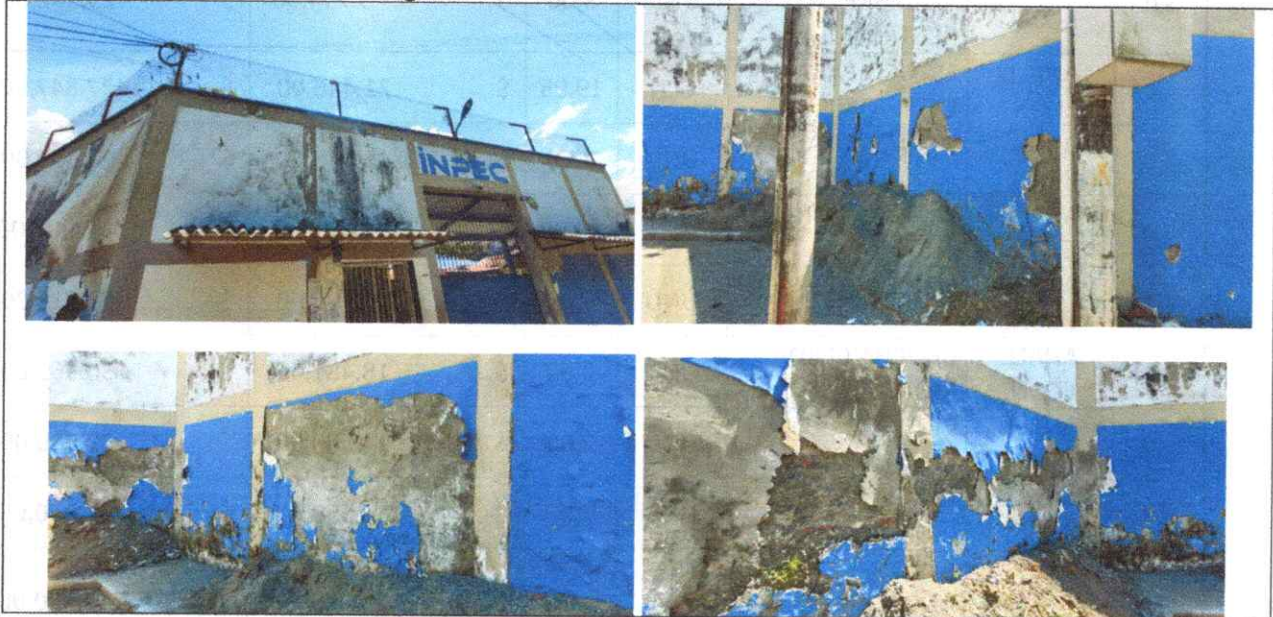
Figura 1. Situación actual de la fachada.
